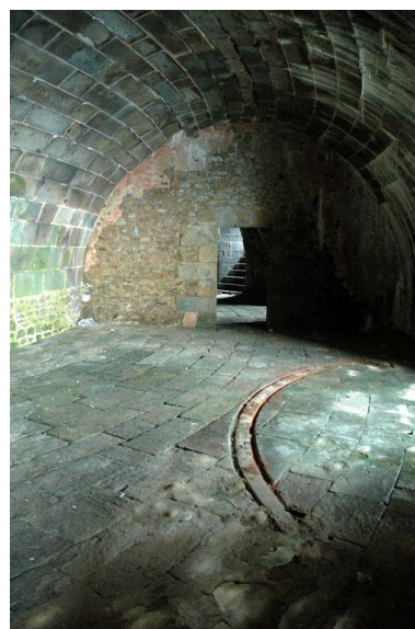
Vue du fort de la Conchée : casemate (n° 2) dit souterrain à deux embrasures Phot. Guillaume Lécueillier IVR53_20063517560NUCA
