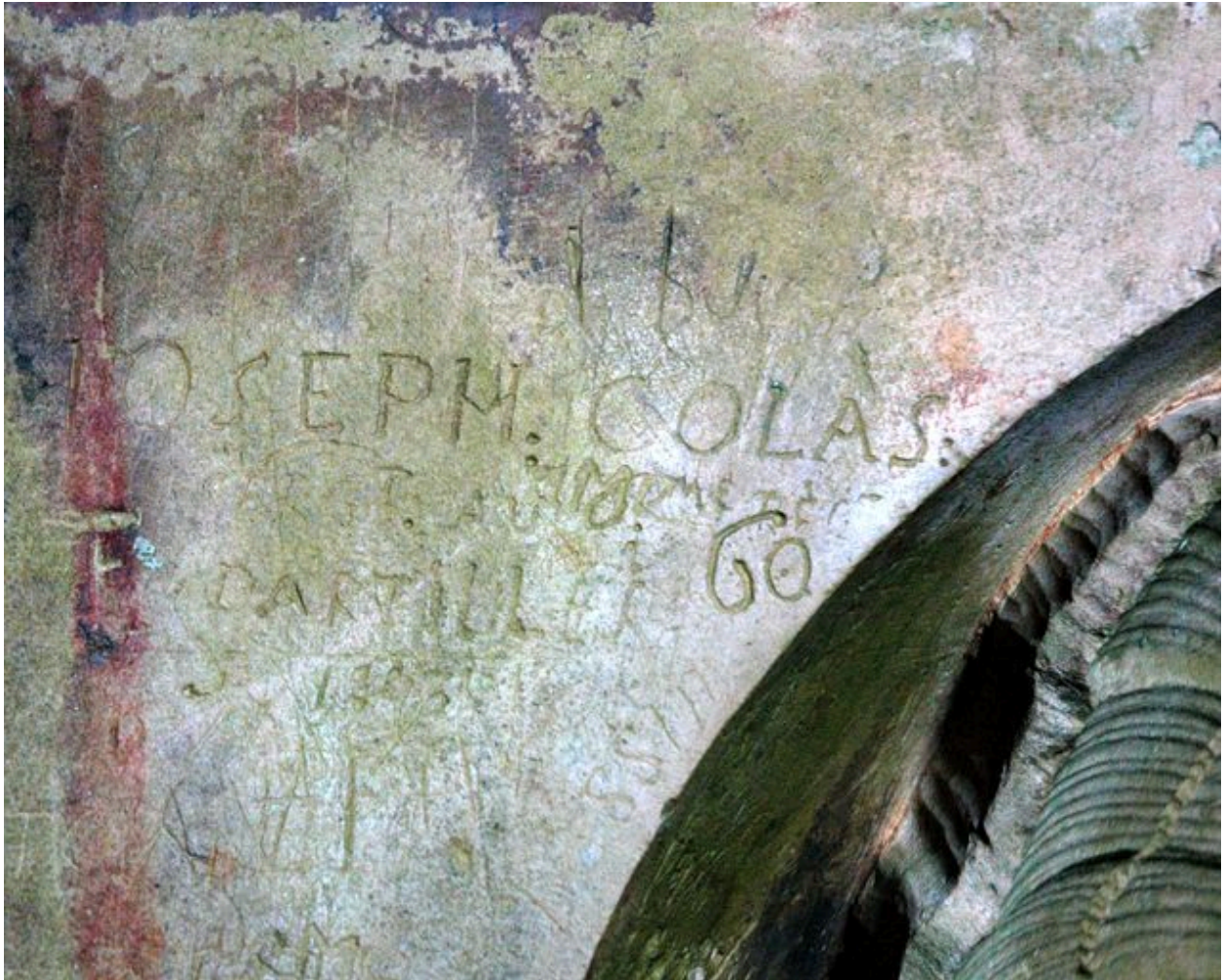
Vue du fort de la Conchée : graffiti de la fontaine
