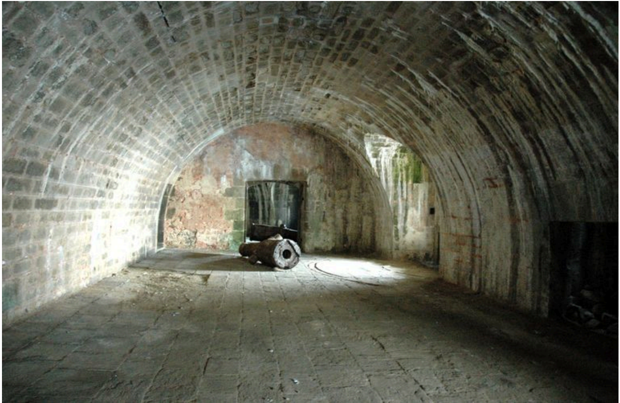
Vue du fort de la Conchée : casemate (n° 1) dit souterrain à deux embrasures. Tube de canon (b) à chargement par la culasse.
