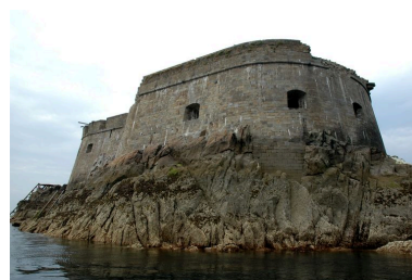
Vue générale du fort de la Conchée Phot. Guillaume Lécueillier IVR53_20063517543NUCA
