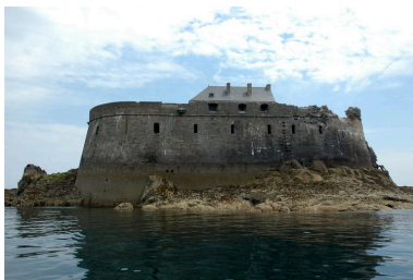
Vue générale du fort de la Conchée Phot. Guillaume Lécueillier IVR53_20063517531NUCA
