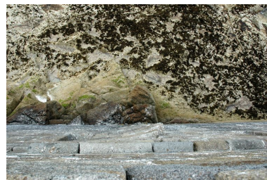
Vue du fort de la Conchée : rempart côté ouest, repentir du projet d'agrandissement (pierres en attente) Phot. Guillaume Lécueillier IVR53_20063517592NUCA
