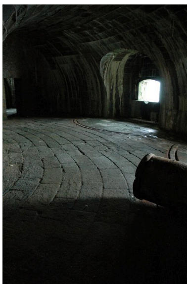
Vue du fort de la Conchée : casemate (n° 2) dit souterrain à deux embrasures. Tube de canon (c) à chargement par la culasse. Phot. Guillaume Lécueillier IVR53_20063517559NUCA
