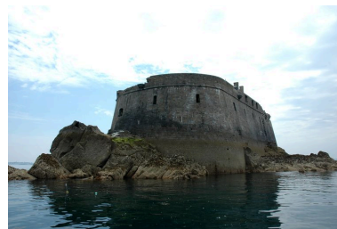
Vue générale du fort de la Conchée Phot. Guillaume Lécueillier IVR53_20063517535NUCA
