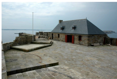
Vue du fort de la Conchée : logis de la terrasse et plate- forme d'artillerie (batterie haute) Phot. Guillaume Lécueillier IVR53_20063517574NUCA
