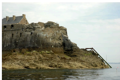
Vue générale du fort de la Conchée Phot. Guillaume Lécueillier IVR53_20063517545NUCA
