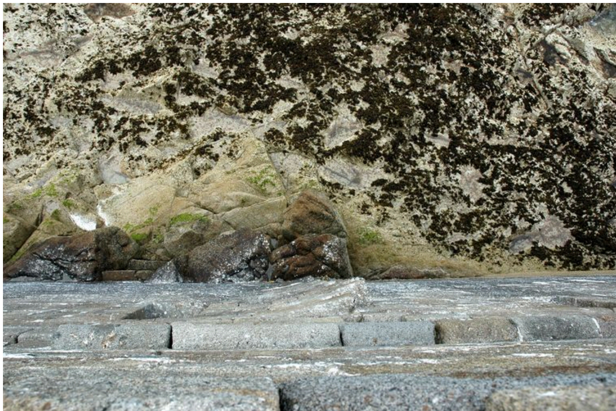
Vue du fort de la Conchée : rempart côté ouest, repentir du projet d'agrandissement (pierres en attente)
