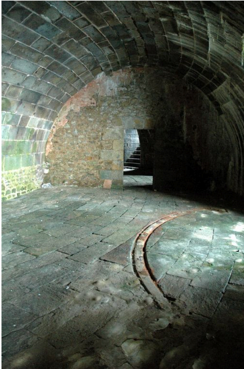
Vue du fort de la Conchée : casemate (n° 2) dit souterrain à deux embrasures
