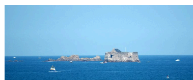
Vue de situation du fort de la Conchée Phot. Guillaume Lécueillier IVR53_20043511558NUCA
