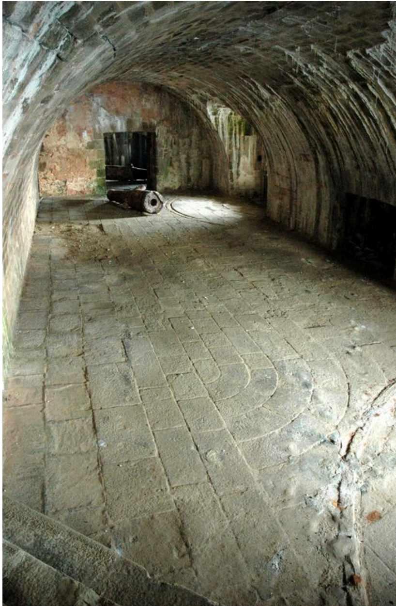
Vue du fort de la Conchée : casemate (n° 1) dit souterrain à deux embrasures. Tube de canon (b) à chargement par la culasse.
