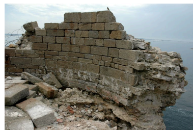
Vue du fort de la Conchée : parapet sud et dallage de la terrasse en cours de restauration Phot. Guillaume Lécueillier IVR53_20063517597NUCA
