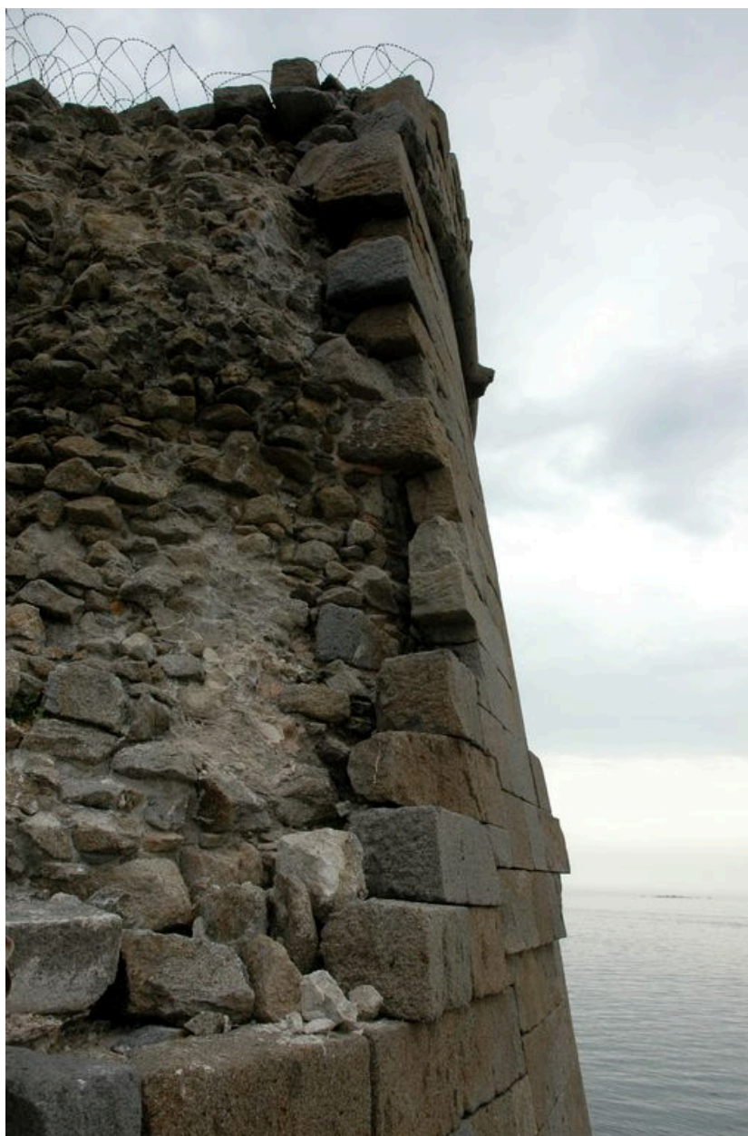
Vue du fort de la Conchée : détail du rempart à l'est de l'entrée
