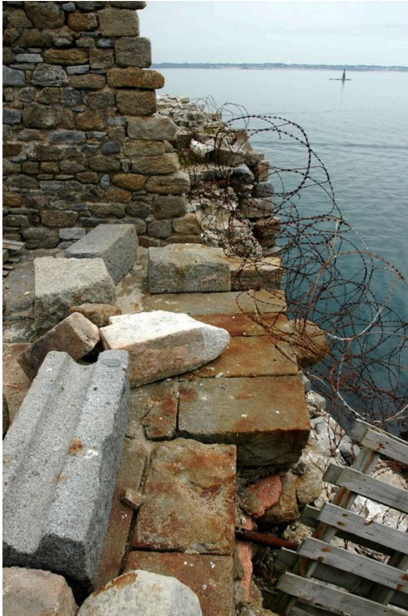
Vue du fort de la Conchée : parapet sud et dallage de la terrasse en cours de restauration
