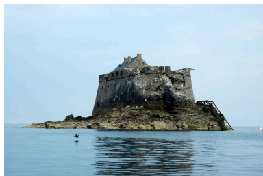
Vue générale du fort de la Conchée Phot. Guillaume Lécueillier IVR53_20063517529NUCA
