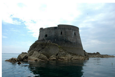
Vue générale du fort de la Conchée Phot. Guillaume Lécueillier IVR53_20063517536NUCA
