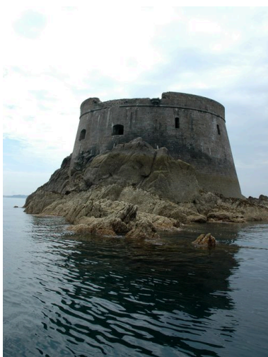
Vue générale du fort de la Conchée Phot. Guillaume Lécueillier IVR53_20063517537NUCA
