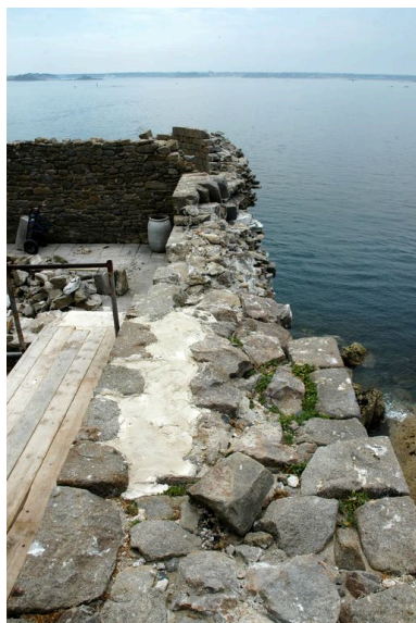
Vue du fort de la Conchée : logis de la terrasse en cours de restauration Phot. Guillaume Lécueillier IVR53_20063517593NUCA
