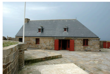
Vue du fort de la Conchée : logis de la terrasse et plate- forme d'artillerie (batterie haute) Phot. Guillaume Lécueillier IVR53_20063517575NUCA
