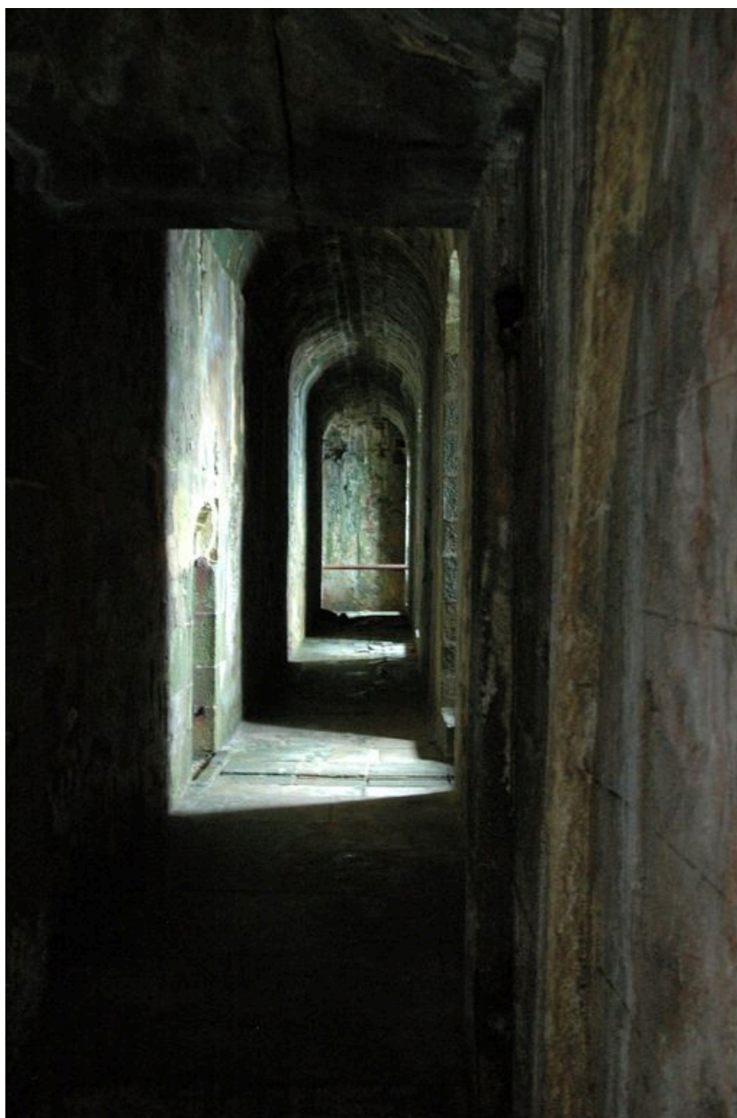
Vue du fort de la Conchée : couloir voûté de la fontaine
