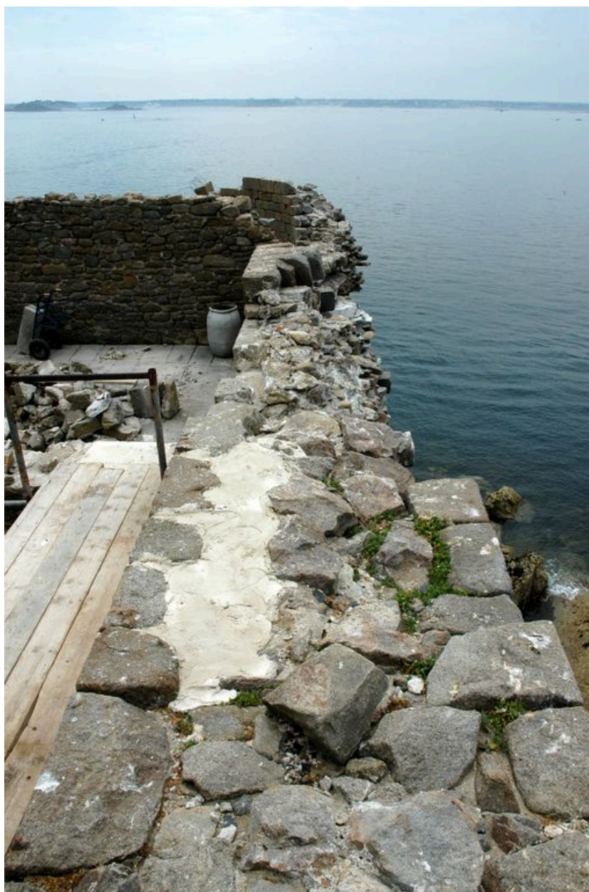
Vue du fort de la Conchée : logis de la terrasse en cours de restauration
