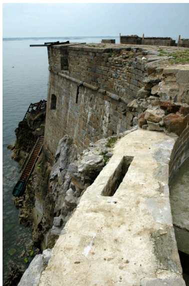
Vue du fort de la Conchée : parapet de la plate-forme d'artillerie (batterie haute). Au premier plan : évent d'aération d'une des casemates Phot. Guillaume Lécueillier IVR53_20063517603NUCA
