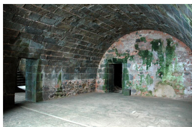
Vue du fort de la Conchée : chapelle dit souterrain doté d'une baie Phot. Guillaume Lécueillier IVR53_20063517564NUCA
