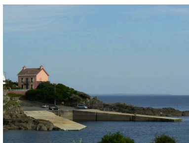
Vue d'ensemble de la Maison rose et des cales Cayenne et Larzul Phot. Johan Vincent IVR53_20082908626NUCA
