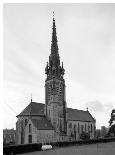
Vue générale nord-est. Phot. Guy Artur, Phot. Norbert Lambart IVR53_19843500258V
