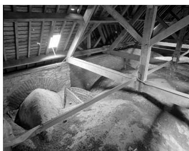
Voûtes de brique, vue générale.
