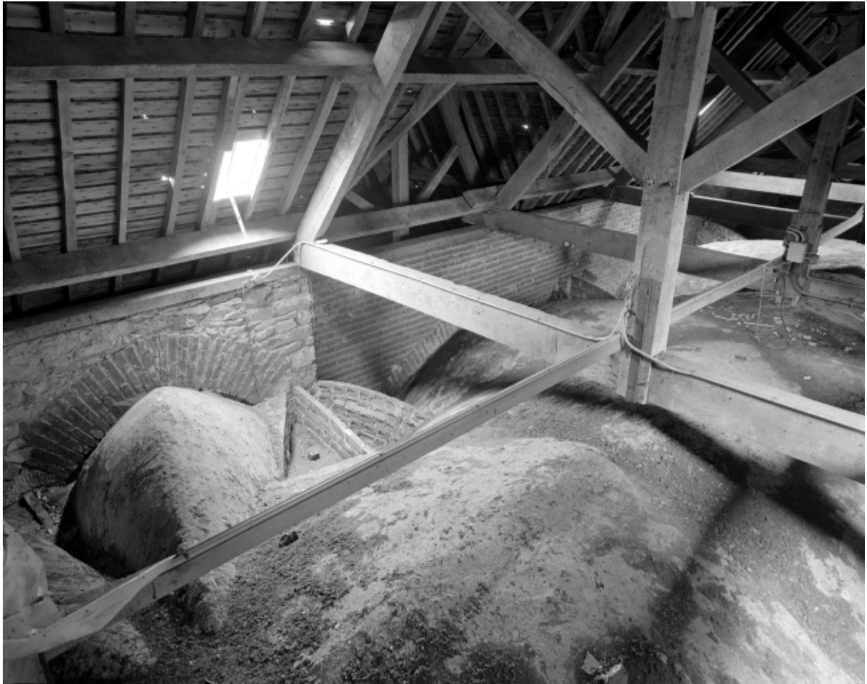
Voûtes de brique, vue générale.
