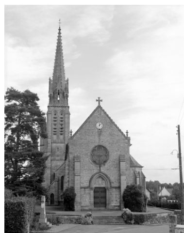
Vue générale ouest. Phot. Guy Artur, Phot. Norbert Lambart IVR53_19843500261X
