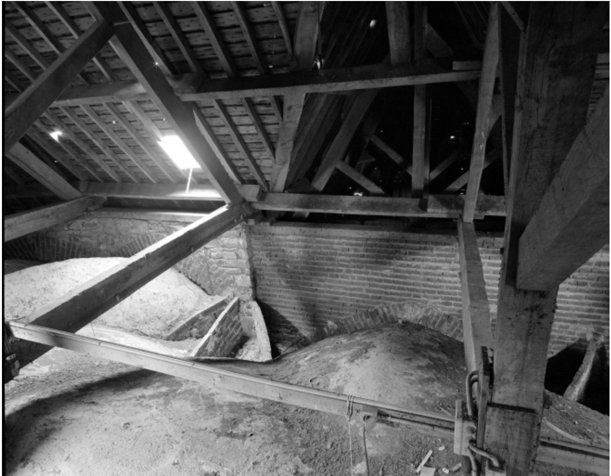
Charpente, vue générale vers l'ouest.
