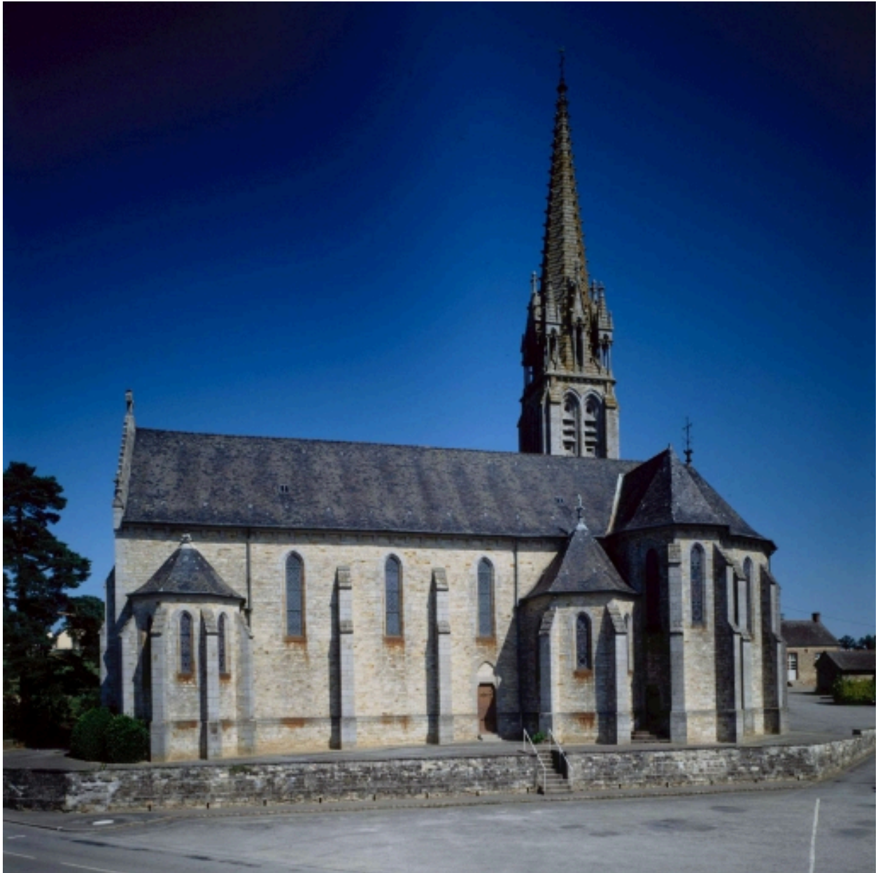
Elévation sud : vue générale
