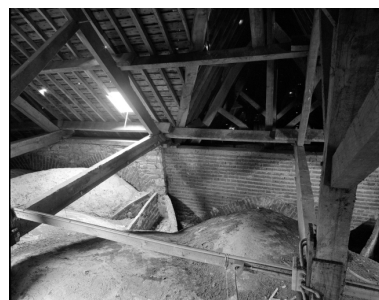
Charpente, vue générale vers l'ouest.
