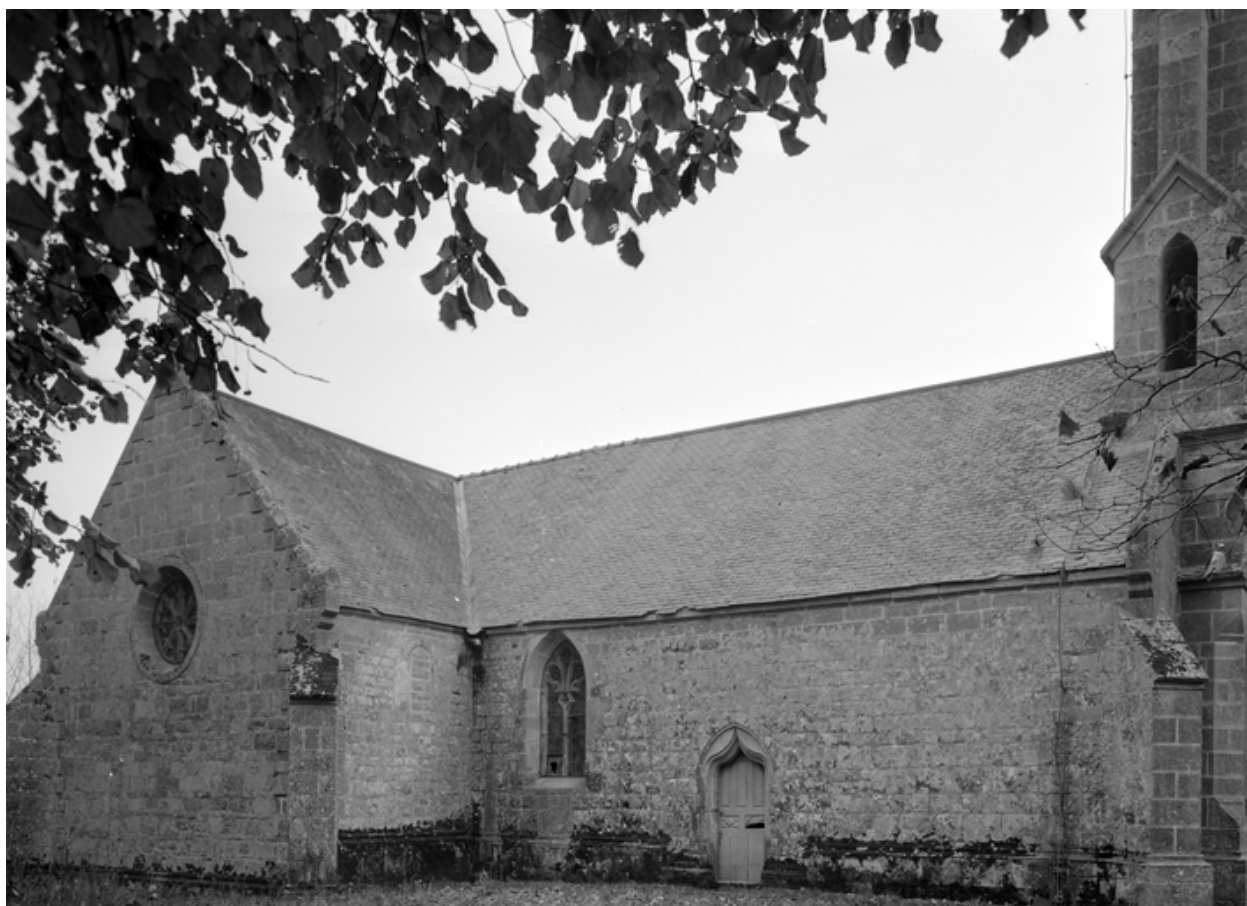
Vue d'ensemble de la façade nord
