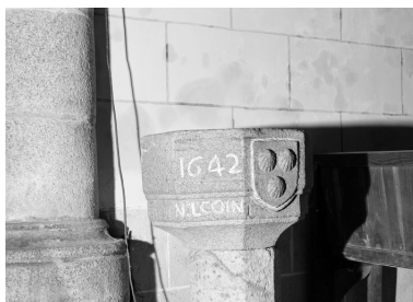
Détail d'un chapiteau Phot. François Dagorn IVR53_19745600200X
