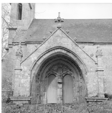
Porche sur la façade sud : vue d'ensemble Phot. Brachet IVR53_19675602613X
