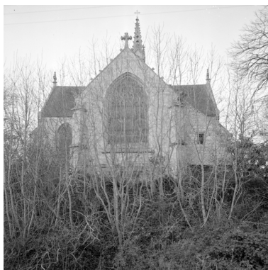
Vue d'ensemble sur le chevet Phot. Brachet IVR53_19675602615X
