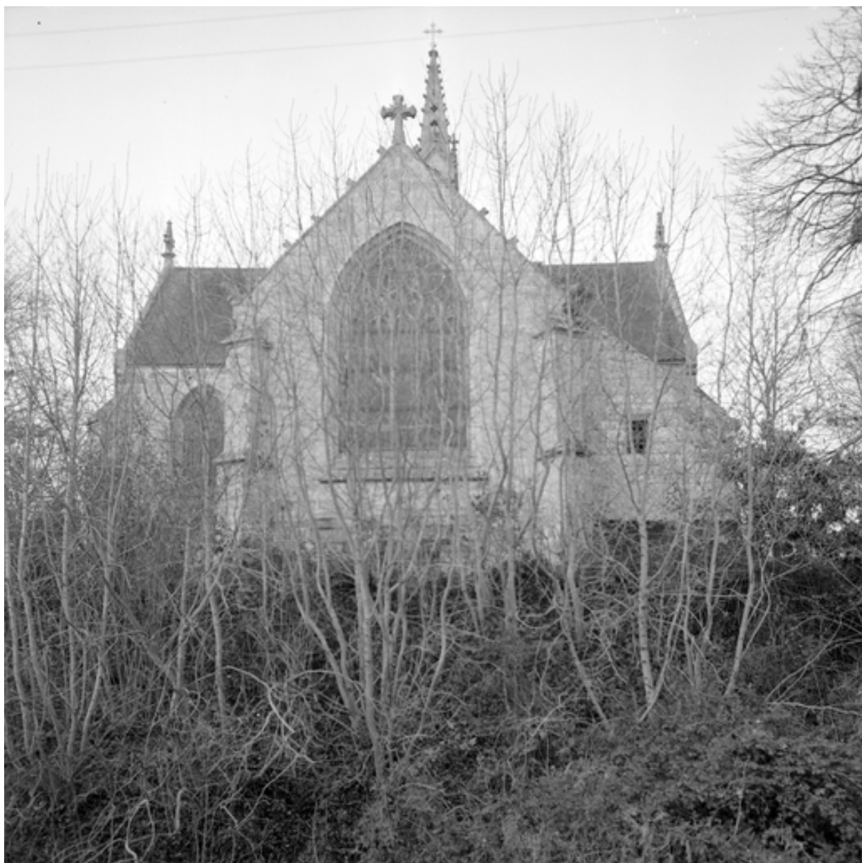
Vue d'ensemble sur le chevet
