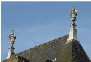
Epis de faitage du pavillon sud-est Phot. Norbert Lambart IVR53_20063502767NUCA
