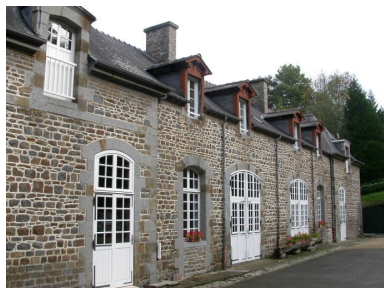
Anciennes remises à carrosses Phot. Sabrina Dalibard IVR53_20063513819NUCA
