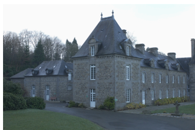
Vue nord-est Phot. Norbert Lambart IVR53_20063502763NUCA
