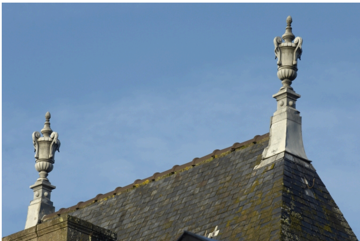
Epis de faîtage du pavillon sud-est
