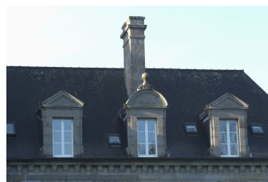
Détail des baies de l'aile ouest Phot. Norbert Lambart IVR53_20063502776NUCA
