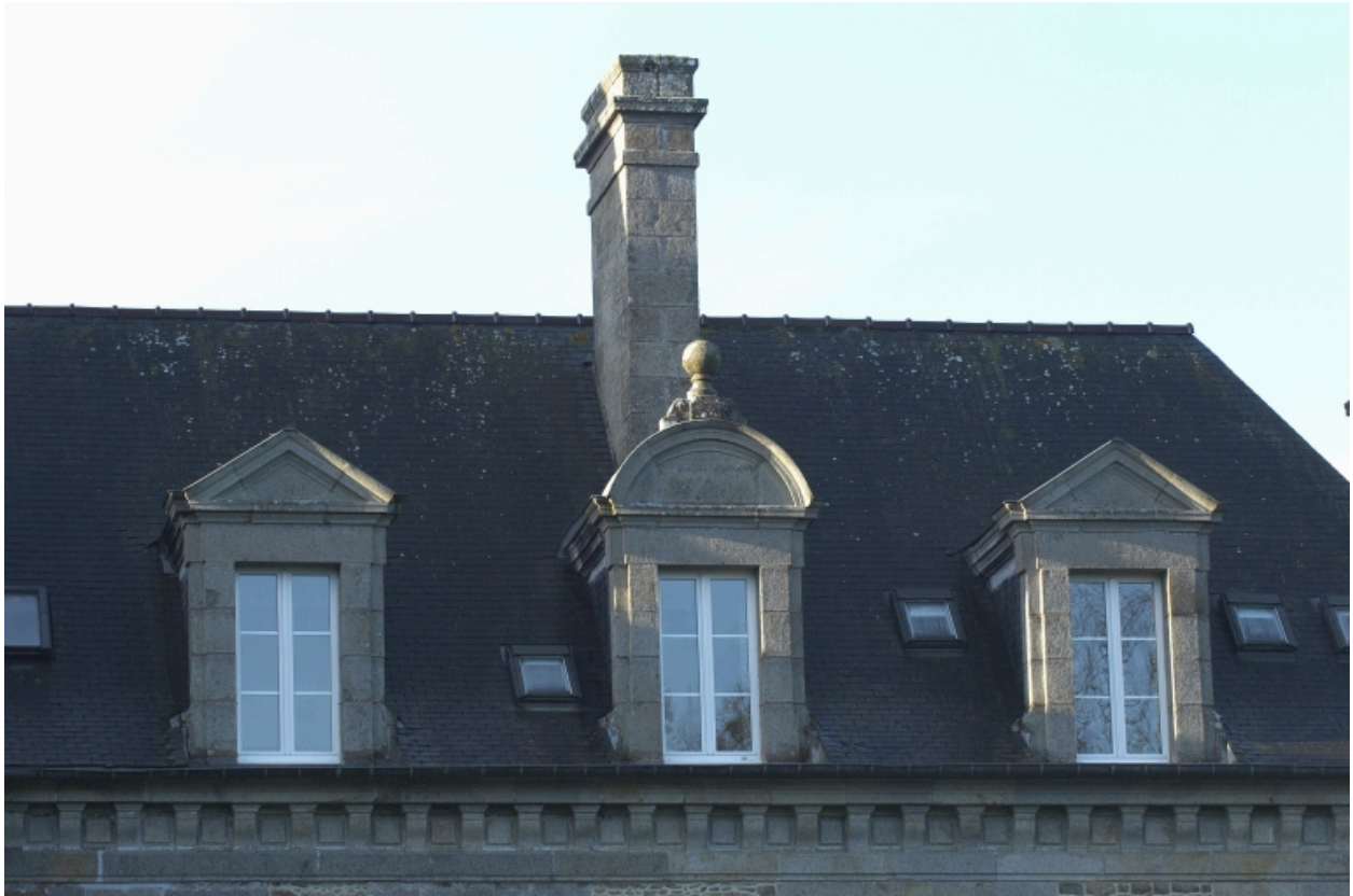
Détail des baies de l'aile ouest
