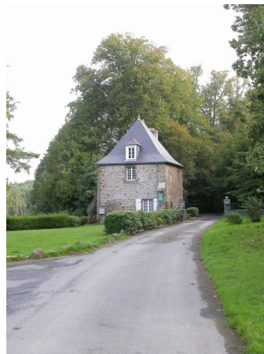
Pavillon d'entrée Phot. Sabrina Dalibard IVR53_20063513824NUCA
