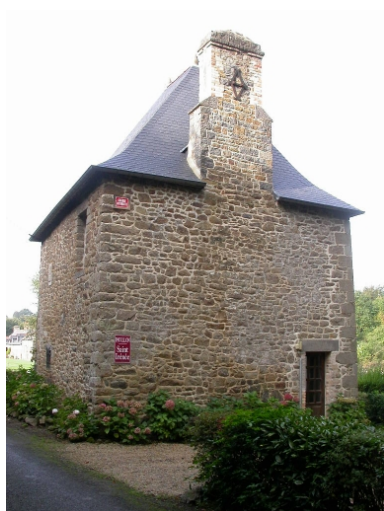
Pavillon d'entrée Phot. Sabrina Dalibard IVR53_20063513825NUCA
