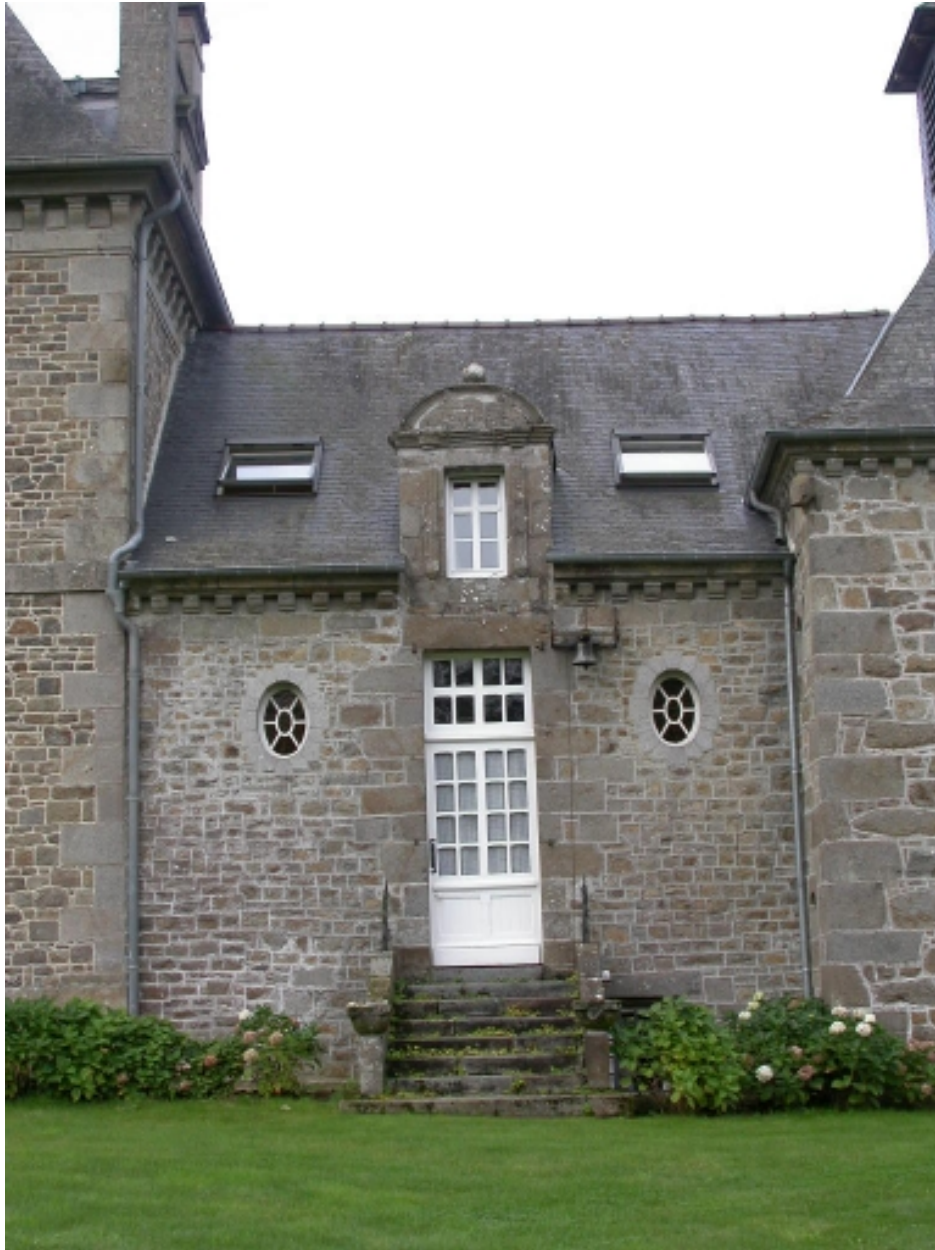
Partie située au sud de la chapelle
