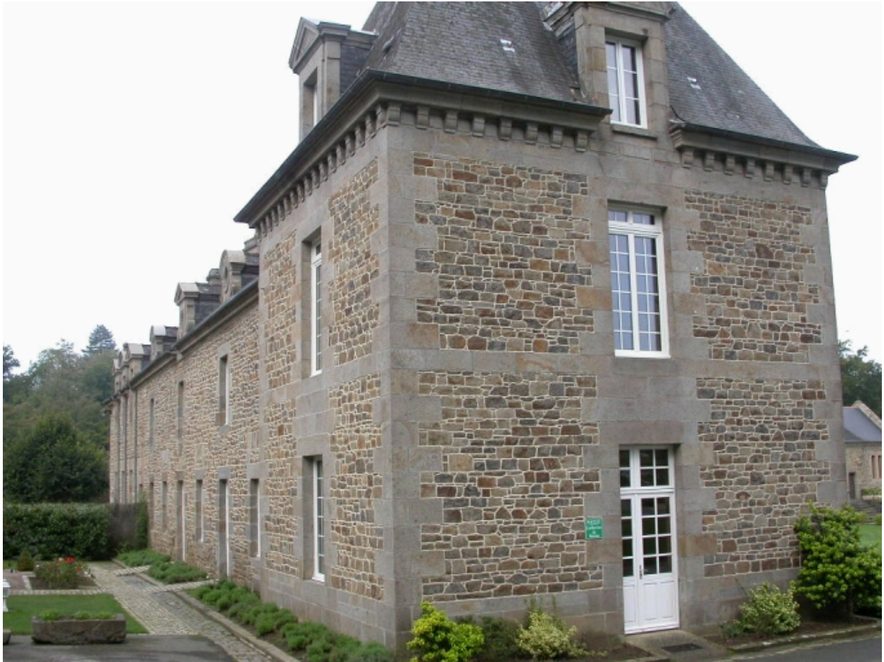
Aile sud, vue sud-est
