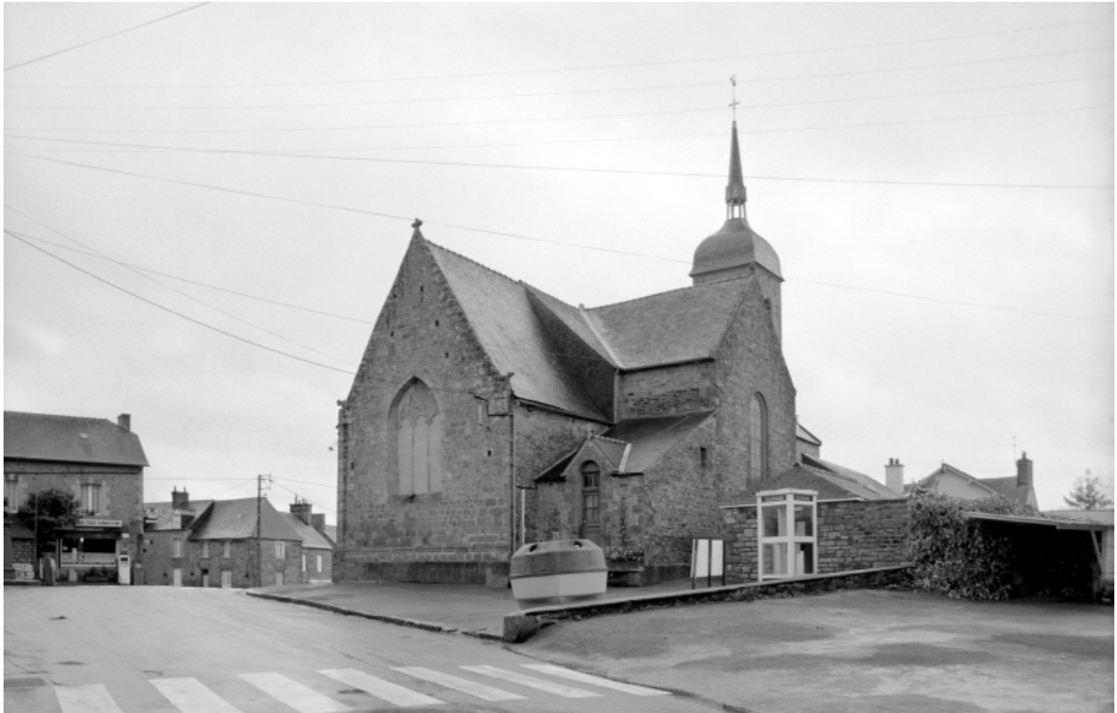
Elévation nord-est : vue générale
