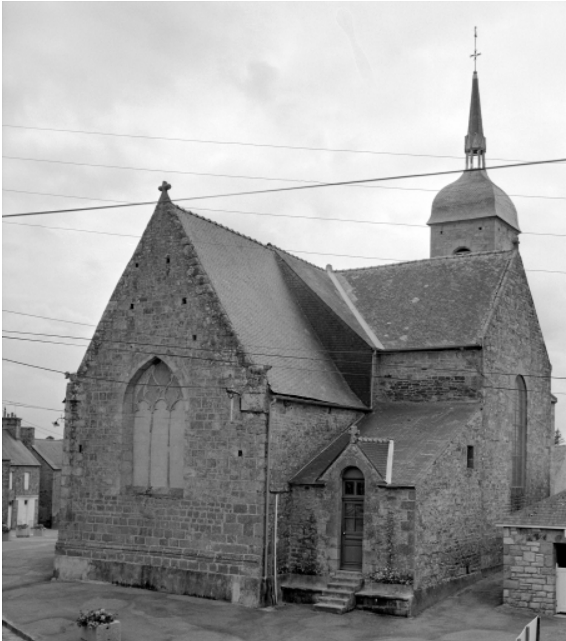
Elévation nord-est : vue générale
