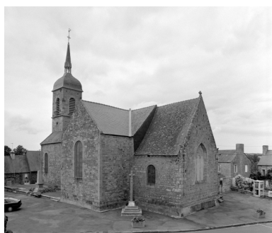
Elévation sud-est : vue générale Phot. Guy Artur, Phot. Norbert Lambart IVR53_19943501286X
