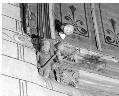
Sablère : détail d'un personnage sculpté Phot. A. Boden IVR53_19943500044X
