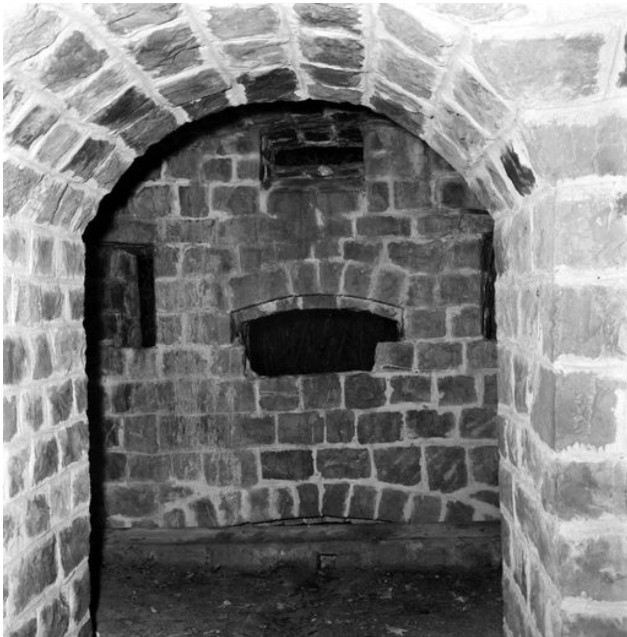
Vue du réduit de Landaoudec en 1969 : caponnière, galerie envelope depuis le berceau central. Créneau de fusillade avec son évent d'aération
