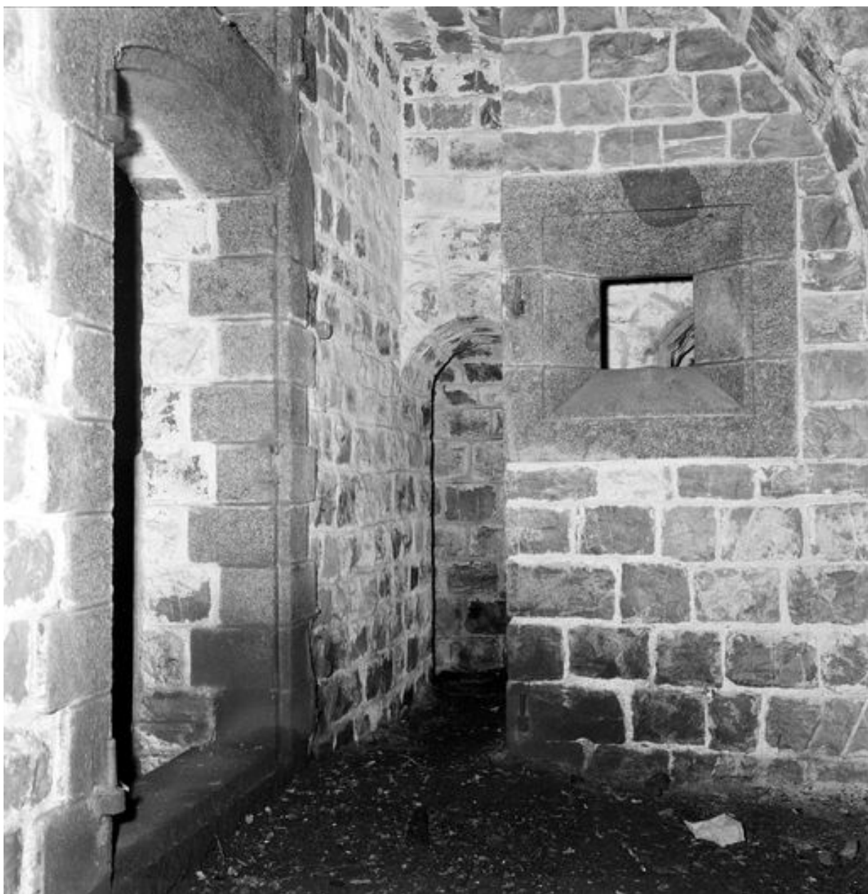
Vue du réduit de Landaoudec en 1969 : vestibule du magasin à poudre. A gauche : entrée de la chambre des poudres, au centre : départ de la galerie enveloppe, à droite : logement de lanterne dit créneau de lanterne
