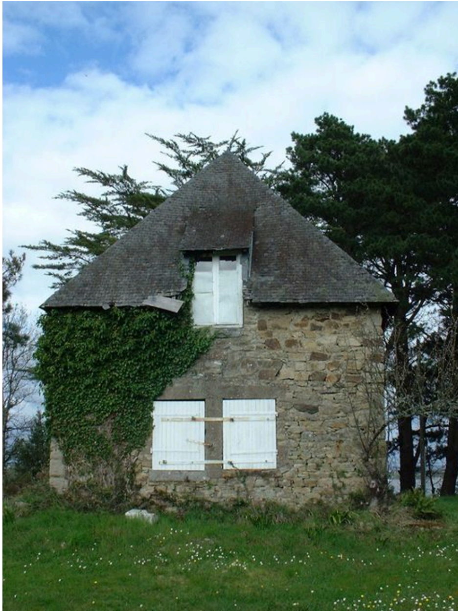
Guérite des douaniers de Barrarac'h
