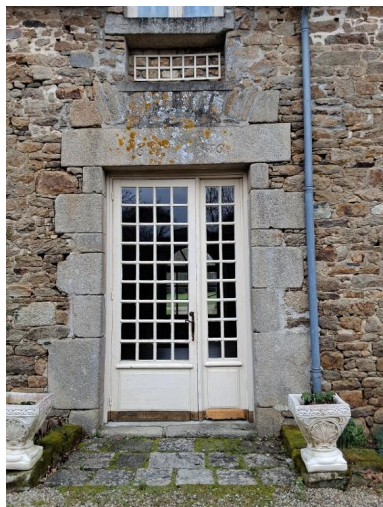
Dépendances nord-ouest, partie écuries, baie, détail : date portée '1656' sur le linteau en granit Phot. Flavie Dupont IVR53_20252210057NUCA
