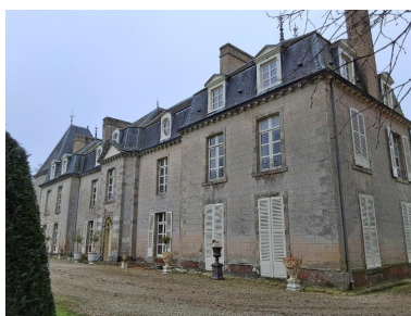
Façade est Phot. Flavie Dupont IVR53_20252210052NUCA
