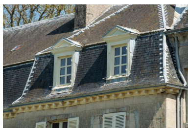
Détail des toitures, lucarnes et corniche Phot. Léna Leroy IVR53_20252200300NUCA
