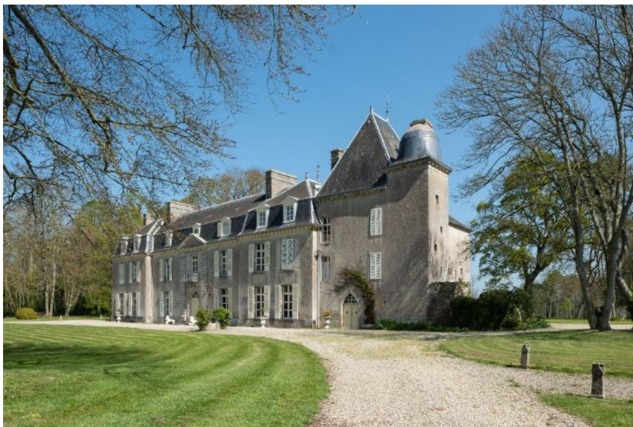
Vue générale de la façade ouest
