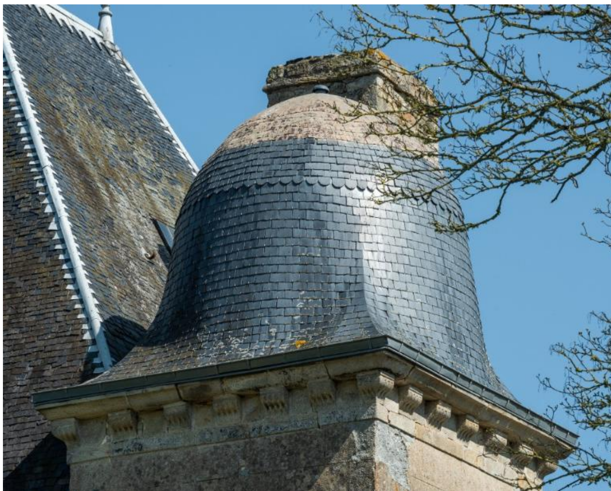
Détail de la toiture du pavillon Renaissance
