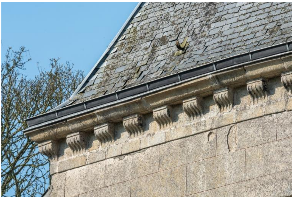
Façade est, détail des corniches
