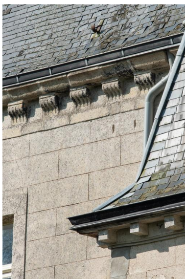
Façade est, différence des corniches du pavillon XVIe et du château XVIIIe Phot. Léna Leroy IVR53_20252200271NUCA
