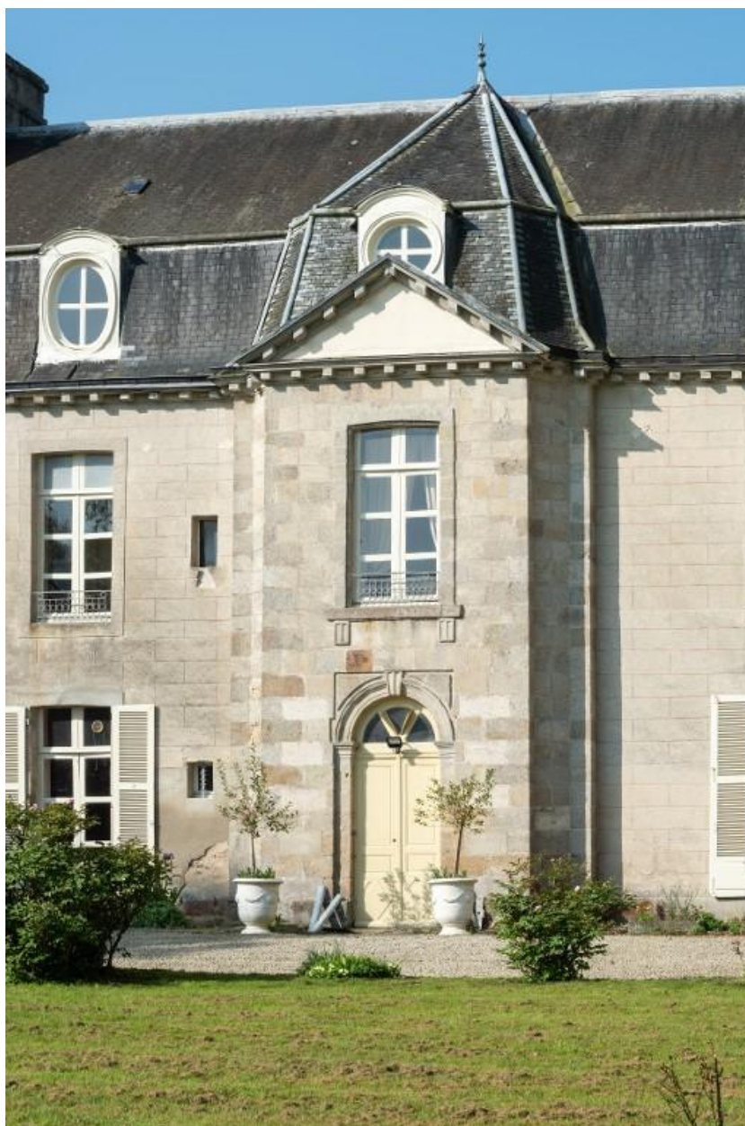
Avant-corps central, façade est
