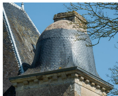
Détail de la toiture du pavillon Renaissance Phot. Léna Leroy IVR53_20252200299NUCA
