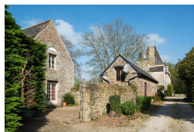
Dépendances dont chenil Phot. Léna Leroy IVR53_20252200279NUCA
