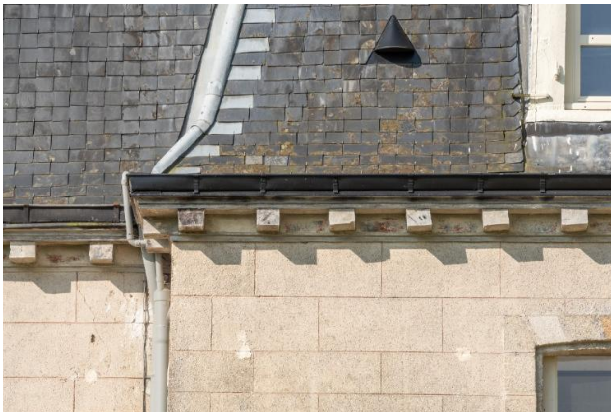
Façade est, détail des corniches
