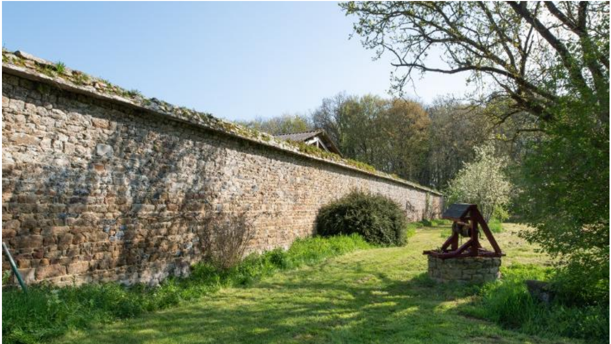
Mur de clôture
