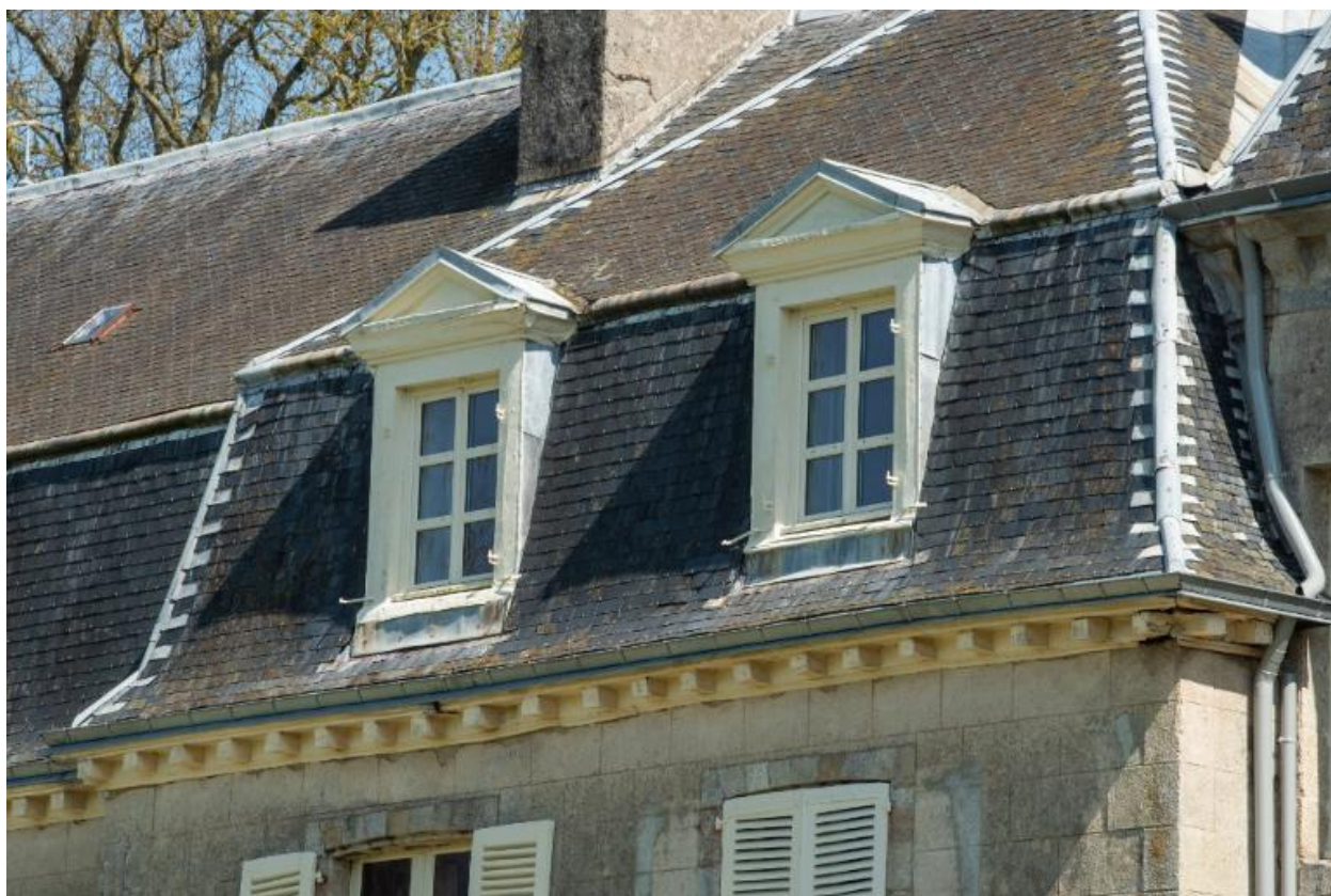
Détail des toitures, lucarnes et corniche
