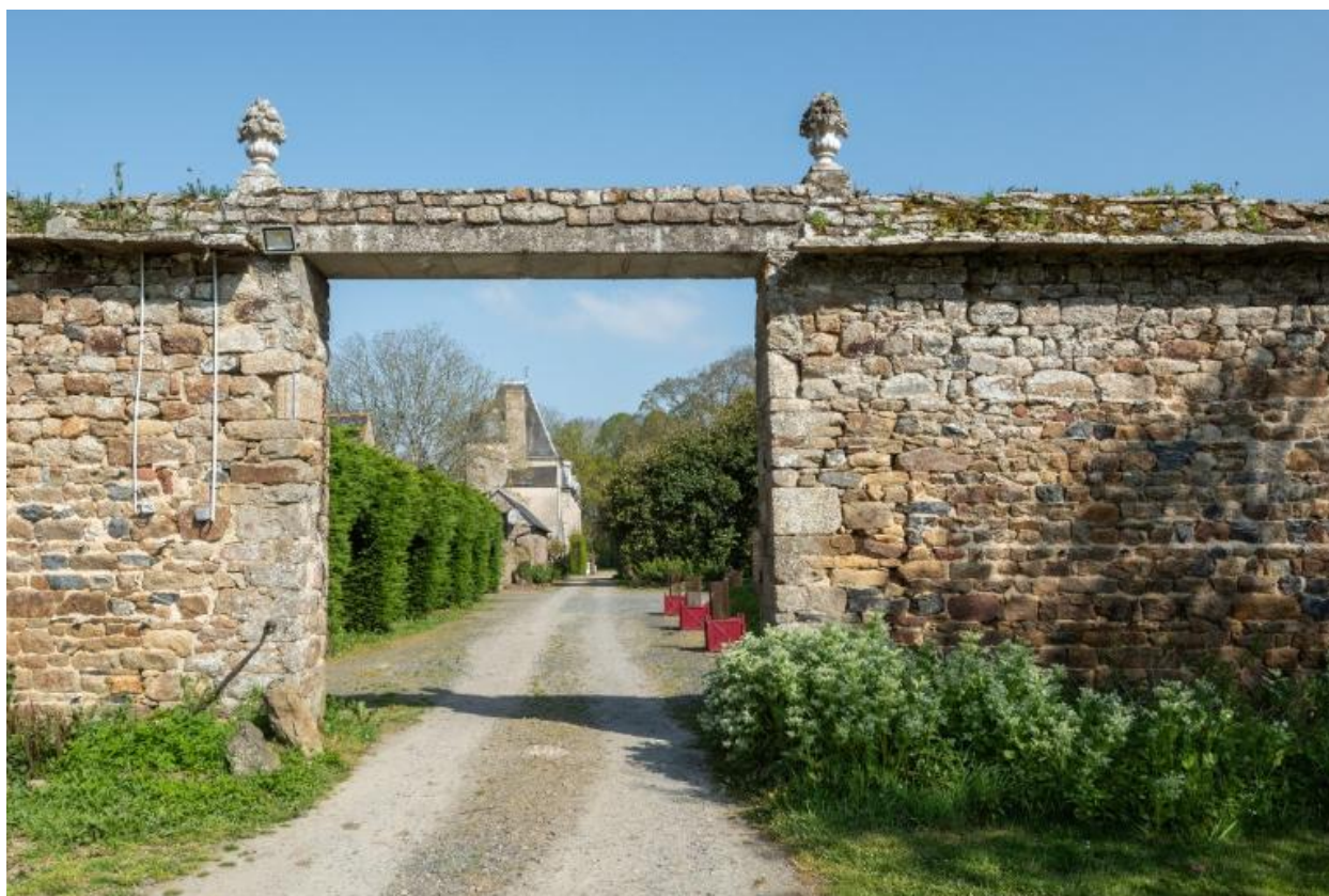
Mur de clôture
