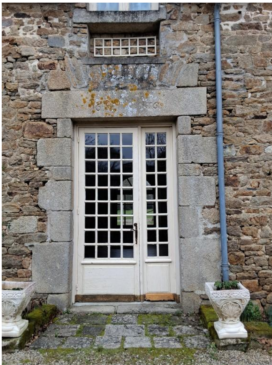
Dépendances nord-ouest, partie écuries, baie, détail : date portée '1656' sur le linteau en granit
