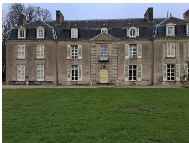
Façade ouest Phot. Flavie Dupont IVR53_20252210054NUCA
