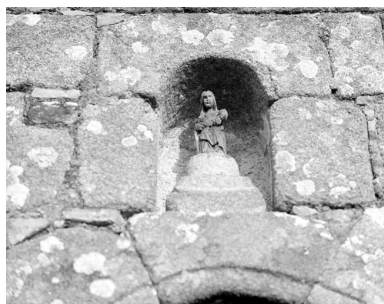
Elévation Ouest, porte : détail de la statuette Phot. A. Boden IVR53_19943500066X
