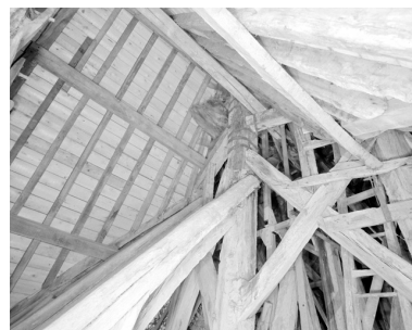
Clocher, combles : détail de la charpente Phot. A. Boden IVR53_19943500070X
