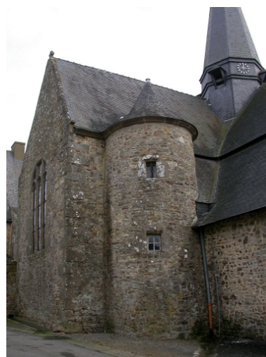
Tourelle d'escalier située sur la façade nord Phot. Sabrina Dalibard IVR53_20053506208NUCA
