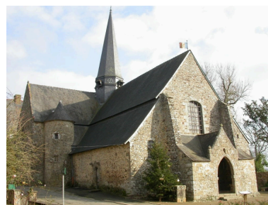
Vue générale nord-ouest Phot. Sabrina Dalibard IVR53_20053506203NUCA
