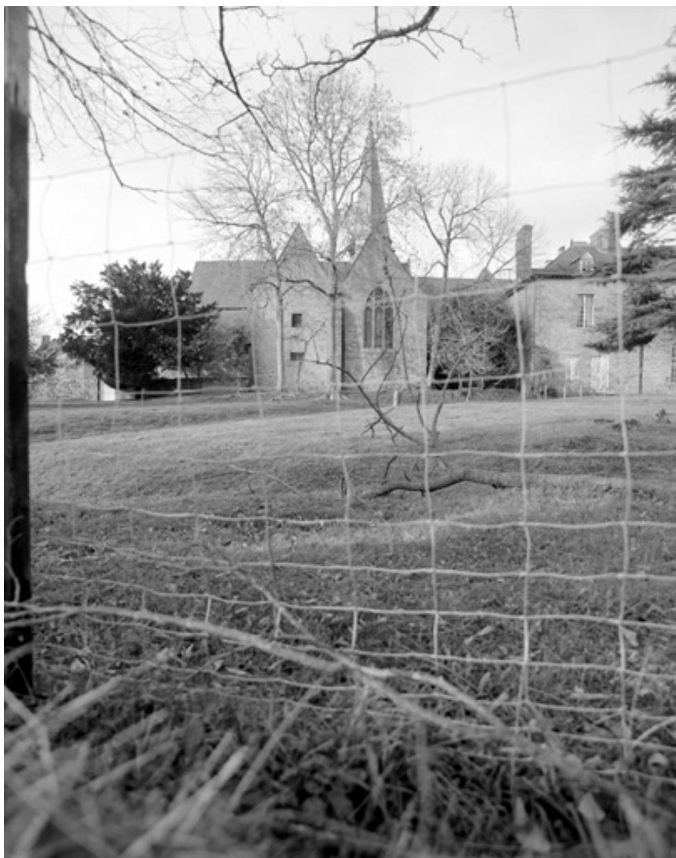
Elévation Sud : vue générale
