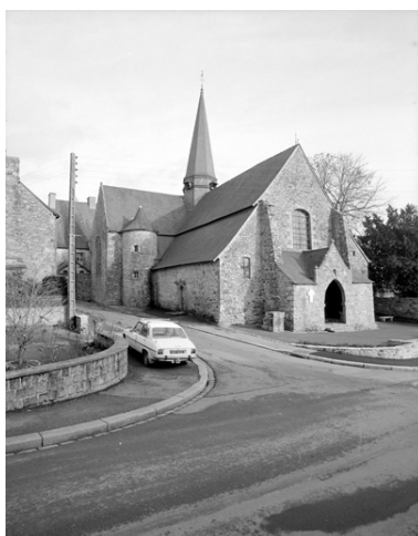
Elévation Nord-Ouest : vue générale Phot. Guy Artur, Phot. Norbert Lambart IVR53_19943500061X
