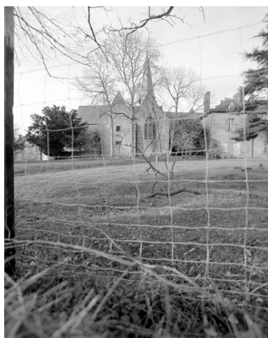
Elévation Sud : vue générale Phot. A. Boden IVR53_19943500063X
