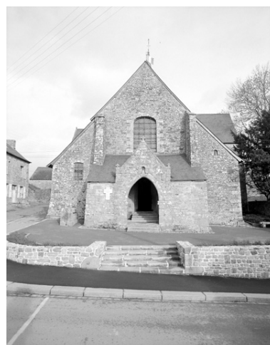
Elévation Ouest : vue générale Phot. A. Boden IVR53_19943500064X
