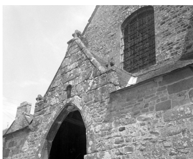
Etat en 1971, détail du porche ouest Phot. F. Chanu IVR53_19713500503Z
