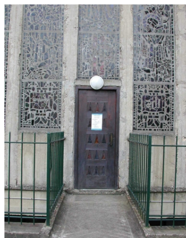
Détail sur la porte ouvrant sur le chœur Phot. Isabelle Barbedor IVR53_20013522293NUCA
