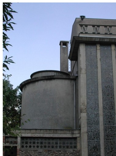
Détail sur la niche à éclairage zénithal Phot. Isabelle Barbedor IVR53_20013522296NUCA
