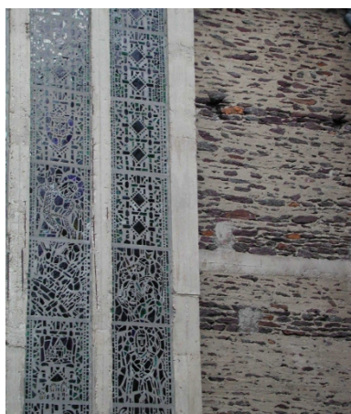
Détail sur le mur ouest Phot. Isabelle Barbedor IVR53_20013522297NUCA
