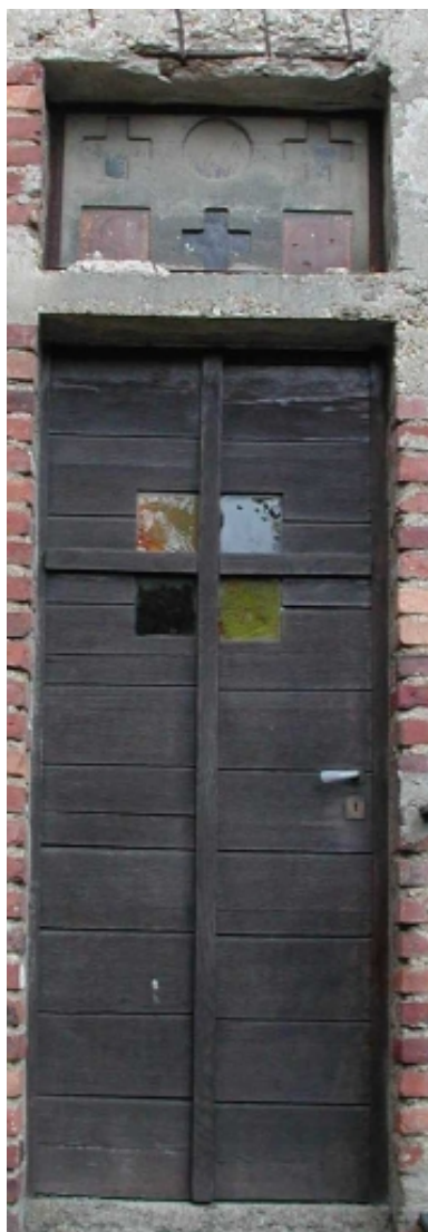
Détail sur la porte de la sacristie Phot. Isabelle Barbedor IVR53_20013522294NUCA
