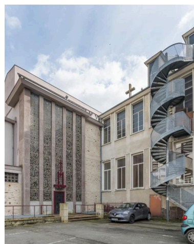
Bâtiment de 1951 et chœur de la chapelle vus du nord Phot. Delia Gaulin-Crespel IVR53_20183500103NUCA
