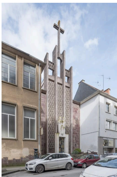
La façade de la chapelle Phot. Delia Gaulin-Crespel IVR53_20183500100NUCA
