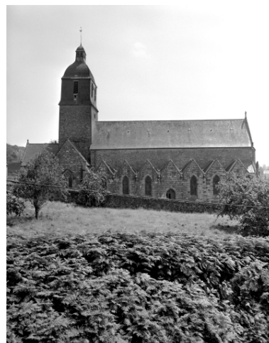
Elévation Nord : vue générale
