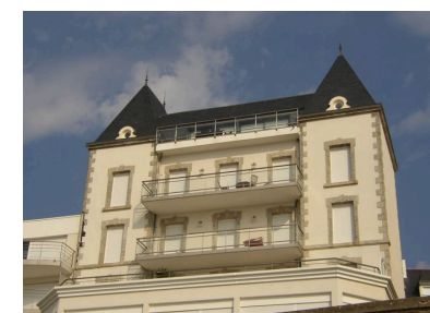
Étages supérieurs de la façade principale de l'ancien Hôtel des Bains Phot. Johan Vincent IVR53_20062908682NUCA
