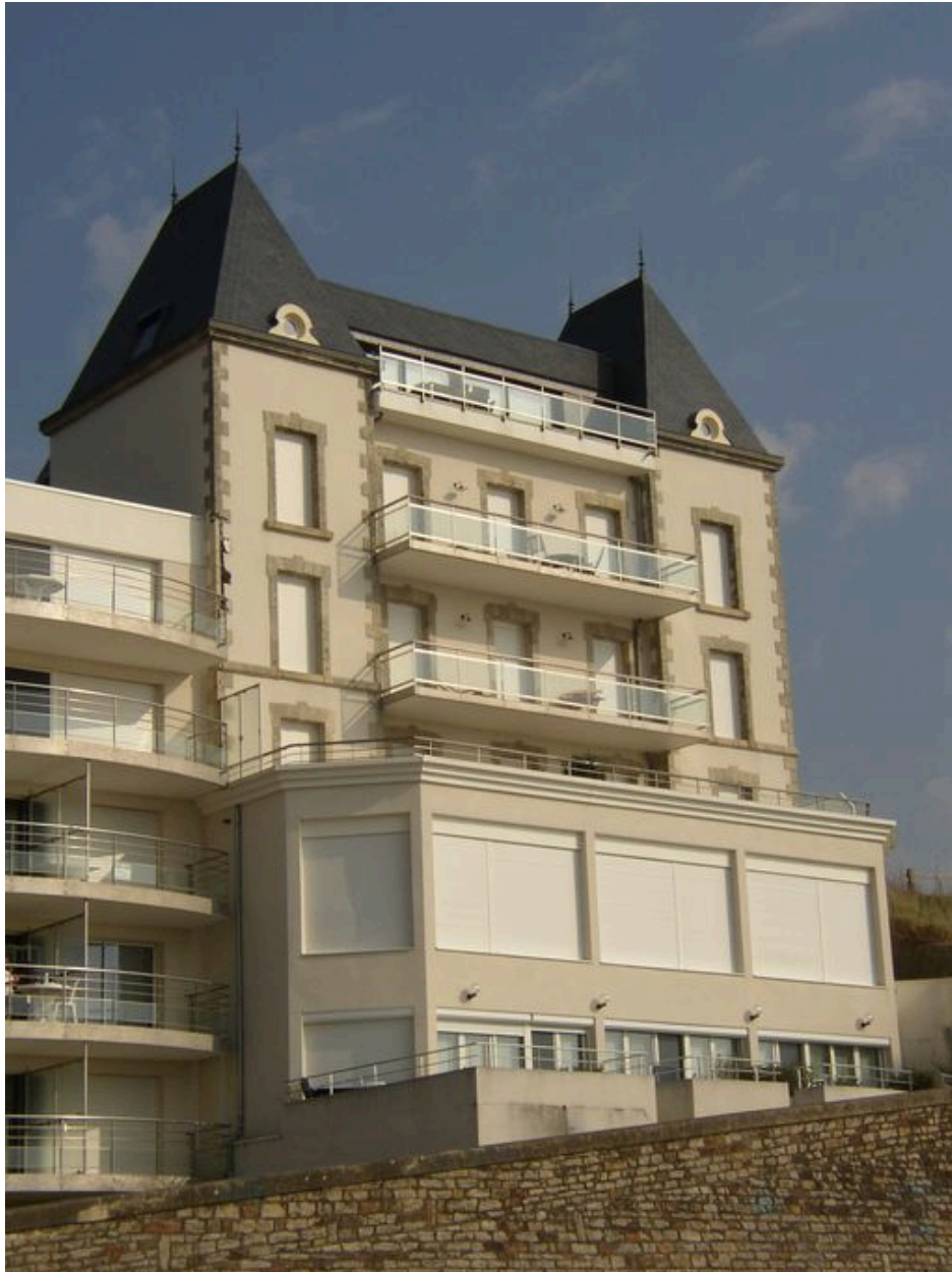
Façade principale de l'ancien Hôtel des Bains, côté mer
