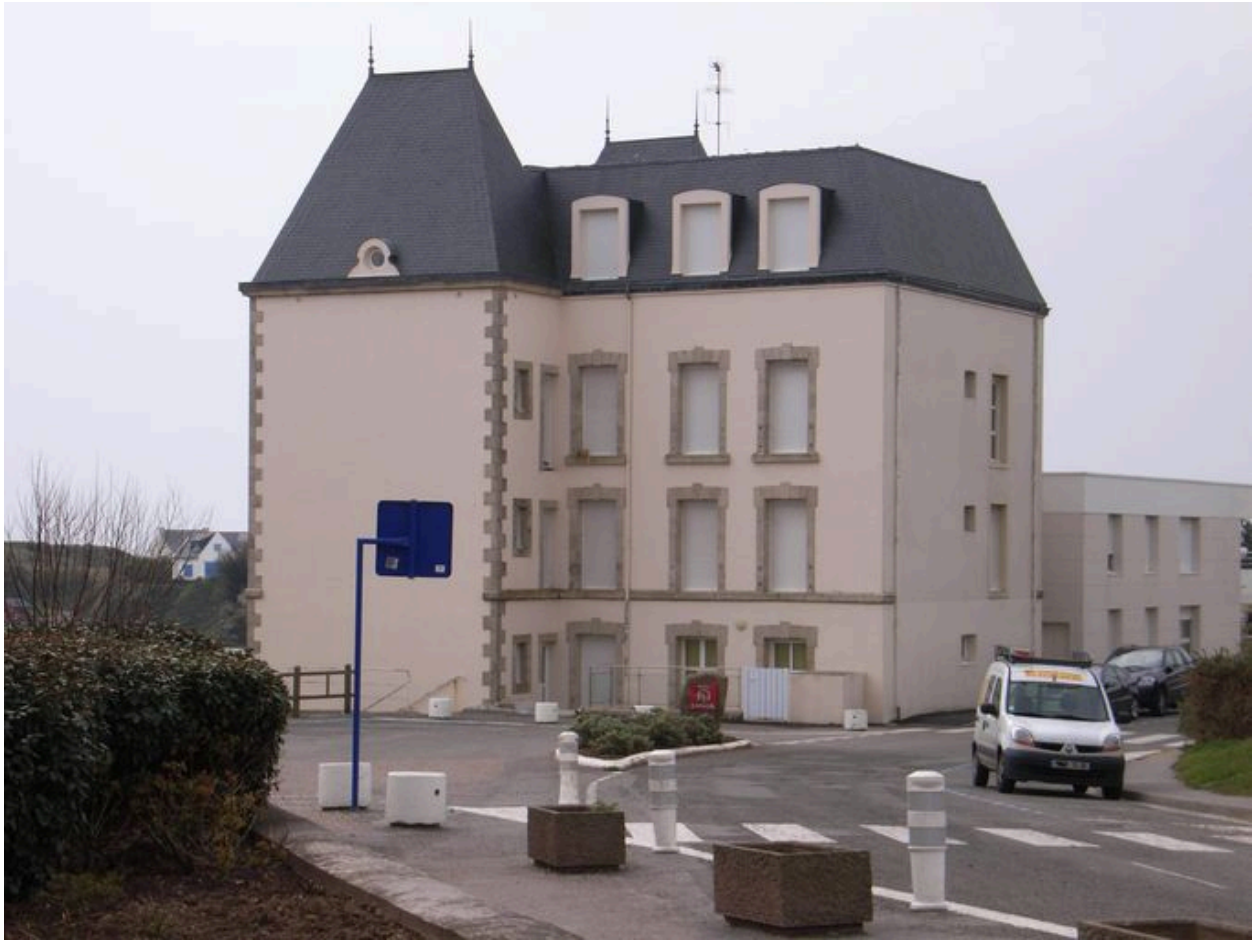
Ancien Hôtel des Bains, côté rue
