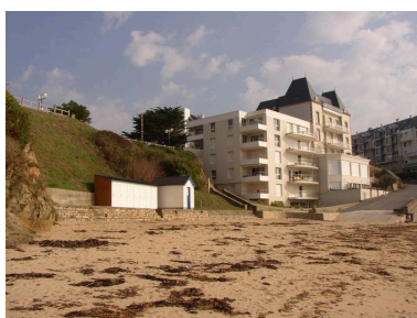
Vue générale de l'ancien Hôtel Des Bains Phot. Johan Vincent IVR53_20062908679NUCA
