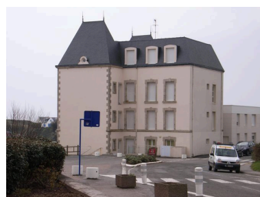
Ancien Hôtel des Bains, côté rue Phot. Florence Despretz IVR53_20072909046NUCA
