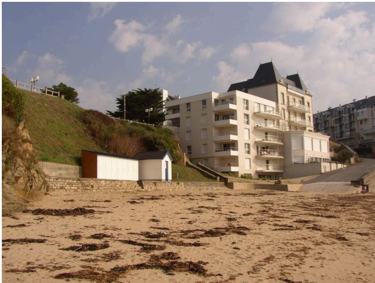
Vue générale de l'ancien Hôtel Des Bains
