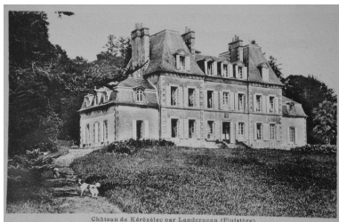
Vue générale Phot. Elise Lauranceau IVR53_20052904363NUCB
