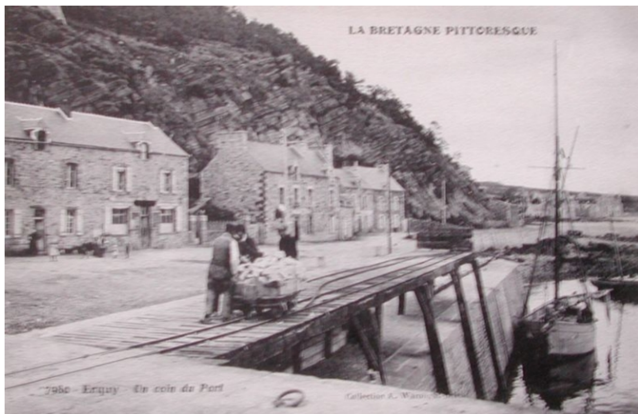
Le port d'Erquy au début du 20ème siècle : l'estacade en bois construites pour le chargement des pavés en bateau
