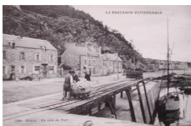
Le port d'Erquy au début du 20ème siècle : l'estacade en bois construites pour le chargement des pavés en bateau Repro. Guy Prigent, Autr. Armand Waron IVR53_20042208353NUCB
