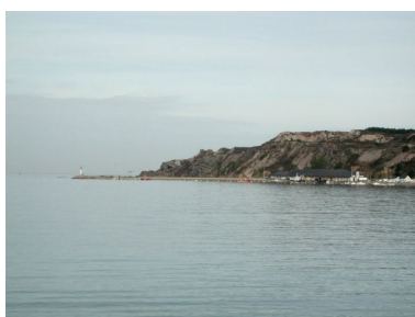
Vue du nouveau port d'Erquy, adossé contre la falaise Phot. Guy Prigent IVR53_20042208342NUCA
