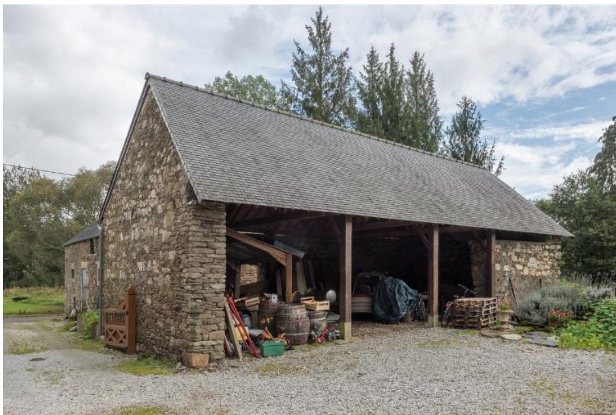
Remise. Vue générale ouest
