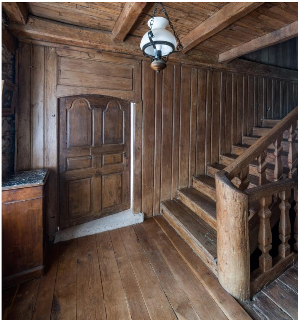
Logis 1774. Palier de l'étage avec porte de la chambre et cloison en menuiserie
