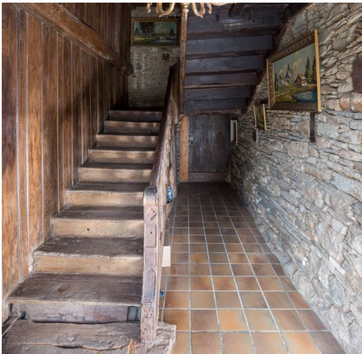
Logis 1774. Vestibule d'entrée avec l'escalier établi entre le pignon et une cloison en menuiserie. Vue générale
