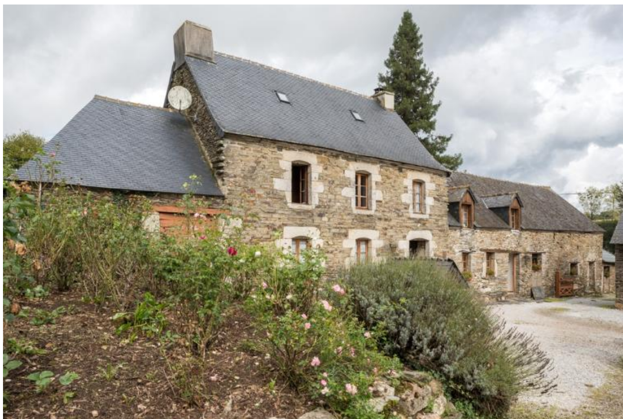
Logis 1774. Vue générale sud-ouest
