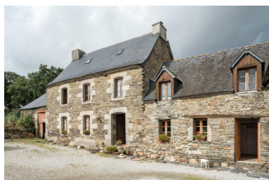
Logis 1774 et logis-étable en alignement. Vue générale sud-est Phot. Charlotte Barraud IVR53_20232201027NUCA
