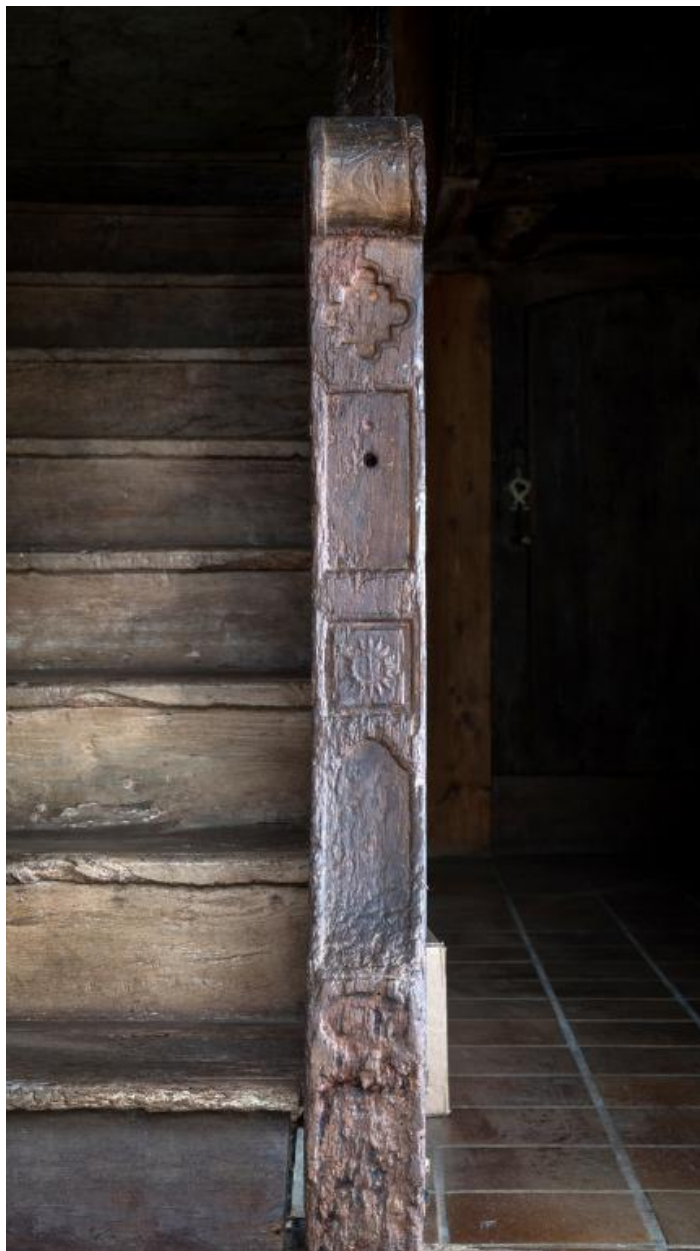
Logis 1774. Vestibule d'entrée. Escalier tournant à retours avec jour. Détail du départ de rampe
