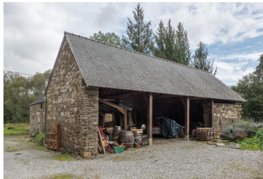
Remise. Vue générale ouest Phot. Charlotte Barraud IVR53_20232201024NUCA
