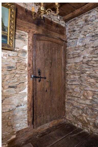
Logis 1774. Repos de l'escalier. Porte d'accès à l'étage de l'appentis postérieur Phot. Charlotte Barraud IVR53_20232201009NUCA
