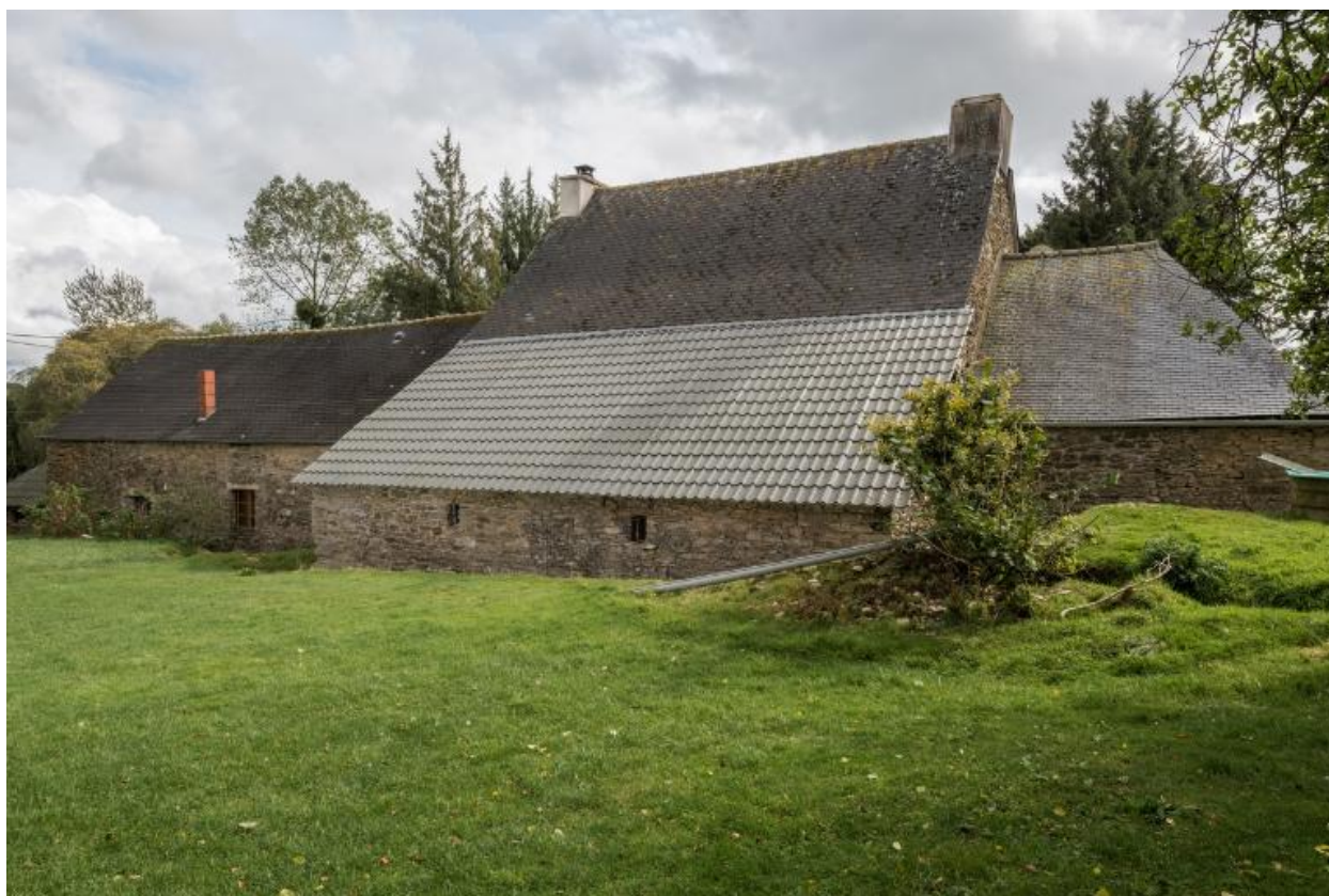
Logis 1774. Appentis à étage. Vue générale nord-ouest
