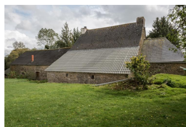
Logis 1774. Appentis à étage. Vue générale nord-ouest Phot. Charlotte Barraud IVR53_20232201032NUCA
