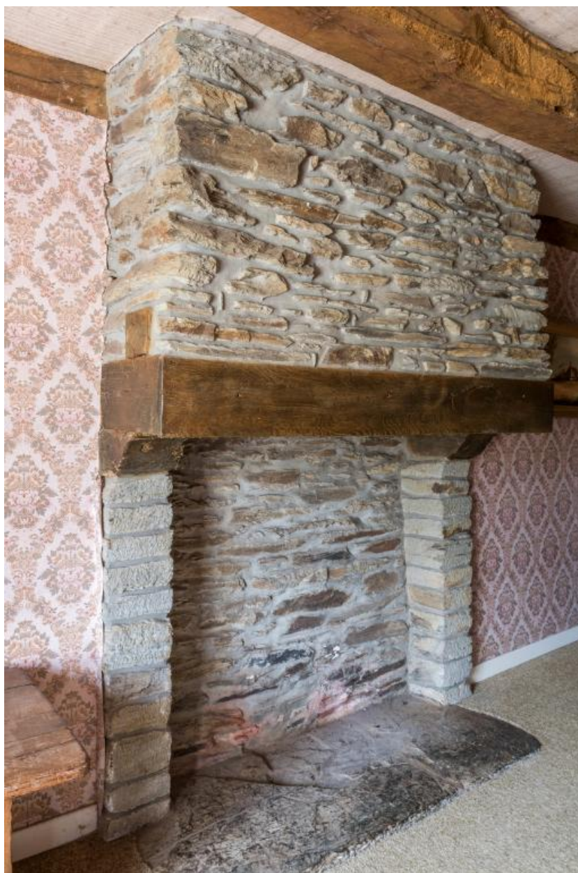
Logis 1774. Chambre de l'étage. Cheminée autrefois boisée
