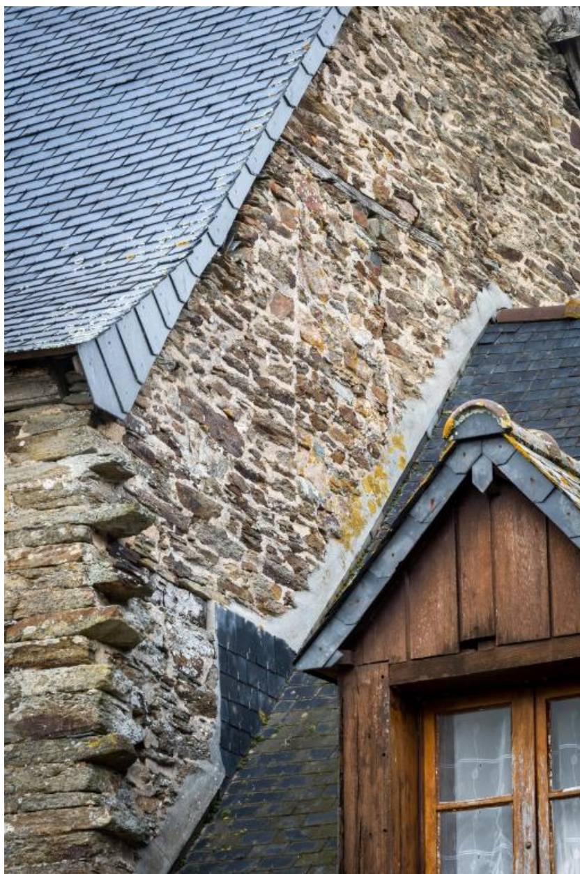
Logis 1774. Pignon est. Détail de la porte bouchée
