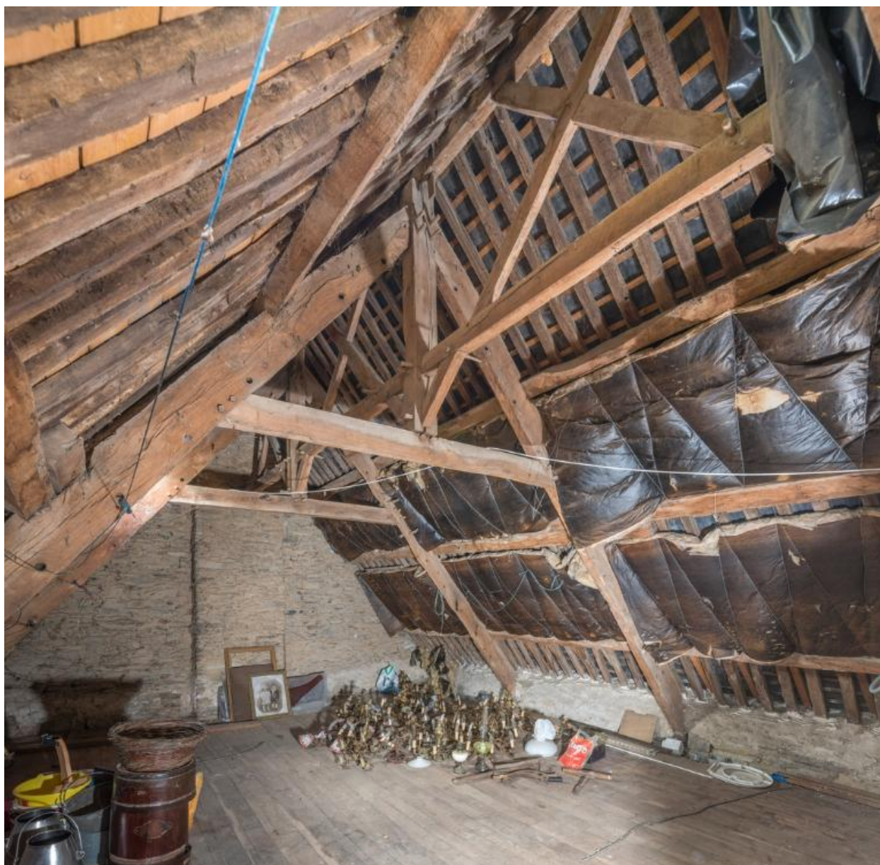
Logis 1774. Charpente à double faîtage. Vue générale
