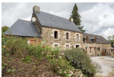
Logis 1774. Vue générale sud-ouest Phot. Charlotte Barraud IVR53_20232201019NUCA
