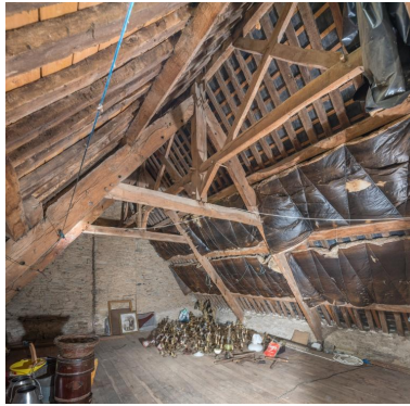
Logis 1774. Charpente à double faîtage. Vue générale Phot. Charlotte Barraud IVR53_20232201015NUCA
