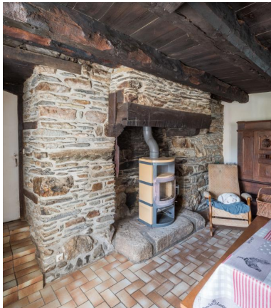
Logis-étable fin 18e ou début 19e siècle. Cheminée de la salle. Vue générale Phot. Charlotte Barraud IVR53_20232201018NUCA
