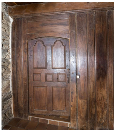
Logis 1774. Vestibule d'entrée. Porte de la salle et cloison en menuiserie Phot. Charlotte Barraud IVR53_20232201003NUCA
