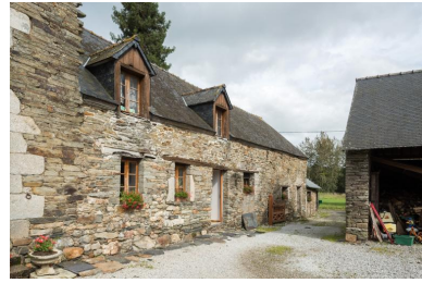
Logis-étable fin 18e ou début 19e siècle. Vue générale sud-ouest Phot. Charlotte Barraud IVR53_20232201026NUCA
