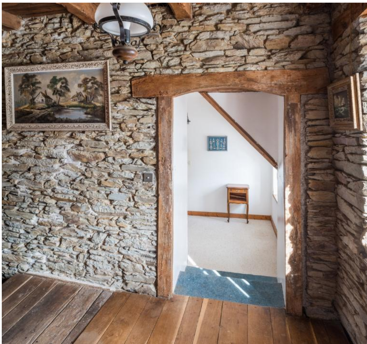
Logis 1774. Palier de l'étage. Porte d'accès au comble de la maison voisine
