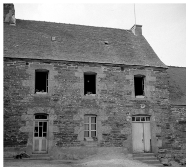
Vue sud. Etat en 1969 Phot. M. A. Dubois IVR53_19692205196Z
