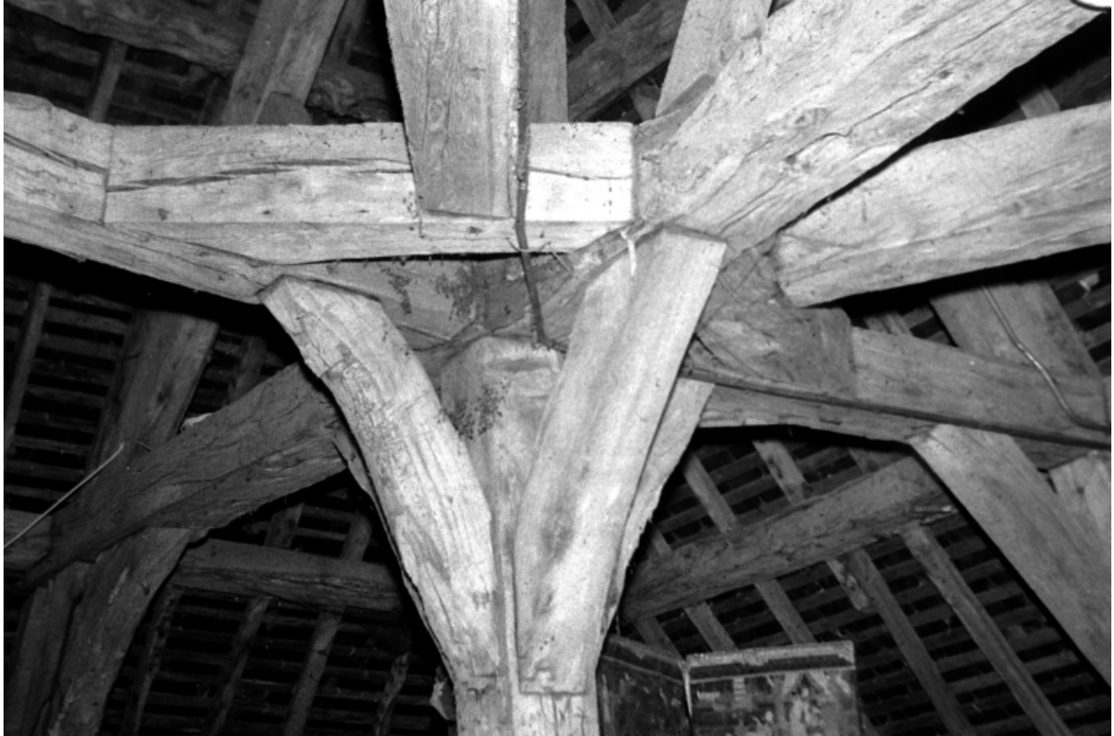
Charpente, vue générale.
