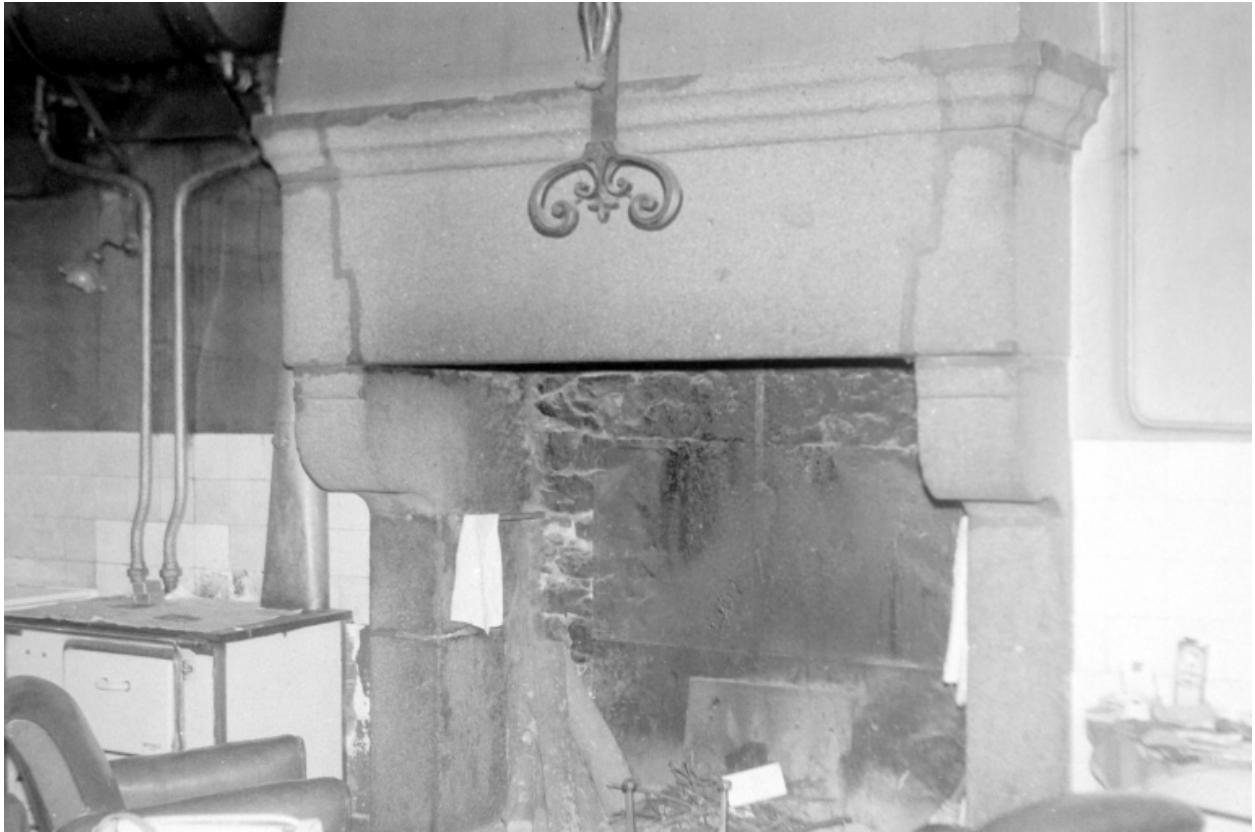
Cheminée, vue générale.
