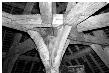
Charpente, vue générale. Phot. Le Marois IVR53_19683501133Z
