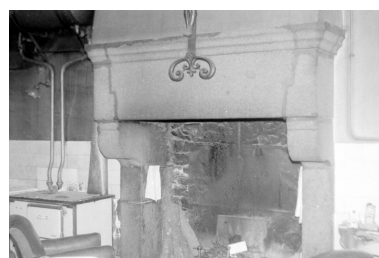
Cheminée, vue générale. Phot. Le Marois IVR53_19683501134Z
