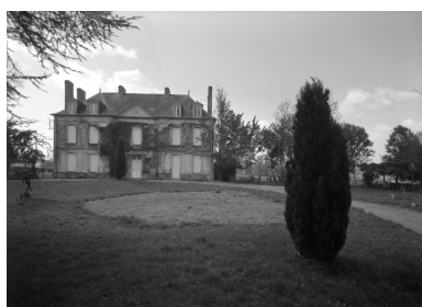
Façade nord-est, vue générale. Phot. François Dagorn IVR53_19733500282V
