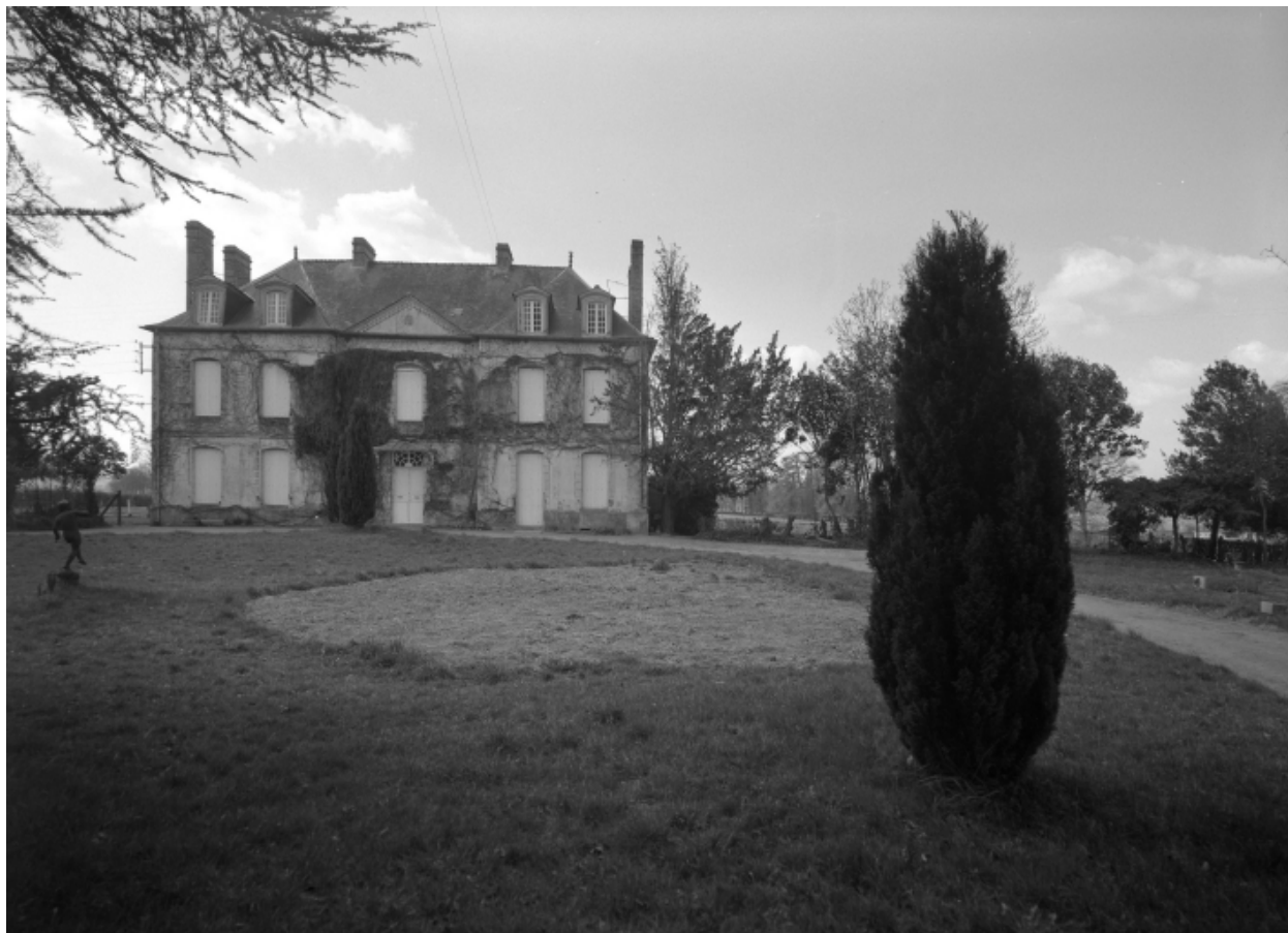
Façade nord-est, vue générale.
