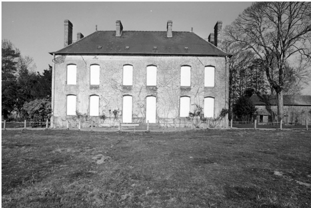
Façade sud-ouest, vue générale.
