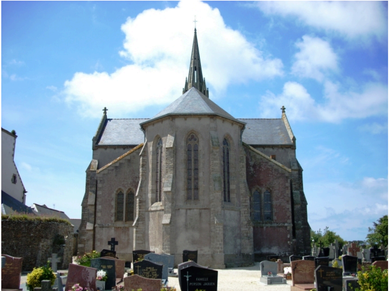
Landunvez, église paroissiale : élévation est
