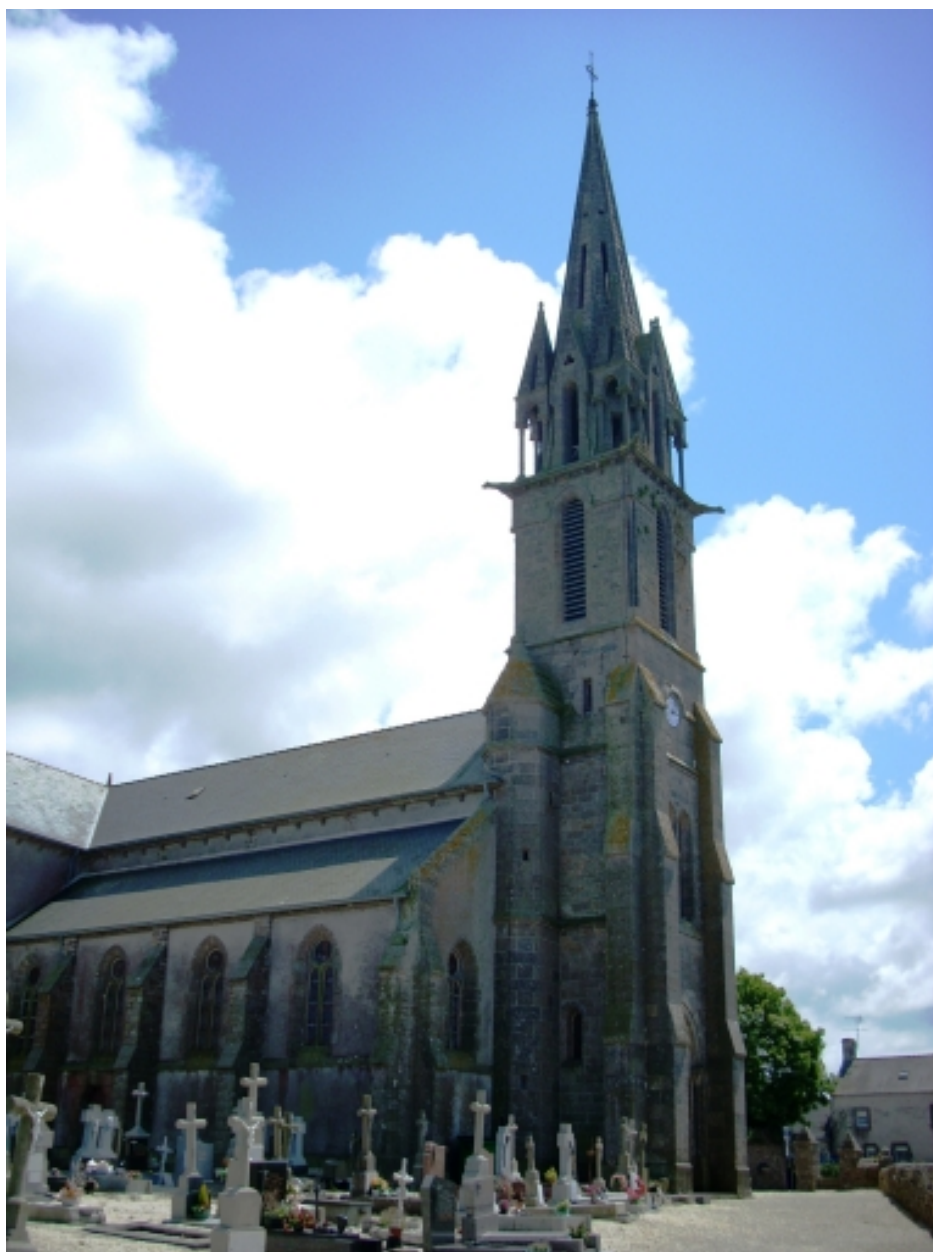
Landunvez, église paroissiale : vue générale nord
