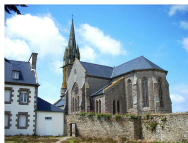
Landunvez, église paroissiale : vue générale sud-est Phot. Gwénaél Fauchille IVR53_20082906215NUCA
