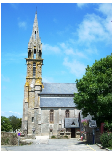
Landunvez, église paroissiale : vue générale sud Phot. Gwénaél Fauchille IVR53_20082906214NUCA
