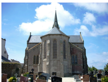
Landunvez, église paroissiale : élévation est Phot. Gwénaél Fauchille IVR53_20082906217NUCA
