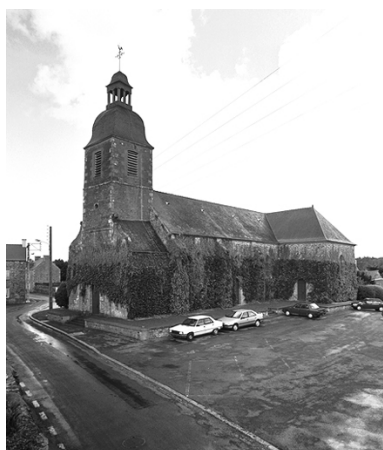
Vue générale sud-ouest Phot. Guy Artur, Phot. Norbert Lambart IVR53_19943501841X
