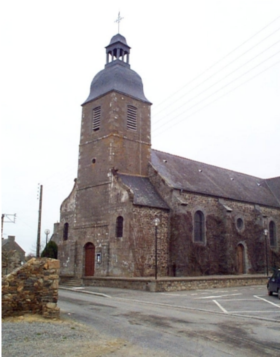
Clocher-porche, vu du sud-ouest
