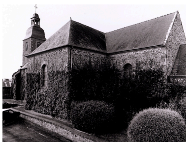
Vue générale sud-est Phot. Guy Artur, Phot. Norbert Lambart IVR53_19943501842X
