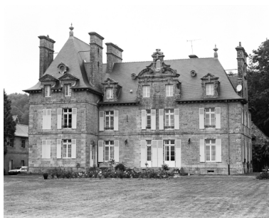
Logis : élévation sud Phot. Bernard Bègne IVR53_19962900836X
