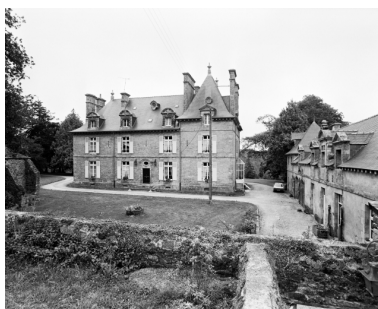
Vue d'ensemble : logis (élévation nord) et commons (élévation est) Phot. Bernard Bègne IVR53_19962900833X
