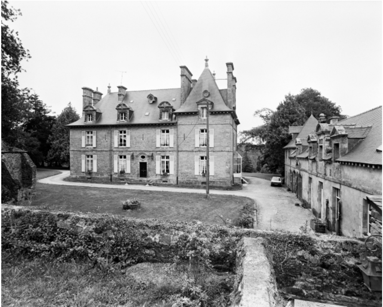
Vue d'ensemble : logis (élévation nord) et communs (élévation est)
