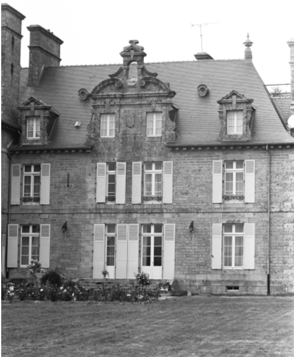
Logis : élévation sud : détail
