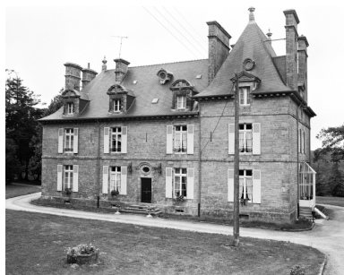
Logis : élévation nord Phot. Bernard Bègne IVR53_19962900834X
