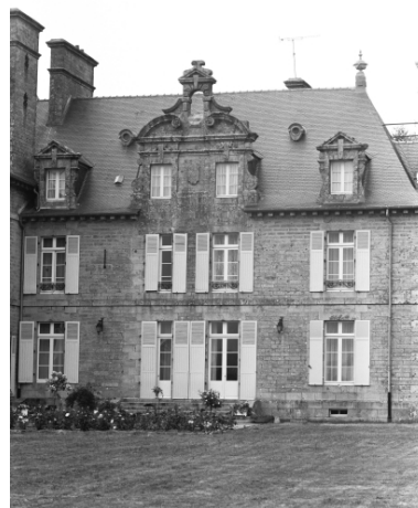
Logis : élévation sud : détail Phot. Bernard Bègne IVR53_19962900837X
