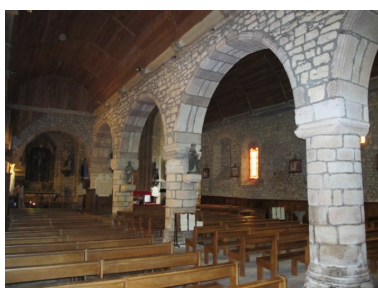
Vue générale intérieure Phot. Sabrina Dalibard IVR53_20113506597NUCA
