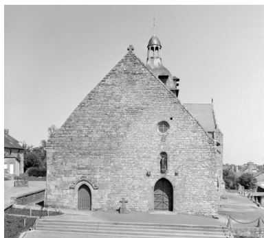
Elévation ouest, porte principale : vue générale Phot. Guy Artur, Phot. Norbert Lambart IVR53_19943500970X
