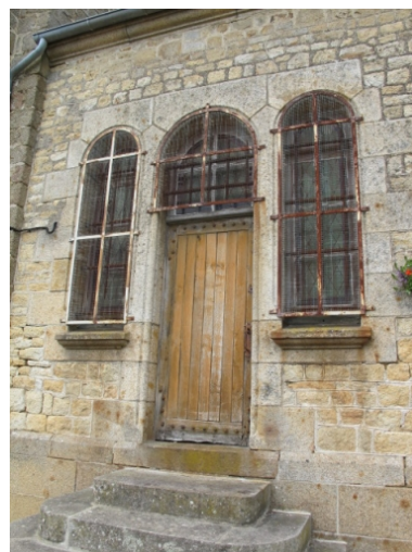
Façade sud, partie ouest Phot. Sabrina Dalibard IVR53_20113506579NUCA
