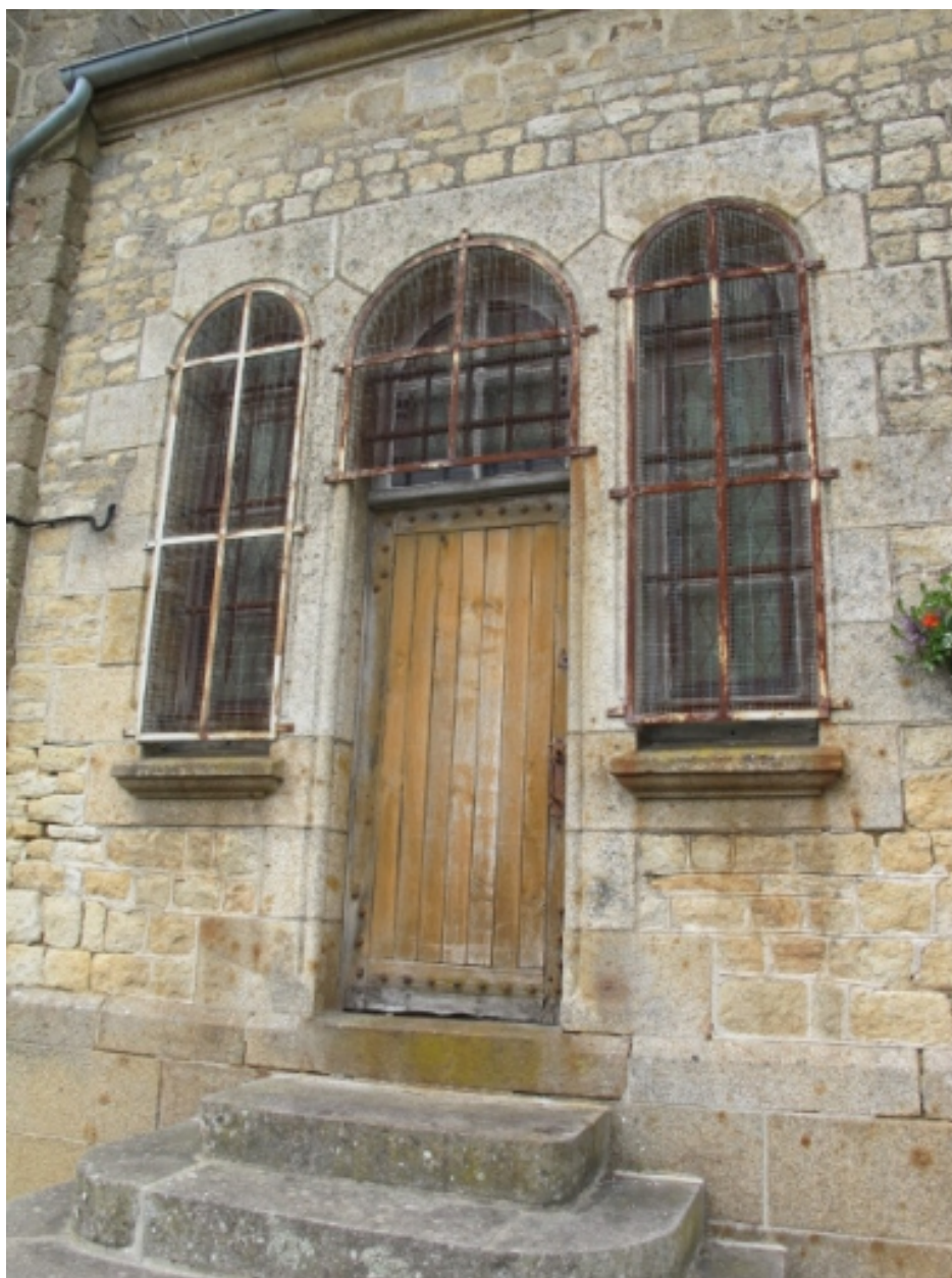
Façade sud, partie ouest
