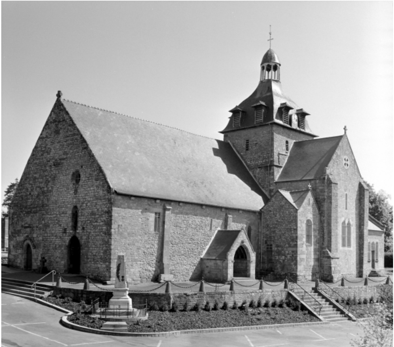
Elévation sud-ouest : vue générale
