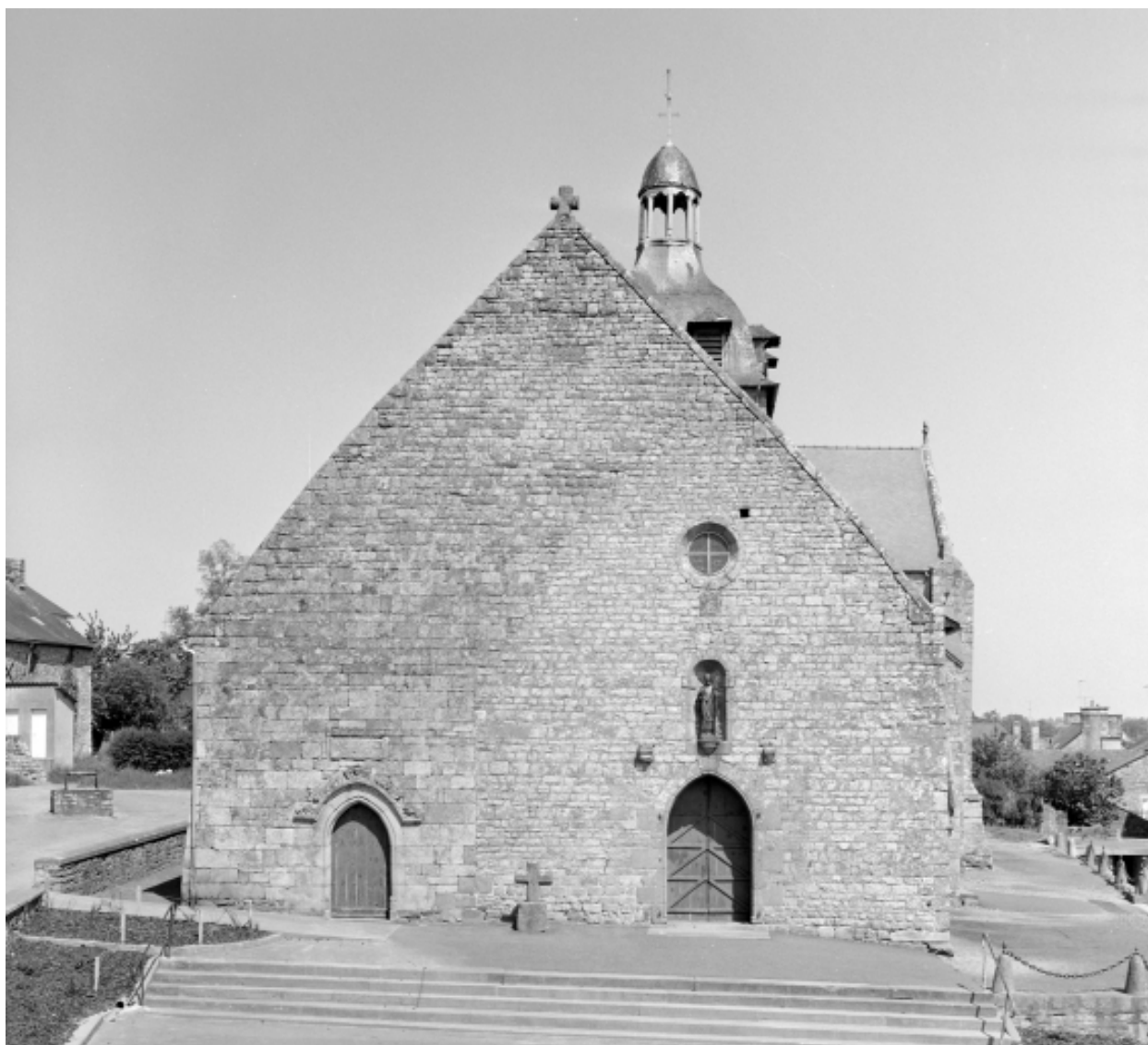
Elévation ouest, porte principale : vue générale
