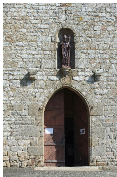
Porte ouest Phot. Norbert Lambart IVR53_20123500336NUCA
