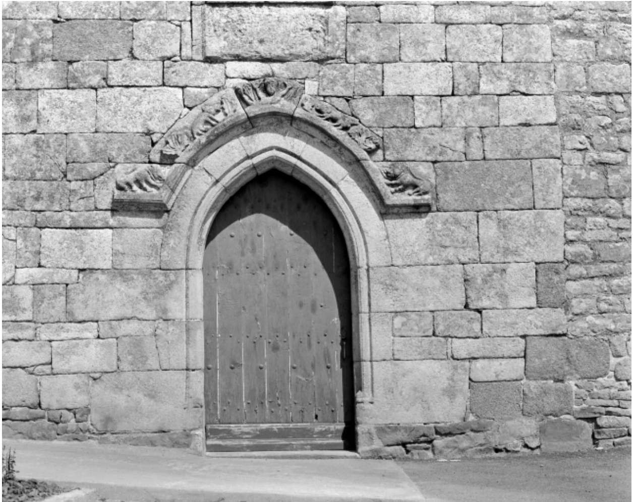
Elévation ouest, porte : vue générale
