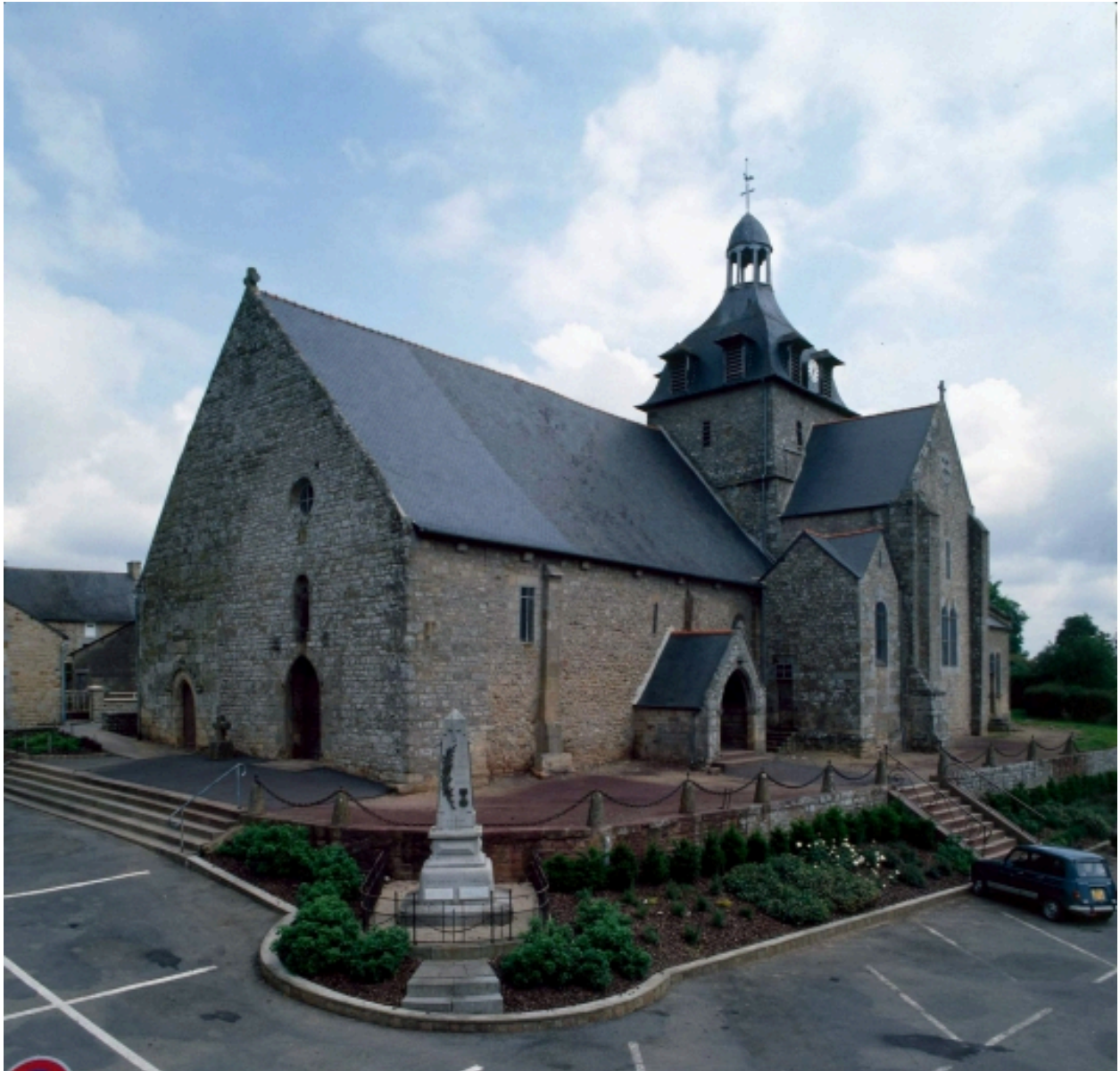
Elévation sud-ouest : vue générale
