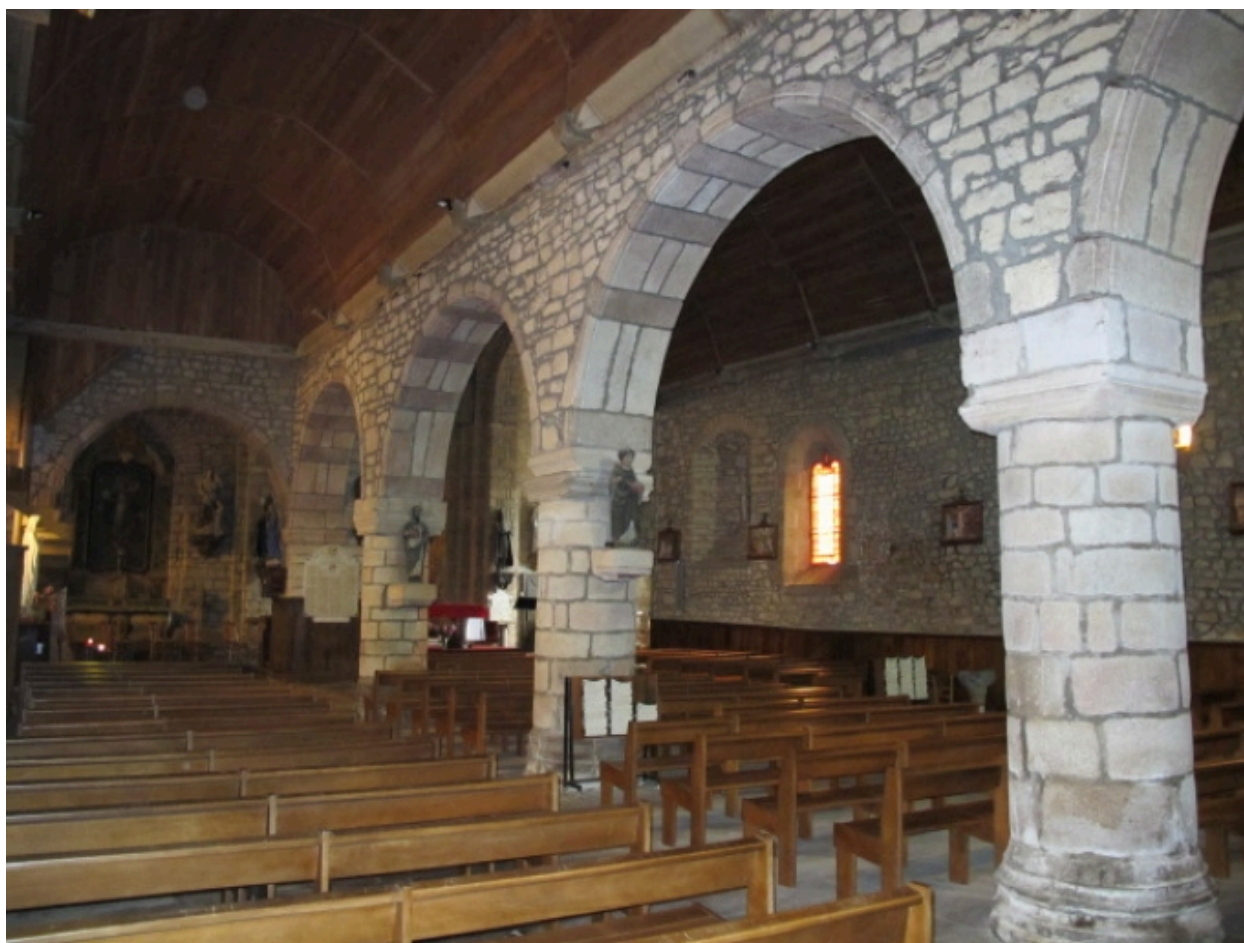
Vue générale intérieure
