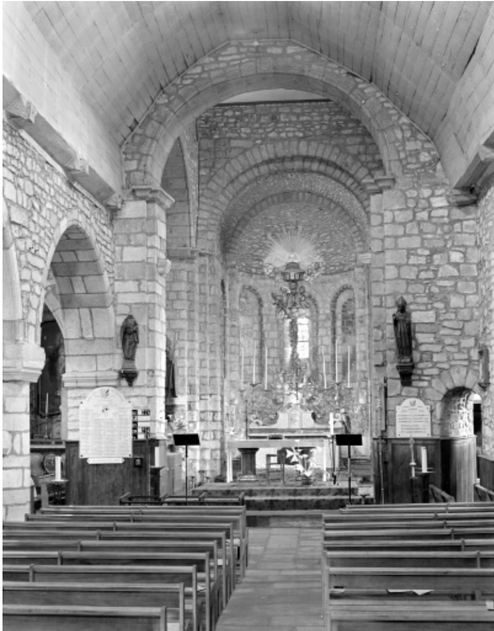
Vue générale vers le choeur
