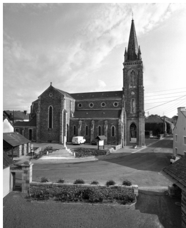
Vue générale sud Phot. Guy Artur, Phot. Norbert Lambart IVR53_19943505128X
