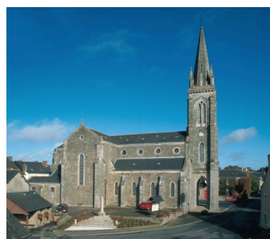
Vue générale sud Phot. Guy Artur, Phot. Norbert Lambart IVR53_20013523961XA
