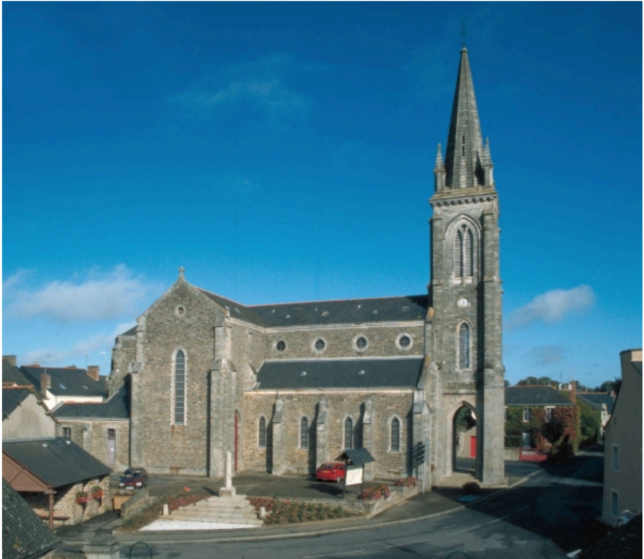
Vue générale sud
