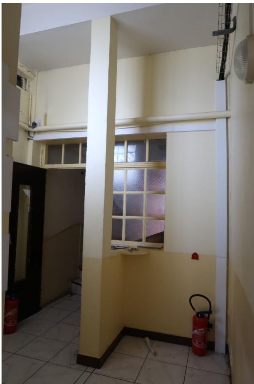
Intérieur, rez-de-chaussée, hall, partie ouest du bâtiment
