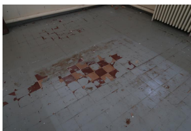
Intérieur, rez-de-chaussée, sol carrelé, puis peint (détail) Phot. Erwana L'Haridon IVR53_20212905754NUCA
