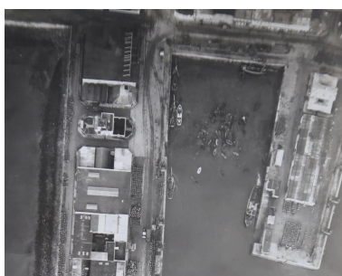
Vue aérienne, capitainerie et bureau des Ponts et Chaussées, juin 1932 Repro. Erwana L'Haridon IVR53_20212905832NUCB
