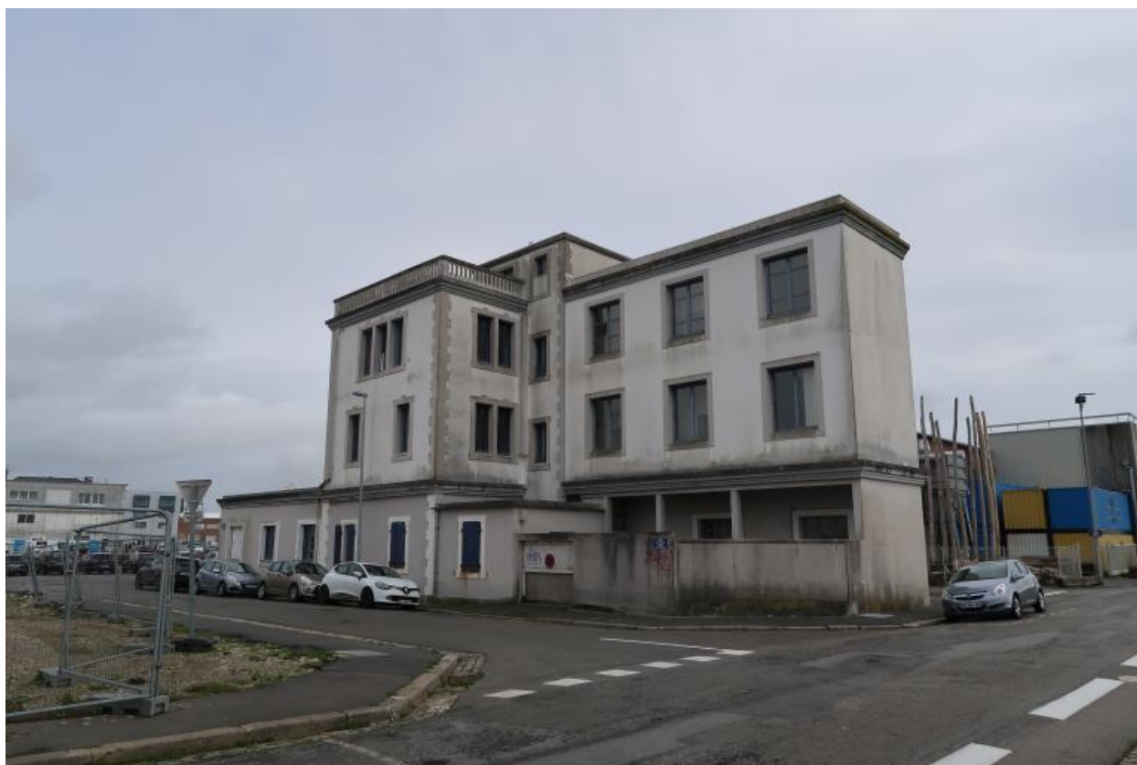
Ancienne capitainerie, élévation nord
