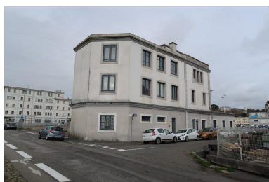
Ancienne capitainerie, élévation sud Phot. Erwana L'Haridon IVR53_20202905203NUCA
