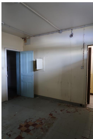
Intérieur, rez-de-chaussée, sol carrelé Phot. Erwana L'Haridon IVR53_20212905753NUCA
