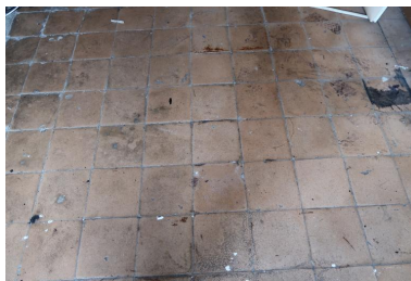
3e étage, tomettes Phot. Erwana L'Haridon IVR53_20212905776NUCA
