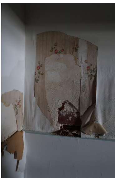
Intérieur, mur, parpaing de brique, enduit, papier peint Phot. Erwana L'Haridon IVR53_20212905752NUCA
