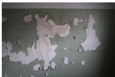
Intérieur, 3e étage, enduit Phot. Erwana L'Haridon IVR53_20212905771NUCA
