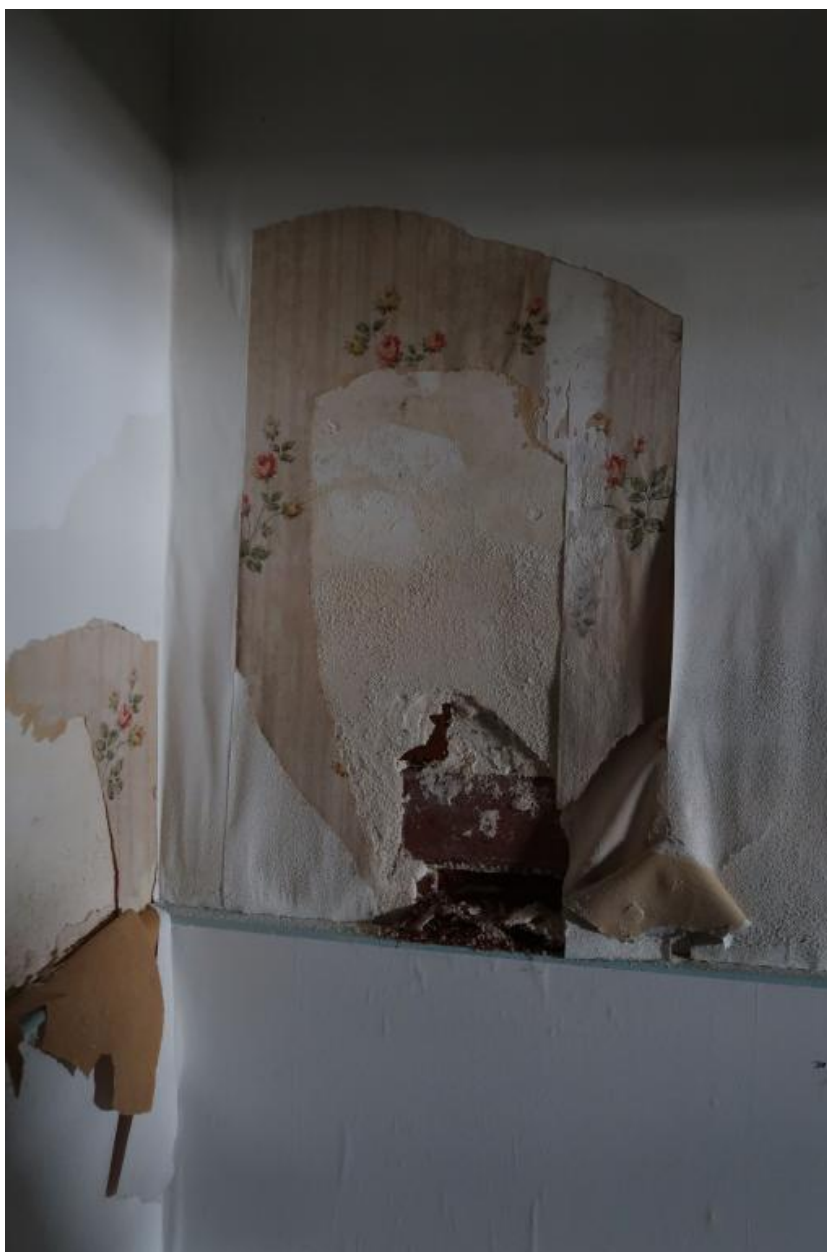
Intérieur, mur, parpaing de brique, enduit, papier peint
