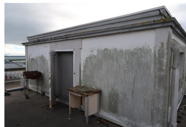
3e étage, depuis le toit terrasse Phot. Erwana L'Haridon IVR53_20212905775NUCA
