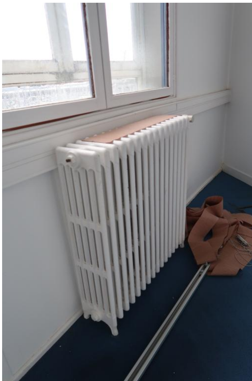
Intérieur, 1er étage, radiateur en fonte
