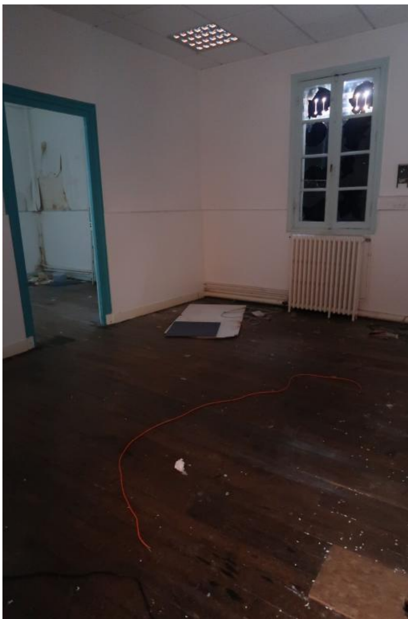
Intérieur, rez-de-chaussée, bureau, plancher
