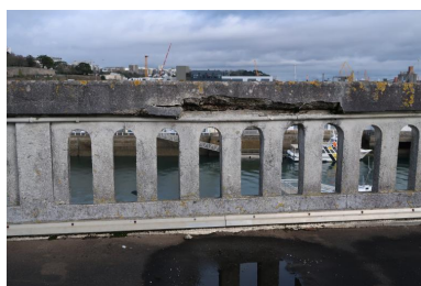
Toit terrasse, garde-corps béton Phot. Erwana L'Haridon IVR53_20212905774NUCA
