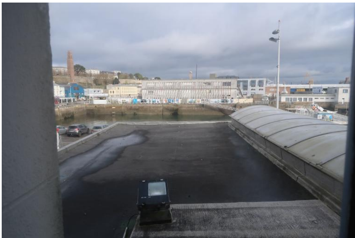
Depuis le 1er étage : toit terrasse du 1er niveau ; 1er bassin
