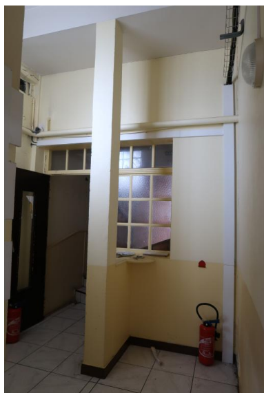
Intérieur, rez-de-chaussée, hall, partie ouest du bâtiment Phot. Erwana L'Haridon IVR53_20212905756NUCA
