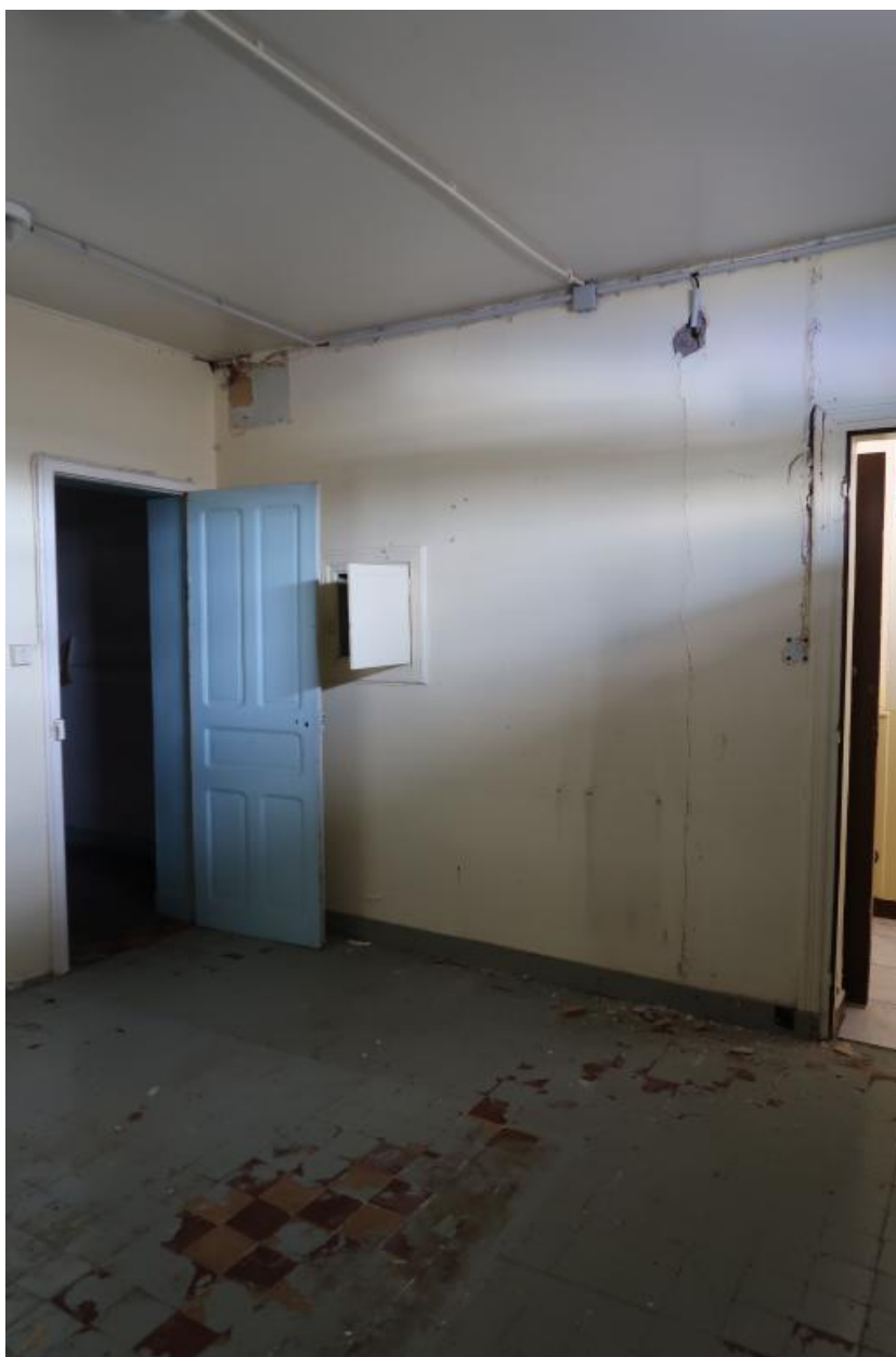
Intérieur, rez-de-chaussée, sol carrelé
