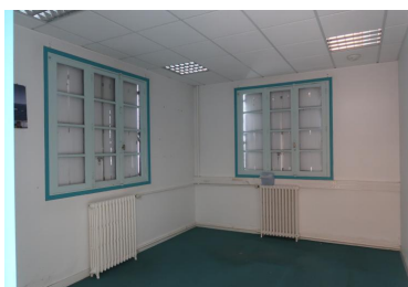
Intérieur, rez-de-chaussée, bureau Phot. Erwana L'Haridon IVR53_20212904749NUCA
