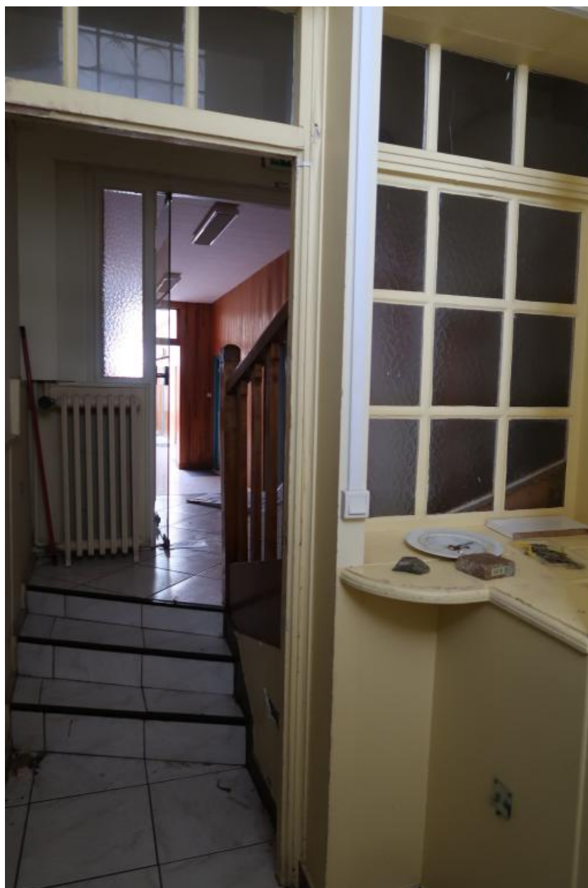
Intérieur, rez-de-chaussée, hall, cage d'escalier
