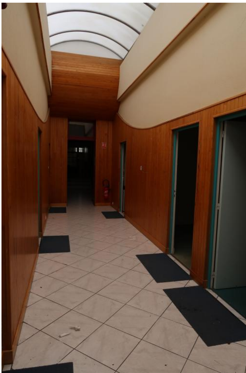
Intérieur, rez-de-chaussée, couloir desservant des bureaux, puits de lumière, couverture en polycarbonate
