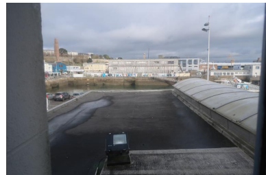
Depuis le 1er étage : toit terrasse du 1er niveau ; 1er bassin Phot. Erwana L'Haridon IVR53_20212905764NUCA
