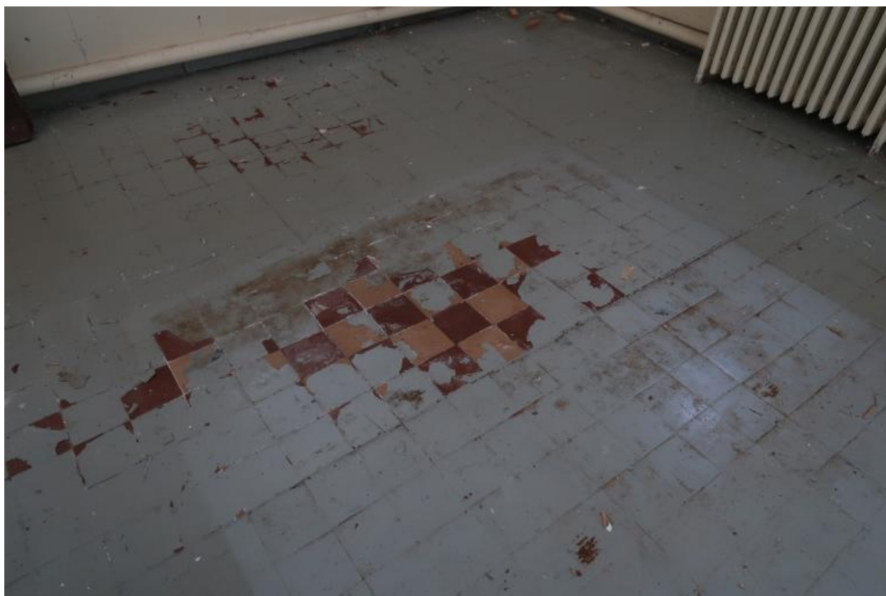
Intérieur, rez-de-chaussée, sol carrelé, puis peint (détail)
