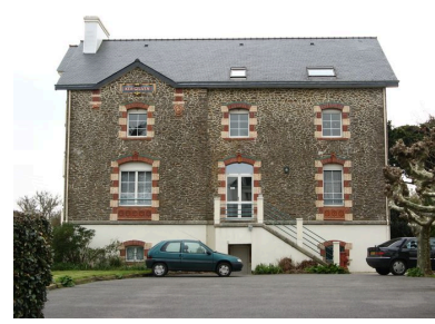
Façade principale de la résidence Ker Gelven Phot. Guillaume Marie IVR53_20072909043NUCA
