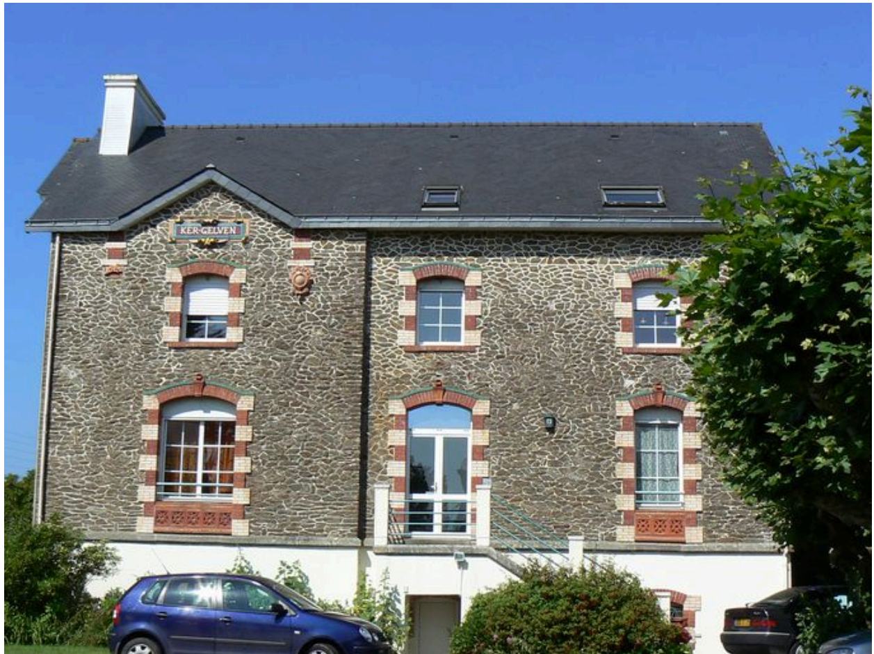
Vue générale de la résidence Ker Gelven
