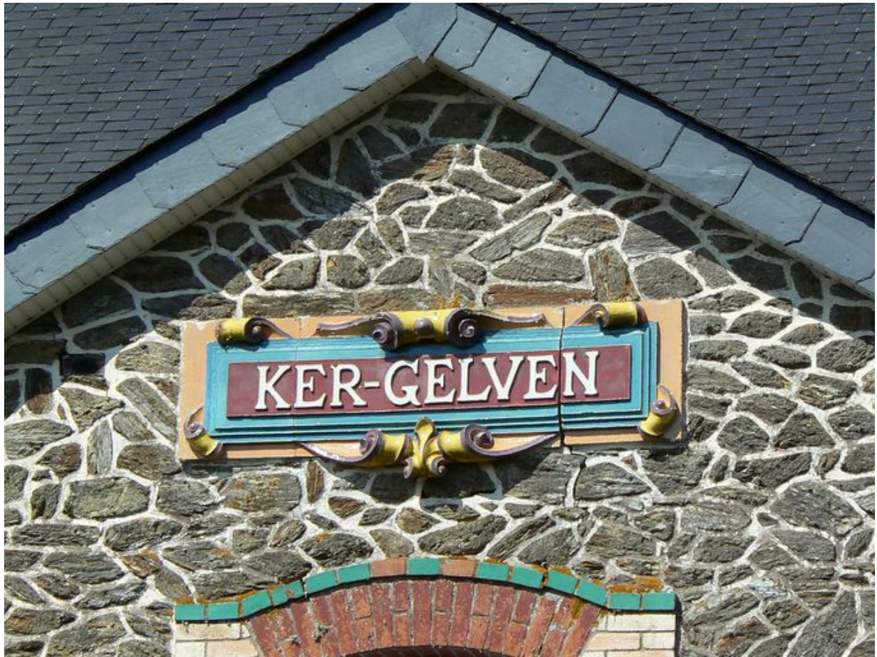
Plaque décorative indiquant le nom de la résidence sur le pignon coupé de la façade principale de la résidence Ker Gelven
