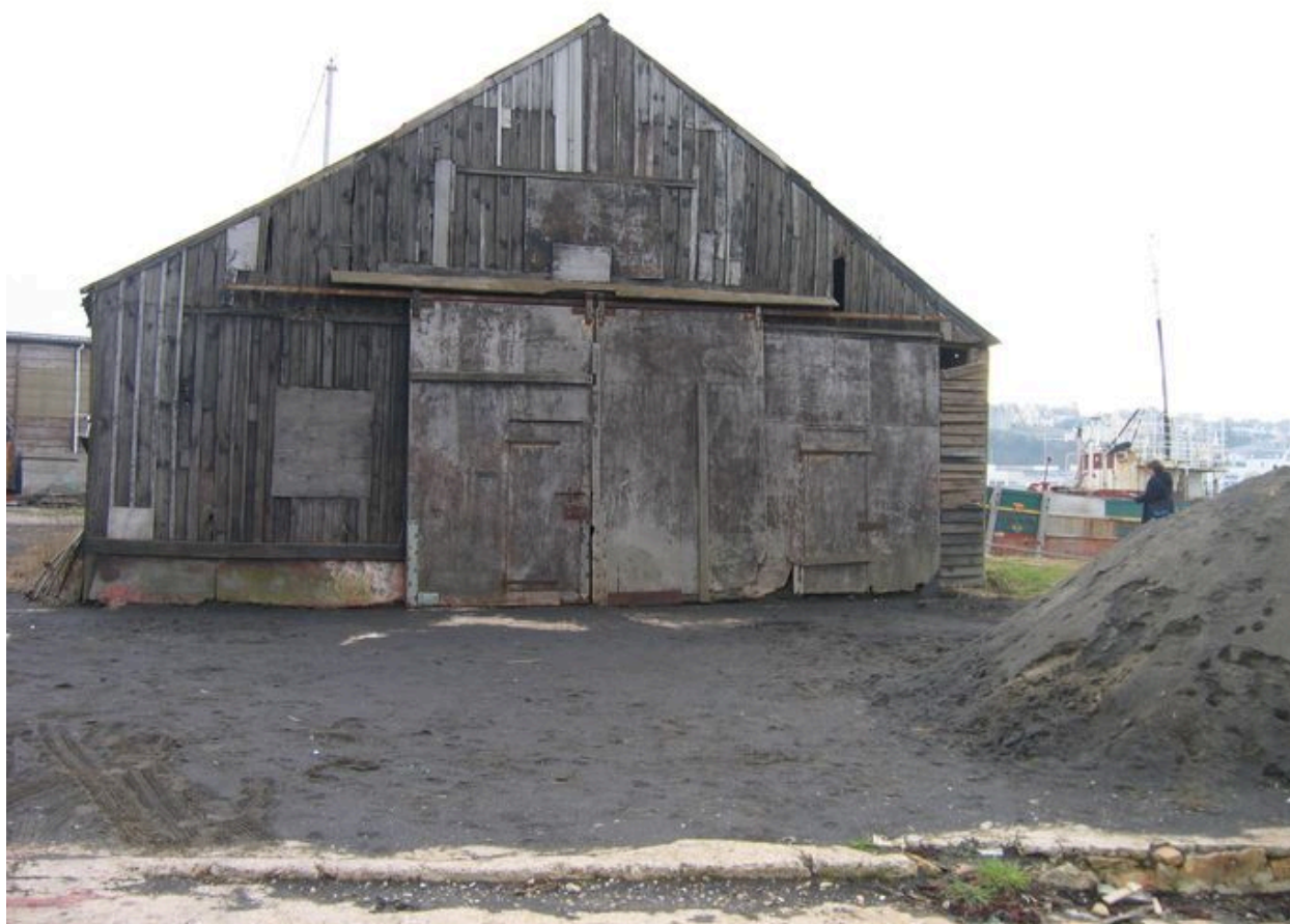
Vue latérale de la cabane de sablage
