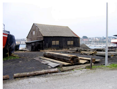
Vue générale de la cabane de sablage Phot. Françoise Péron IVR53_20062908371NUCA
