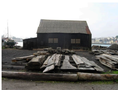
Elévation latérale de la cabane de sablage Phot. Iwan Le Berre IVR53_20062908286NUCA
