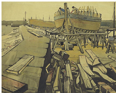
Le chantier de Keraudren, Pierre Péron, 1931 Repro. Guillaume Marie, Autr. Pierre Péron IVR53_20072908592NUCA
