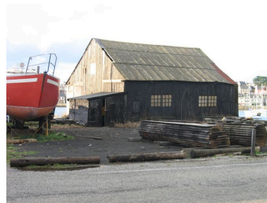
Vue générale de la cabane de sablage des Charpentiers de Marine Camarétois Phot. Françoise Péron IVR53_20062908375NUCA
