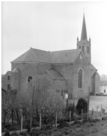
Elévation Sud-Ouest : vue générale Phot. Guy Artur, Phot. Norbert Lambart IVR53_19943500813X
