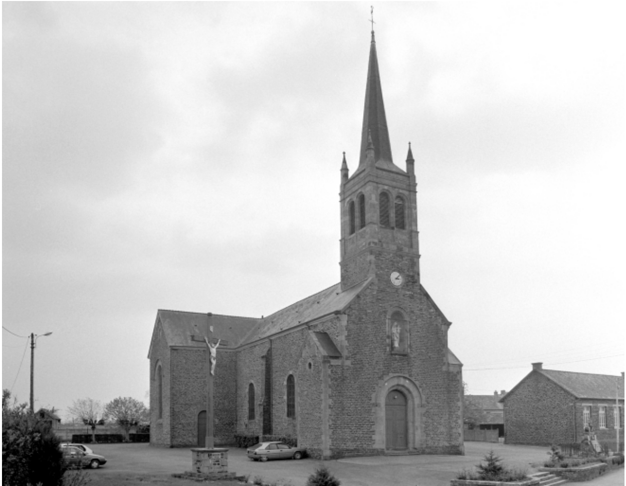
Elévation Nord-Est : vue générale
