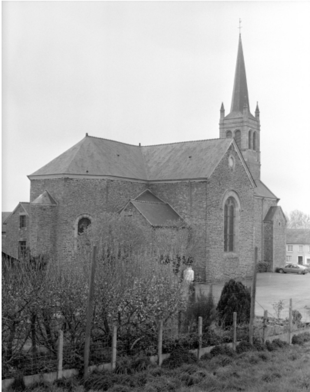
Elévation Sud-Ouest : vue générale
