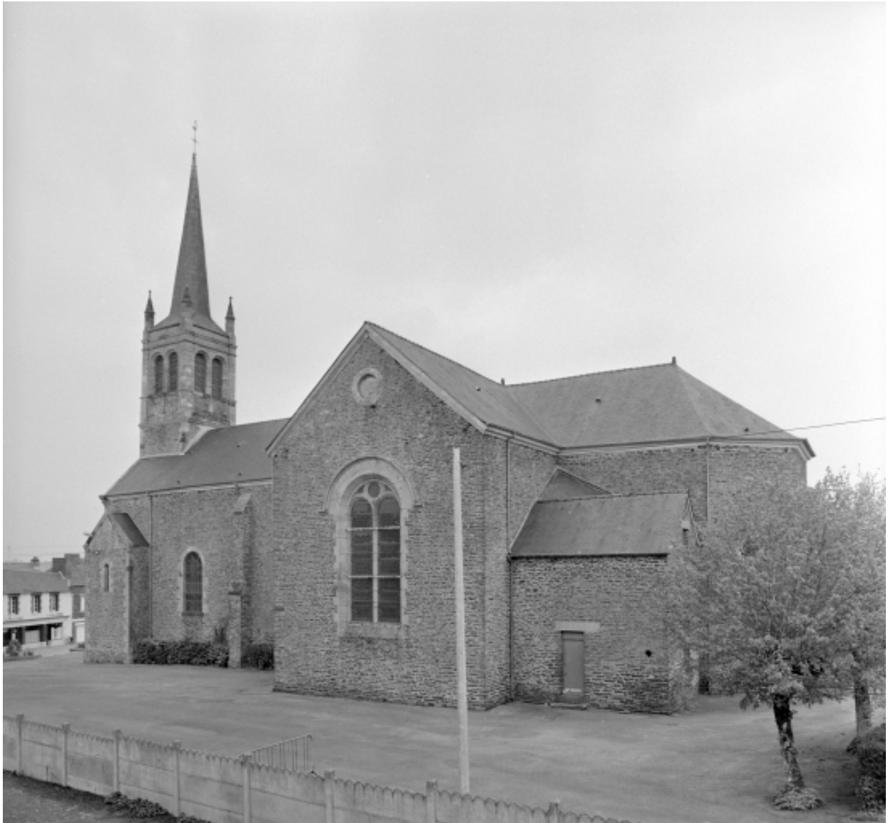
Elévation Ouest : vue générale
