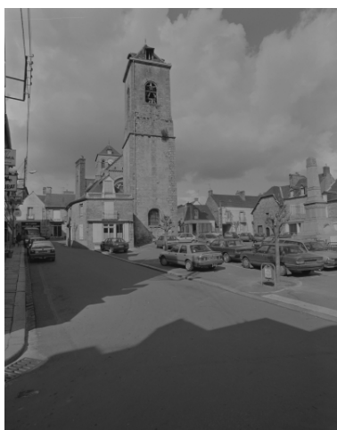
Elévation Sud : vue de situation Phot. Bernard Bègne, Phot. M. Loyon IVR53_19933500369X
