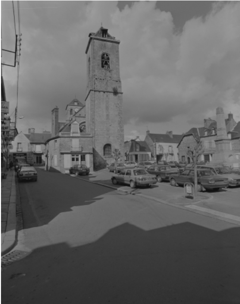
Elévation Sud : vue de situation
