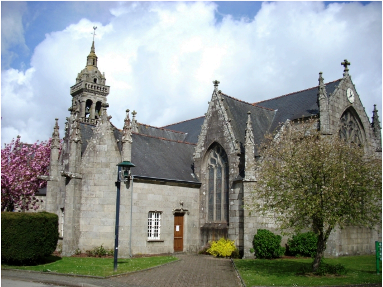
Plonévez-du-Faou, église paroissiale Saint-Pierre : vue générale sud-est
