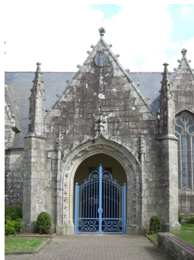
Plonévez-du-Faou, église paroissiale Saint-Pierre : détail, porche sud Phot. Gwénaél Fauchille IVR53_20082905749NUCA
