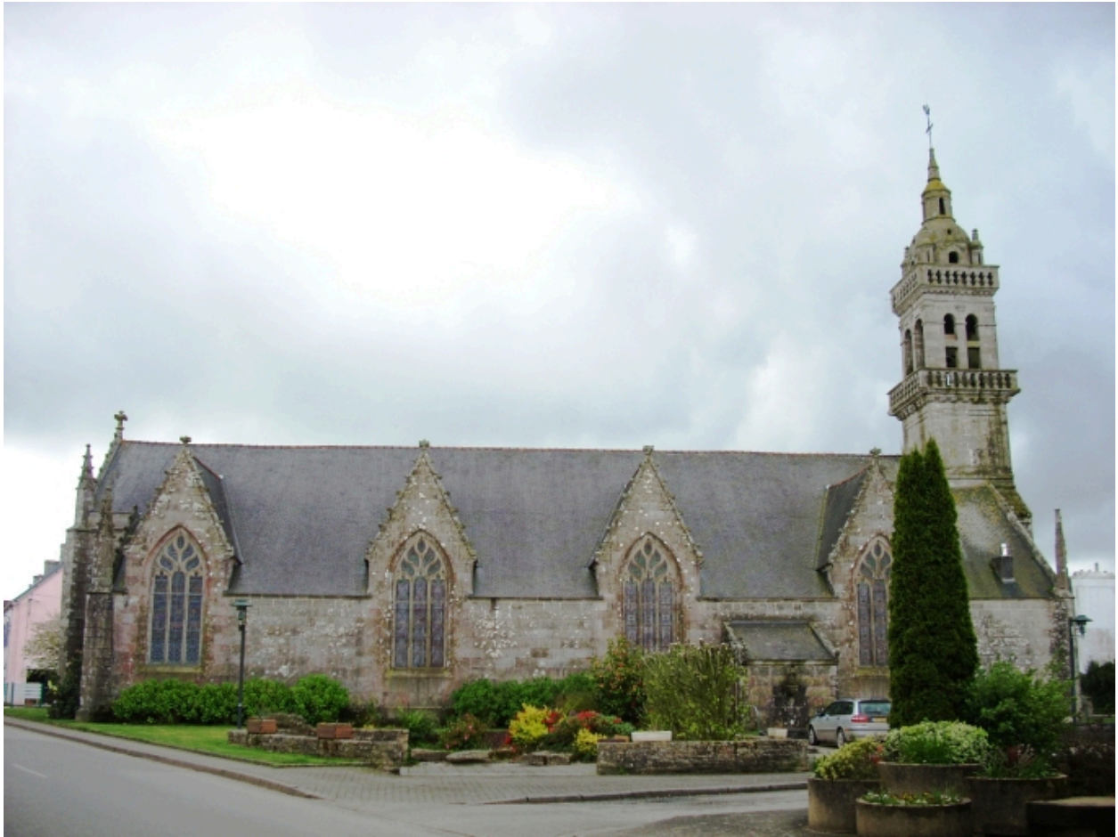
Plonévez-du-Faou, église paroissiale Saint-Pierre : élévation nord
