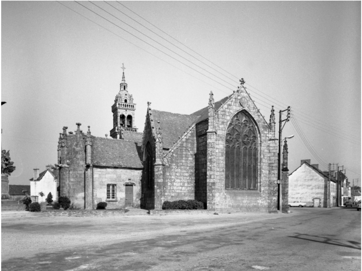
Plonévez-du-Faou, église paroissiale Saint-Pierre : vue générale est, état en 1967
