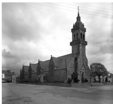
Plonévez-du-Faou, église paroissiale Saint-Pierre : vue générale nord-ouest, état en 1967 Phot. François Dagorn IVR53_19672900251V
