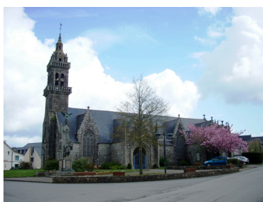
Plonévez-du-Faou, église paroissiale Saint-Pierre : vue générale sud-ouest Phot. Gwénaél Fauchille IVR53_20082905745NUCA
