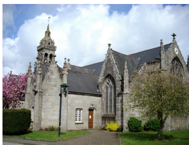
Plonévez-du-Faou, église paroissiale Saint-Pierre : vue générale sud-est Phot. Gwénaél Fauchille IVR53_20082905748NUCA
