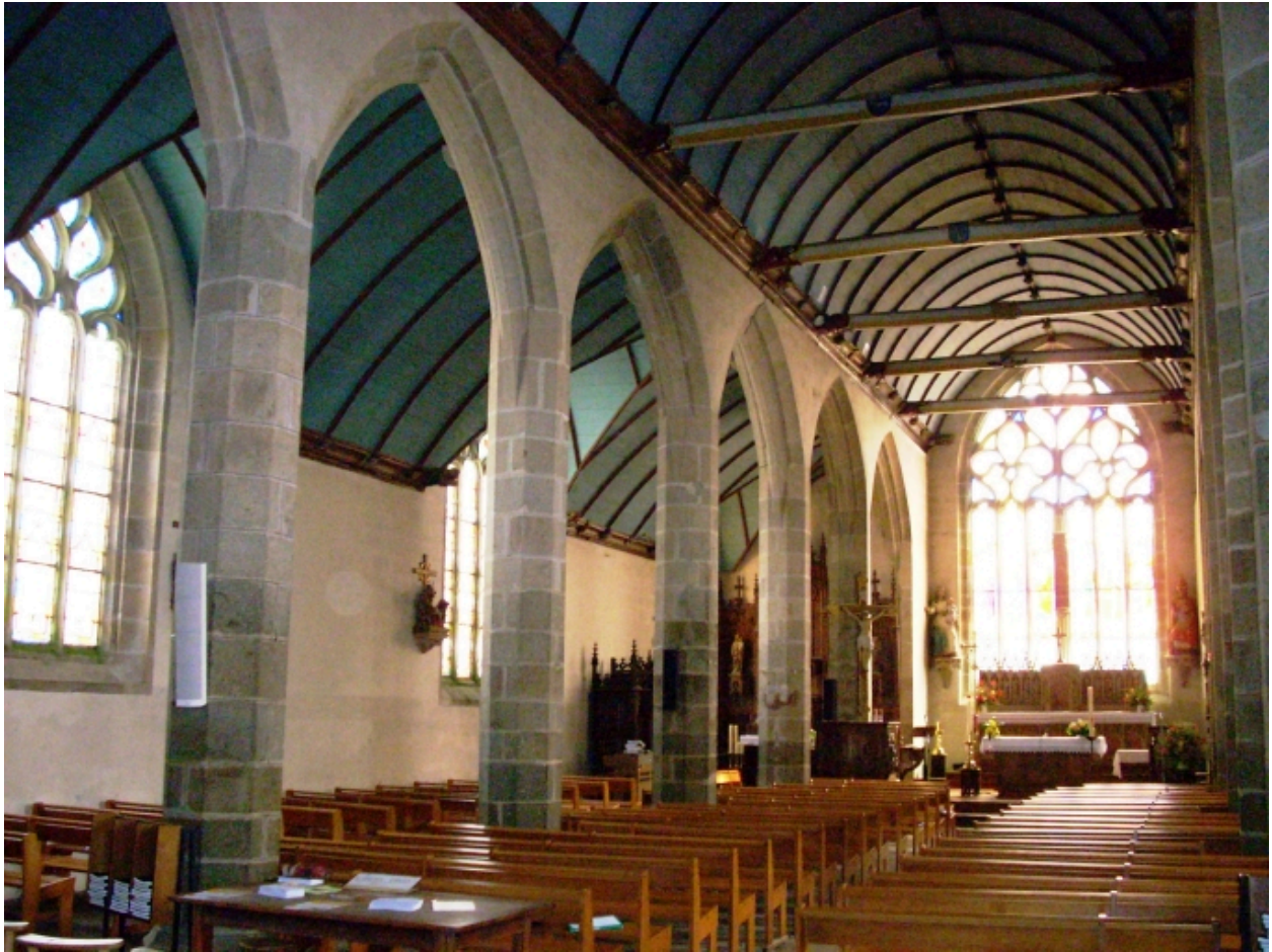
Plonévez-du-Faou, église paroissiale Saint-Pierre : vue transversale nord-est
