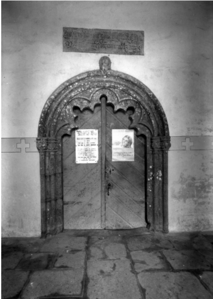
Plonévez-du-Faou, église paroissiale Saint-Pierre : porte du porche sud, état en 1967
