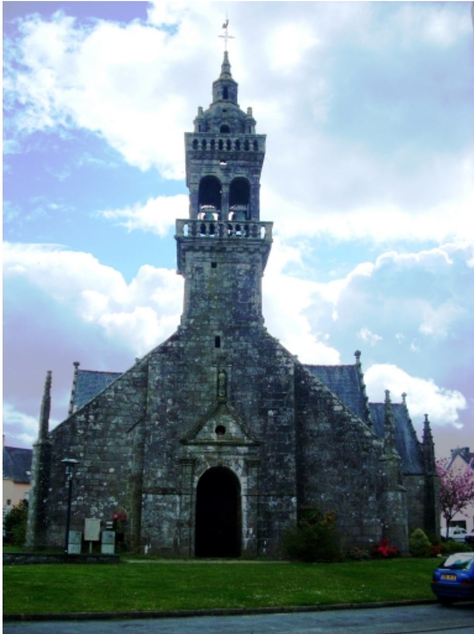
Plonévez-du-Faou, église paroissiale Saint-Pierre : élévation ouest
