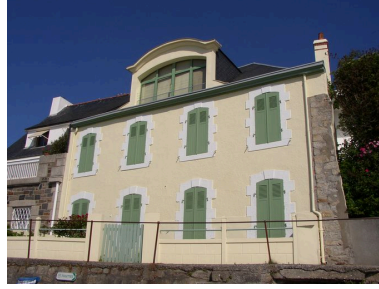
Maison de villégiature du 13 rue des Goëlands Phot. Johan Vincent IVR53_20065606523NUCA
