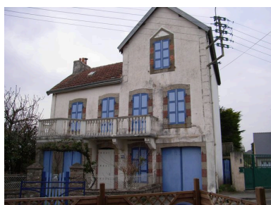
Vue générale de la villa 15 rue des Grands-Sables Phot. Florence Despretz IVR53_20072909066NUCA
