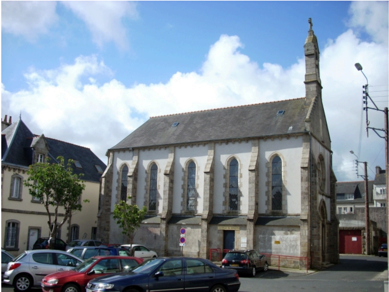
Lesneven, chapelle Saint-Joseph : vue générale nord-ouest
