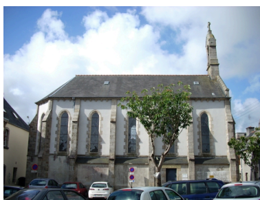
Lesneven, chapelle Saint-Joseph : élévation nord Phot. Gwénaél Fauchille IVR53_20082906341NUCA
