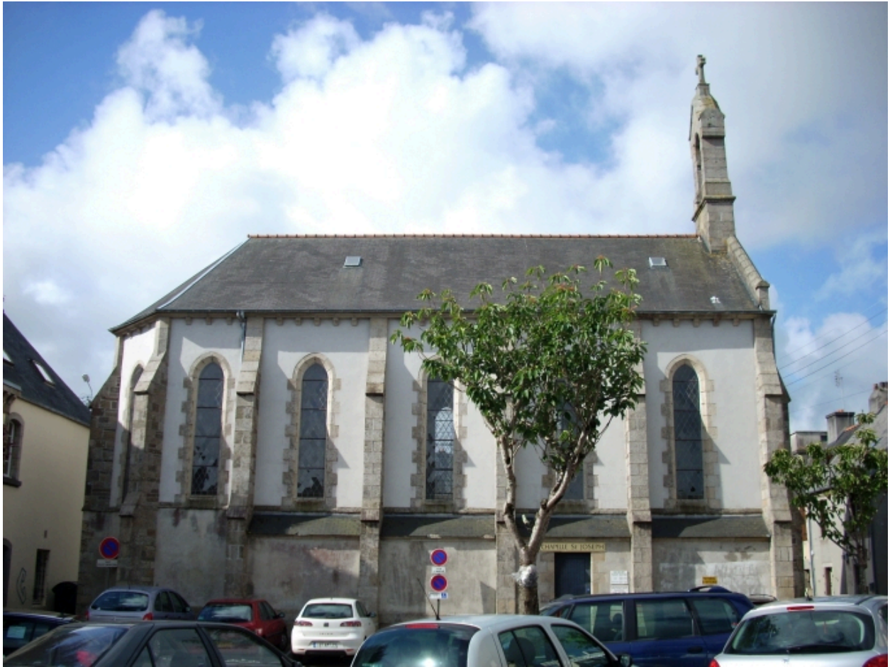
Lesneven, chapelle Saint-Joseph : élévation nord
