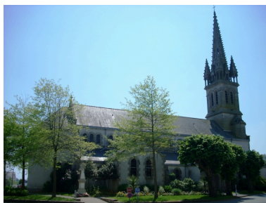
Plomelin, église paroissiale : vue générale nord-est Phot. Gwénaél Fauchille IVR53_20082905928NUCA
