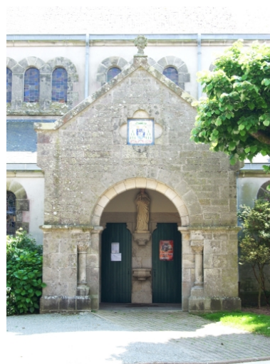
Plomelin, église paroissiale : porche sud Phot. Gwénaél Fauchille IVR53_20082905932NUCA
