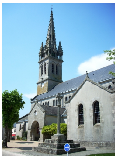
Plomelin, église paroissiale : monument aux morts et porche sud depuis l'est Phot. Gwénaél Fauchille IVR53_20082905931NUCA
