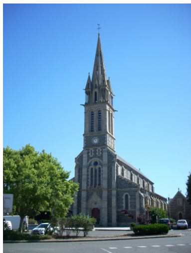
Taulé, église paroissiale Saint-Pierre : vue générale sud-ouest Phot. Gwénaél Fauchille IVR53_20082906621NUCA
