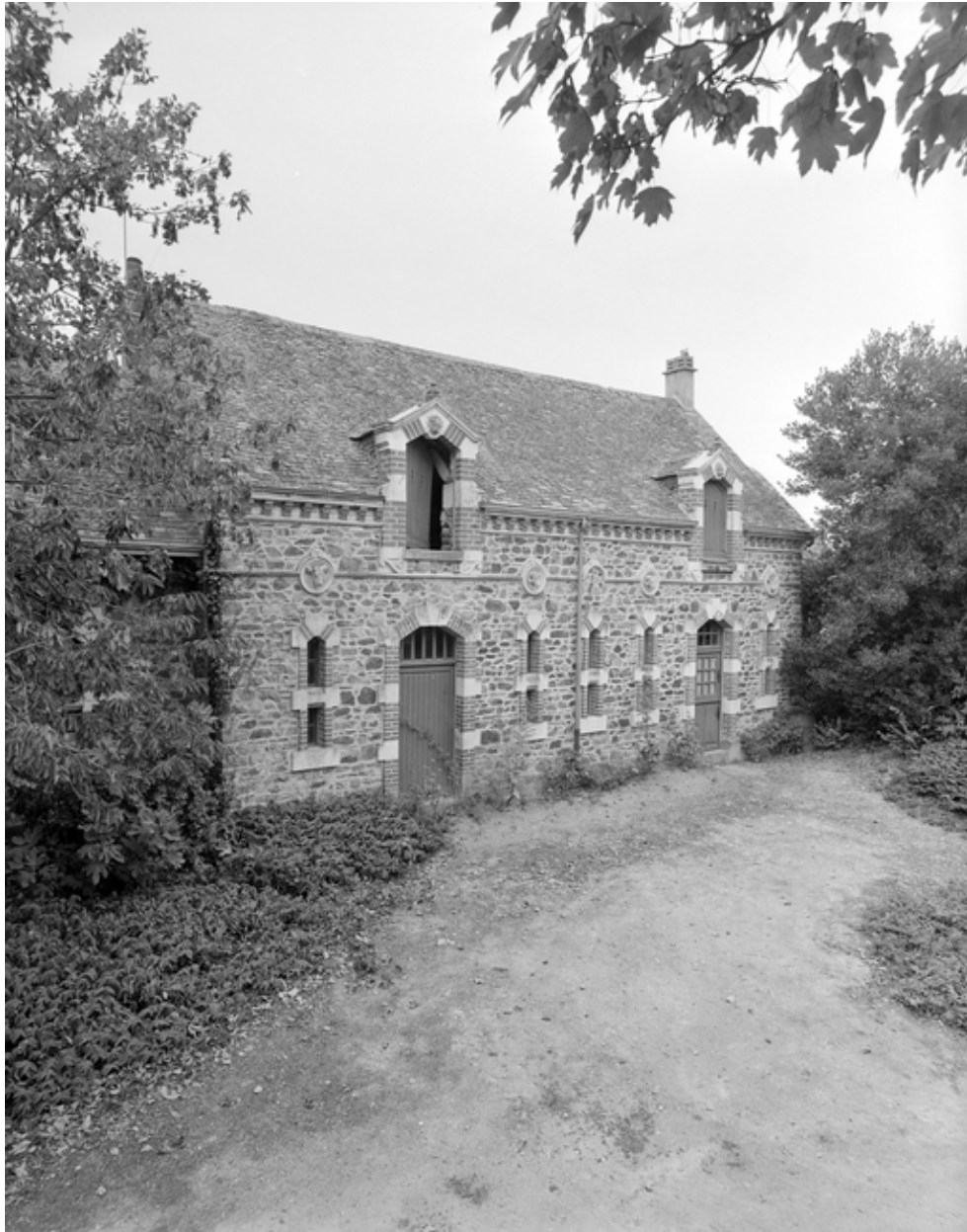
Communs : vue générale du bâtiment nord-est.
