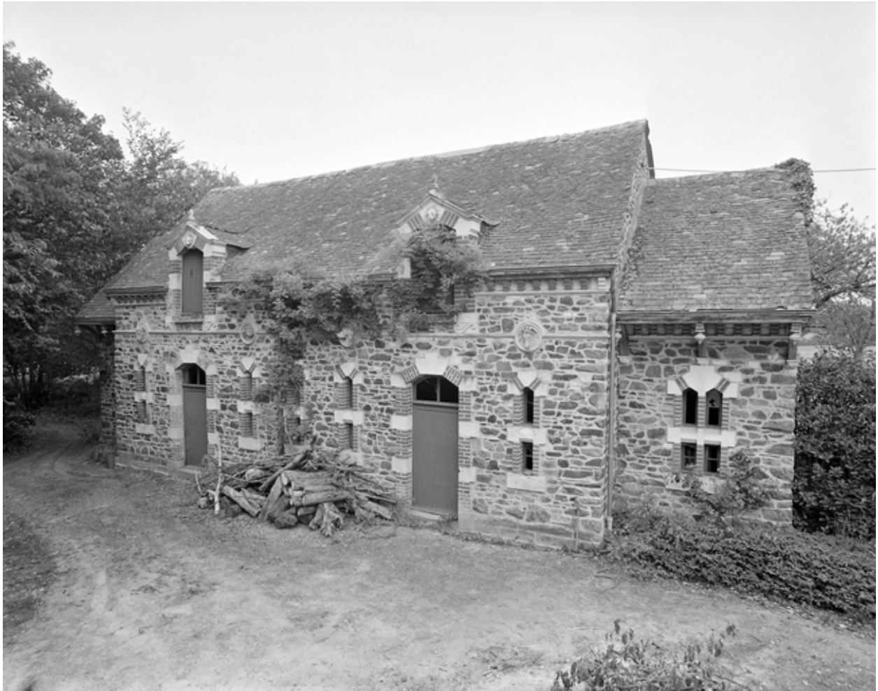
Communs : vue générale du bâtiment nord-est.
