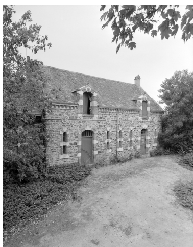
Communs : vue générale du bâtiment nord-est.
