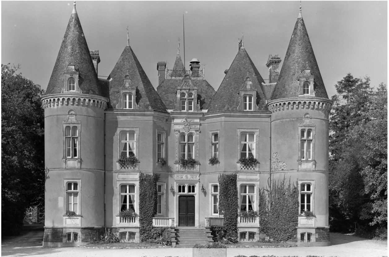
Vue générale du château.
