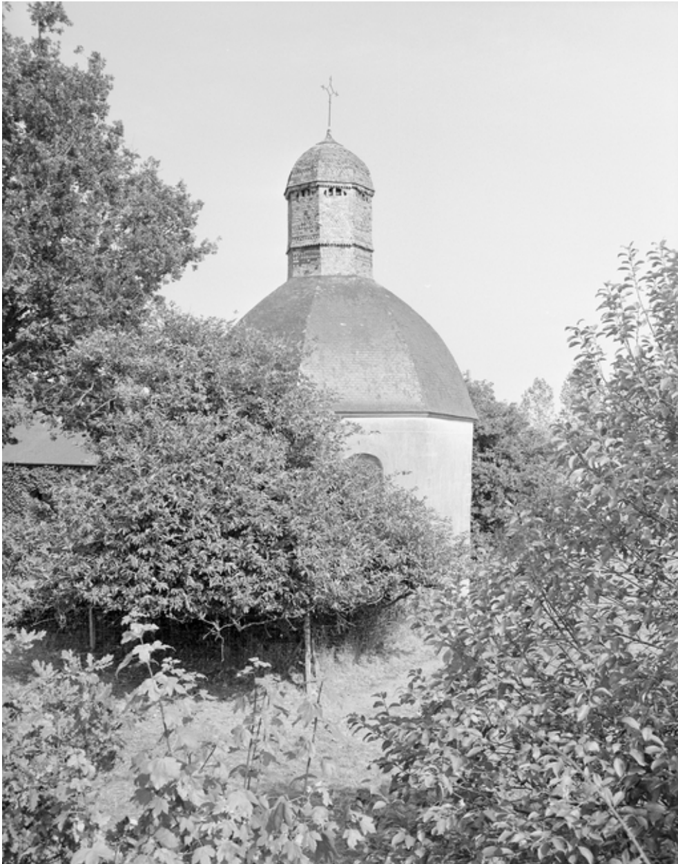
Vue générale de la chapelle à l'entrée du parc.
