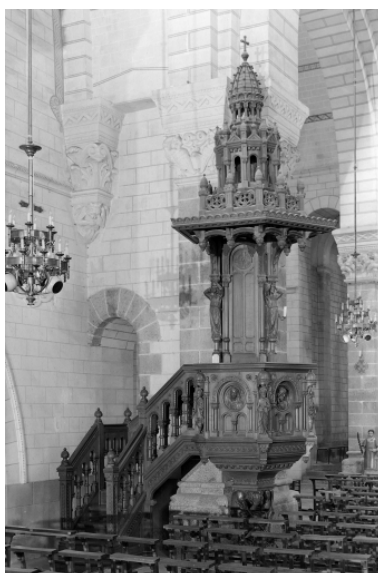
Vue intérieure de la partie gauche avec la chaise à prêcher. Phot. Auteur inconnu IVR53_19973504693V
