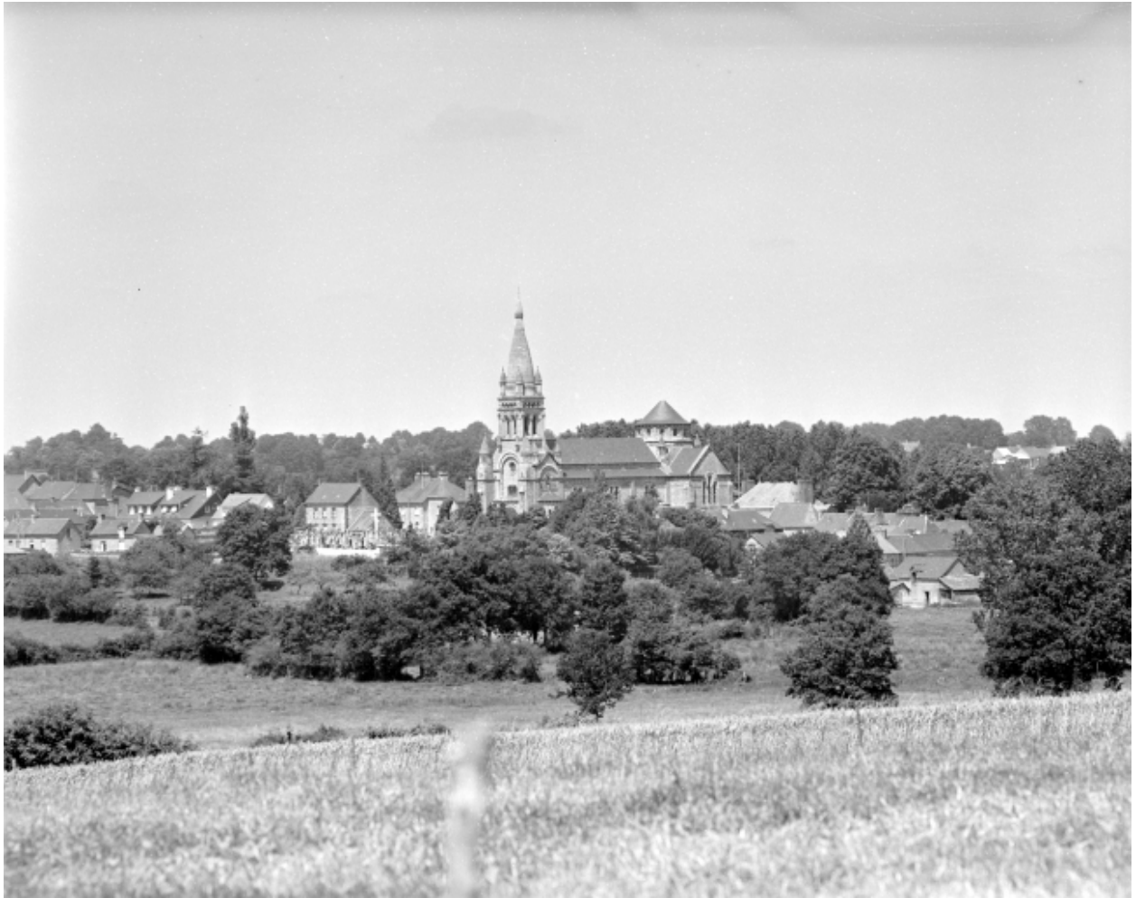
Vue de situation prise du sud-est.
