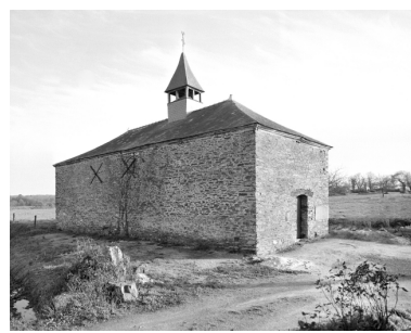
Vue générale nord ouest Phot. Bernard Bègne, Phot. M. Loyon IVR53_19923500993X
