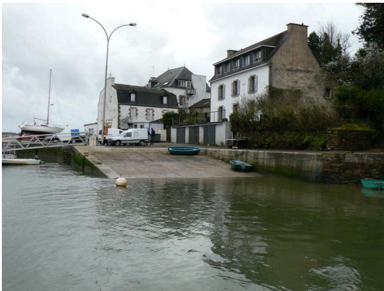
Vue générale du front portuaire du Pouldu
