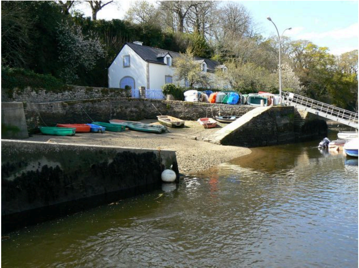
Vue générale du front portuaire du Pouldu
