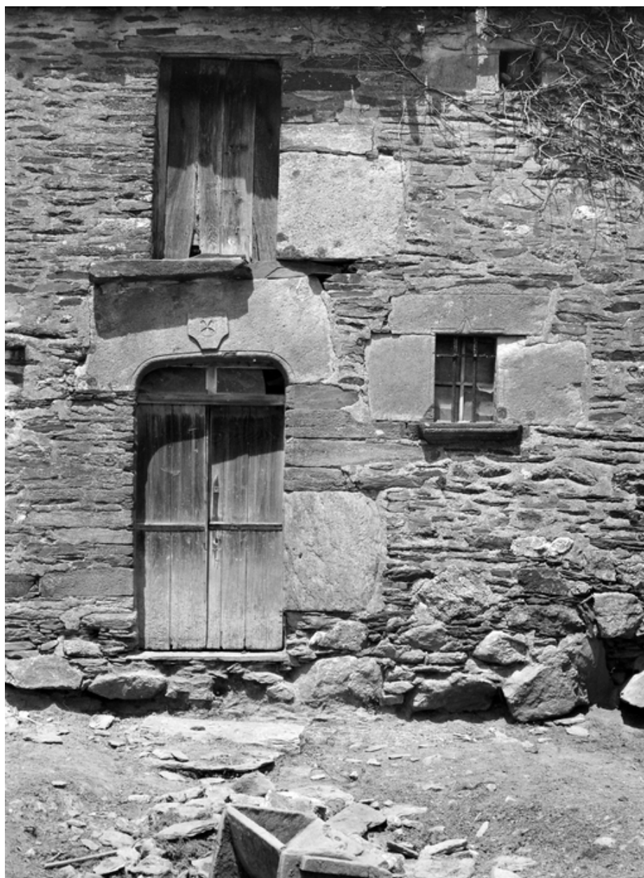
Maison, élévation sud : les baies (état en 1983)
