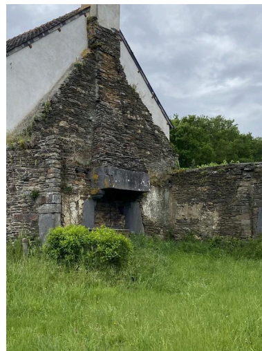
Ancienne cheminée côté ouest. Phot. Baptiste Oligo IVR53_20255610240NUCA
