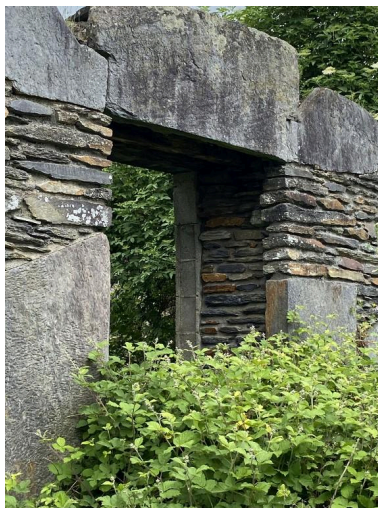
Les fondations ont été fortifiées avec du béton pour que l'édifice ne s'écroule pas totalement, vue sud-ouest. Phot. Baptiste Oligo IVR53_20255610244NUCA
