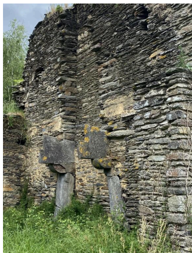
Ancienne cheminée côté est. Phot. Baptiste Oligo IVR53_20255610242NUCA
