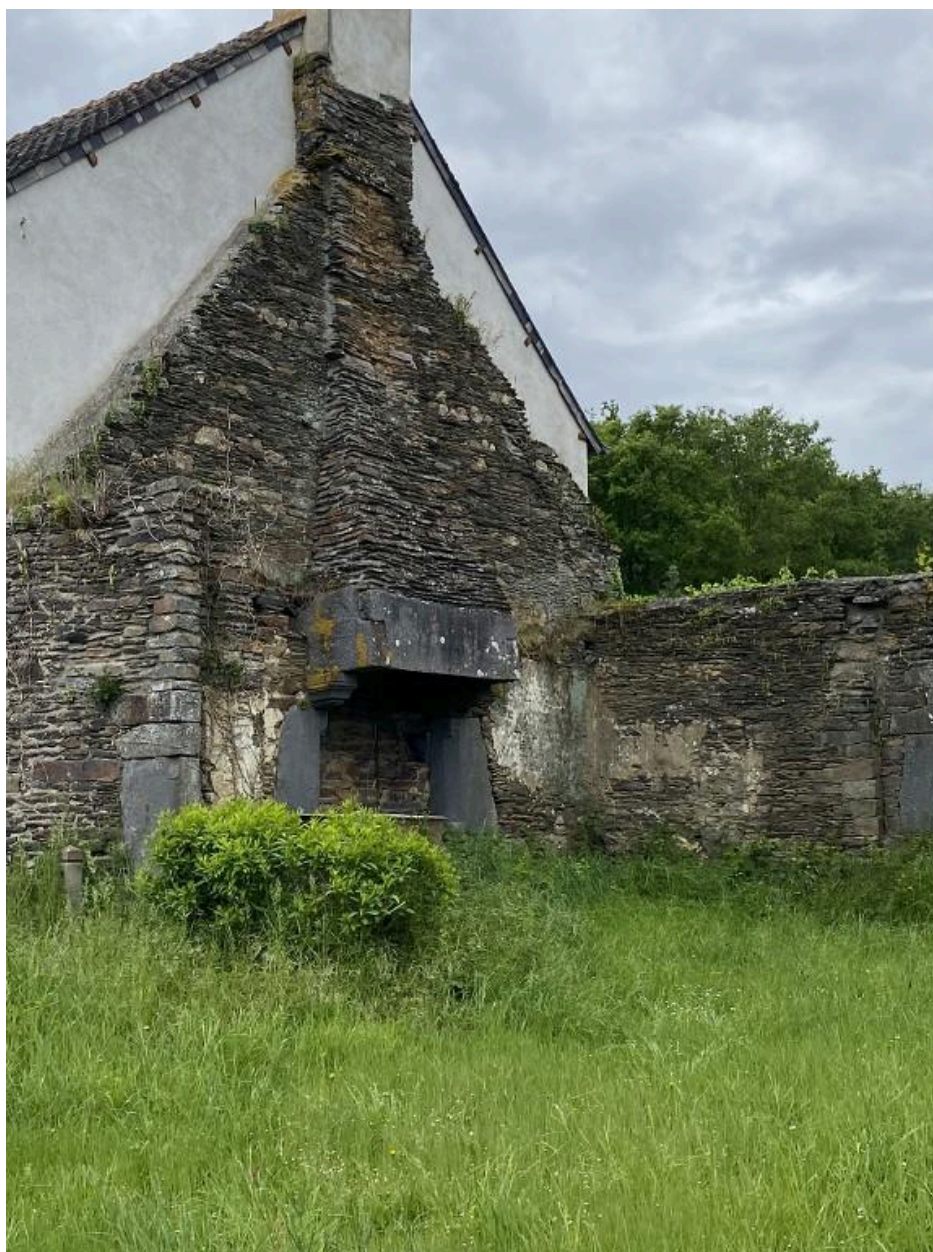
Ancienne cheminée côté ouest.
