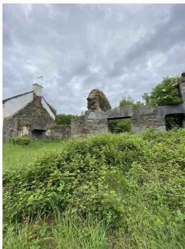
Vue sud-est. Phot. Baptiste Oligo IVR53_20255610235NUCA
