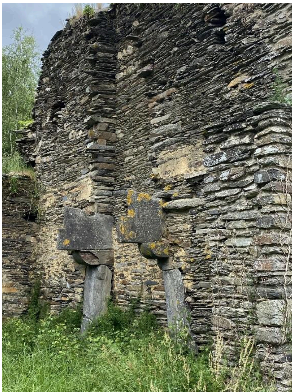
Ancienne cheminée côté est.
