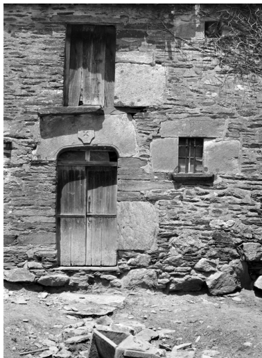
Maison, élévation sud : les baies (état en 1983) Phot. Jean-Pierre Ducouret IVR53_19835600242X
