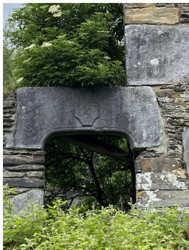
Vue sud sur le linteau de la porte d'entrée. Phot. Baptiste Oligo IVR53_20255610237NUCA
