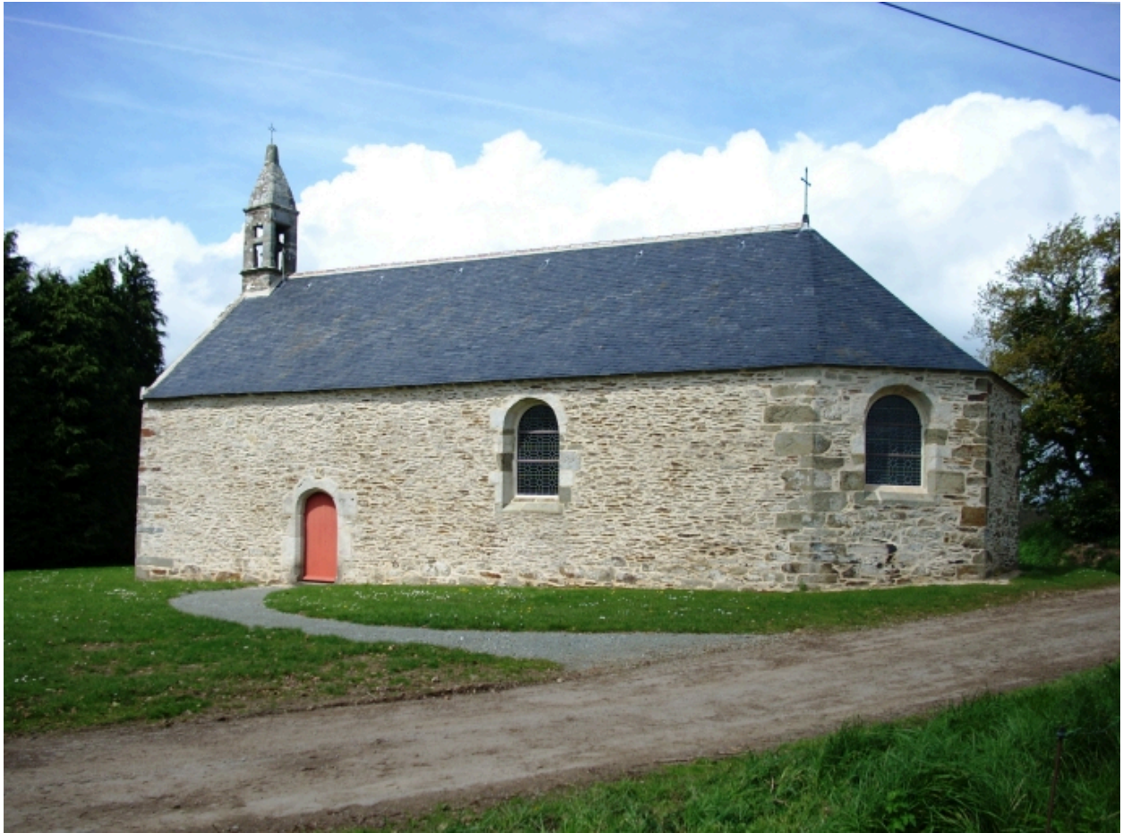
Kergloff, chapelle Notre-Dame-de-Bon-Secours : vue générale sud-est
