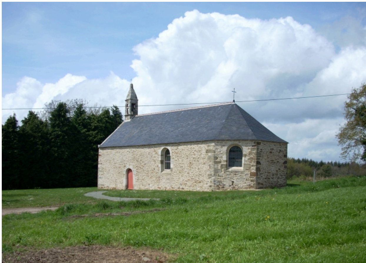
Kergloff, chapelle Notre-Dame-de-Bon-Secours : vue générale sud-est
