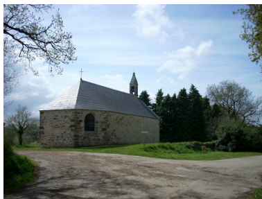
Kergloff, chapelle Notre-Dame-de-Bon-Secours : vue générale nord-est Phot. Gwénaél Fauchille IVR53_20082905735NUCA
