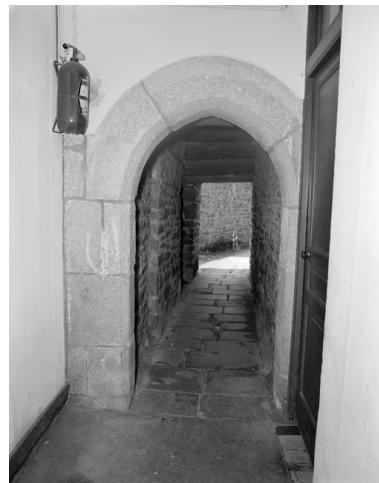
Couloir du rez-de-chaussée Phot. Guy Artur IVR53_19742200520X
