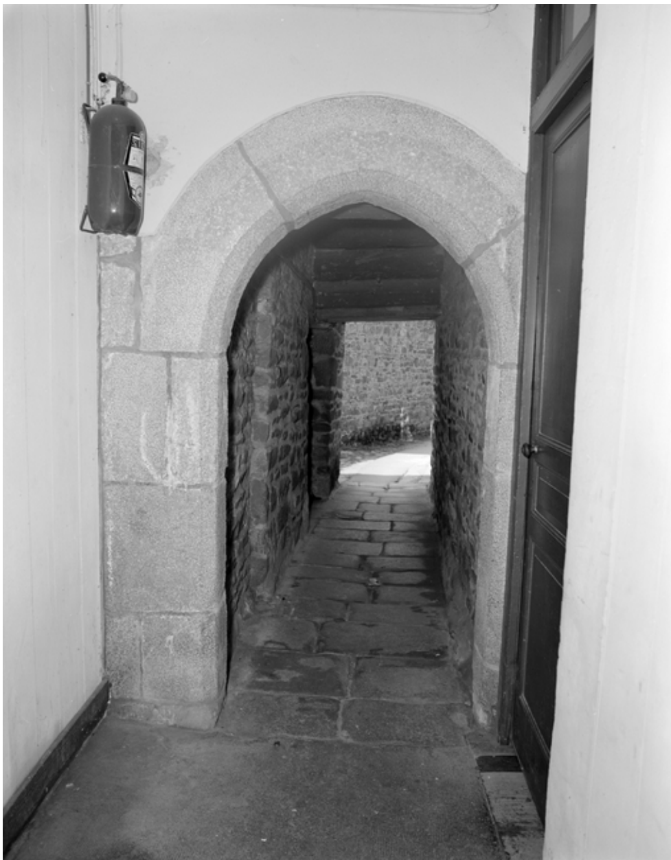
Couloir du rez-de-chaussée
