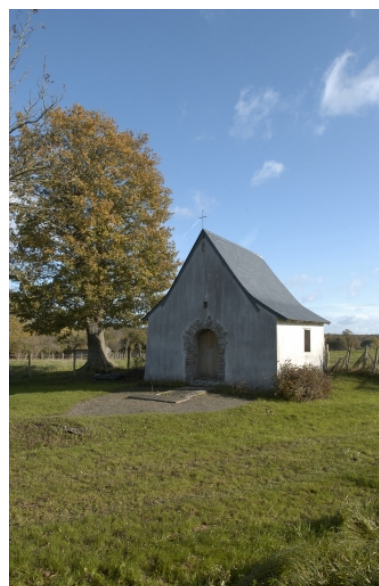
Vue sud-ouest Phot. Norbert Lambart IVR53_20043502414NUCA
