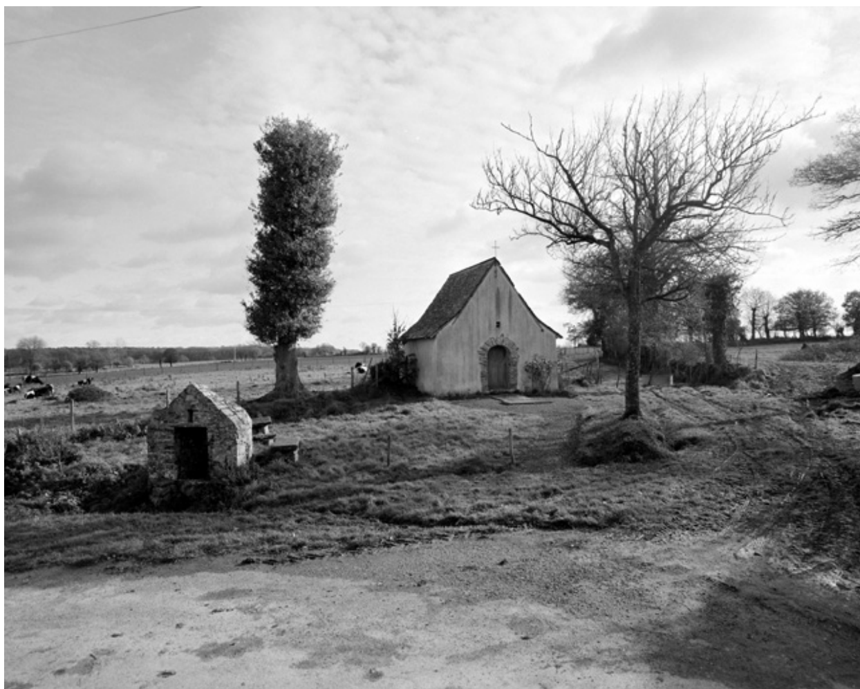
Elévation Ouest : vue de situation
