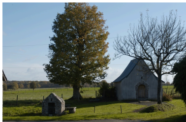
Vue nord-ouest Phot. Norbert Lambart IVR53_20043502409NUCA
