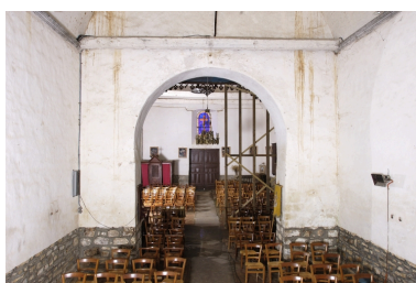
Vue intérieure prise du chœur vers la nef Phot. Alain Dagorn IVR53_20053501651NUCA
