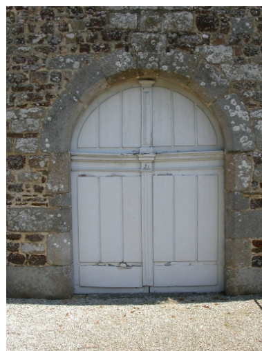
La porte d'entrée Phot. Sabrina Dalibard IVR53_20053517079NUCA
