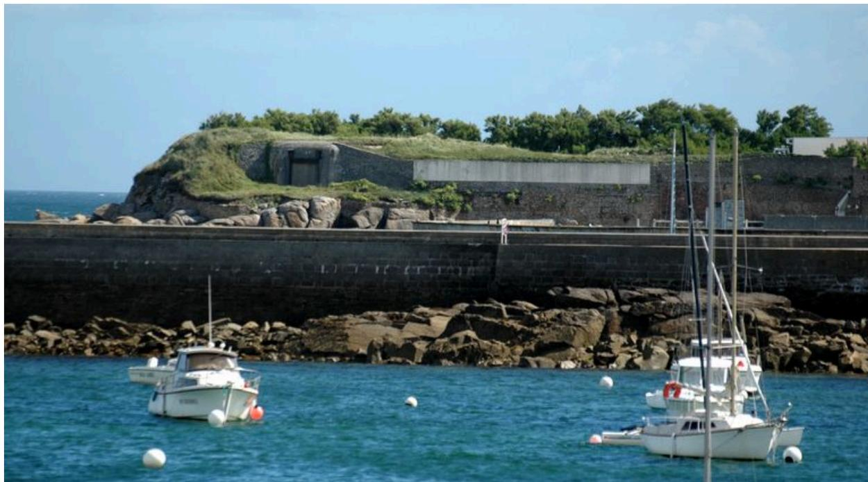
Vue de l'extrémité nord du Fort Bloscon : bunker - casemate de type 611 flanqué de murs en maçonnerie de moellon de granite (état en 2004). Au premier plan, la digue des viviers
