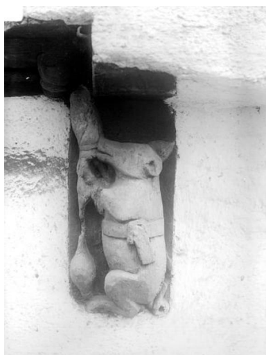
Rez-de-chaussée, console sculptée : truie qui file (état avant 1919) Phot. Guernane IVR53_20155606056NUCB
