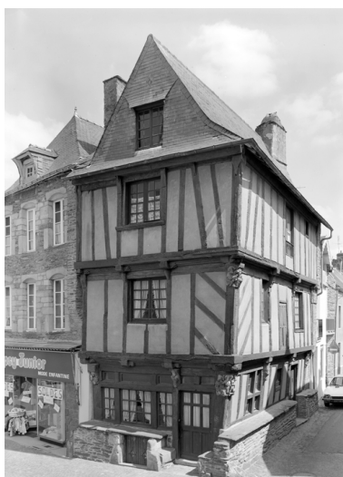
Vue prise du sud-ouest (état en 1984) Phot. Guy Artur, Phot. Norbert Lambart IVR53_19845600870V
