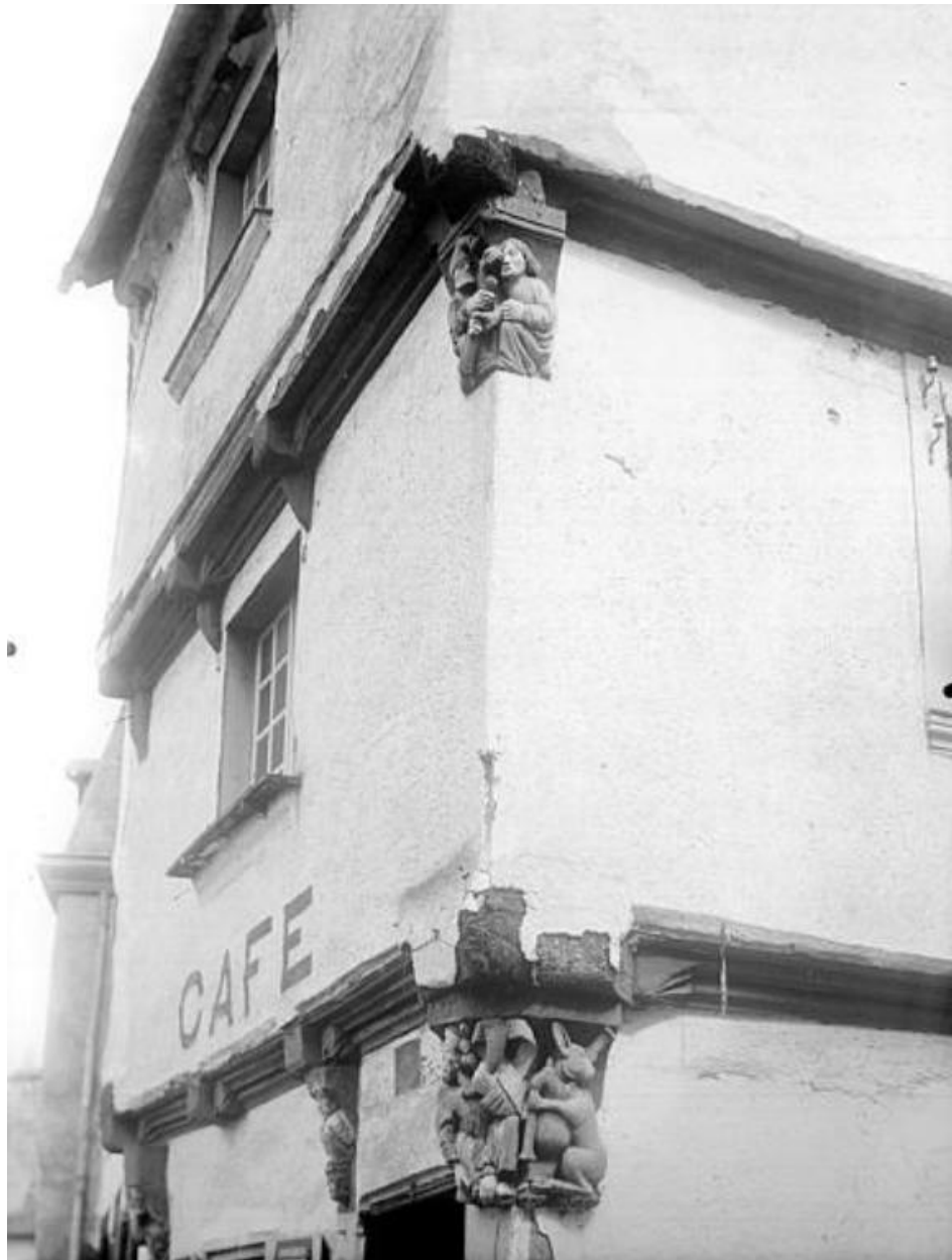
Angle sud-ouest, 1er étage (état avant 1919)
