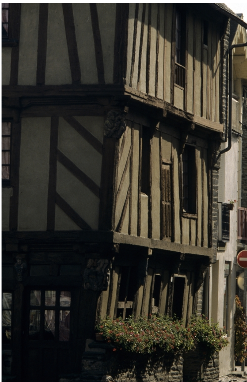
Elévation sud-ouest (état en 1985)
