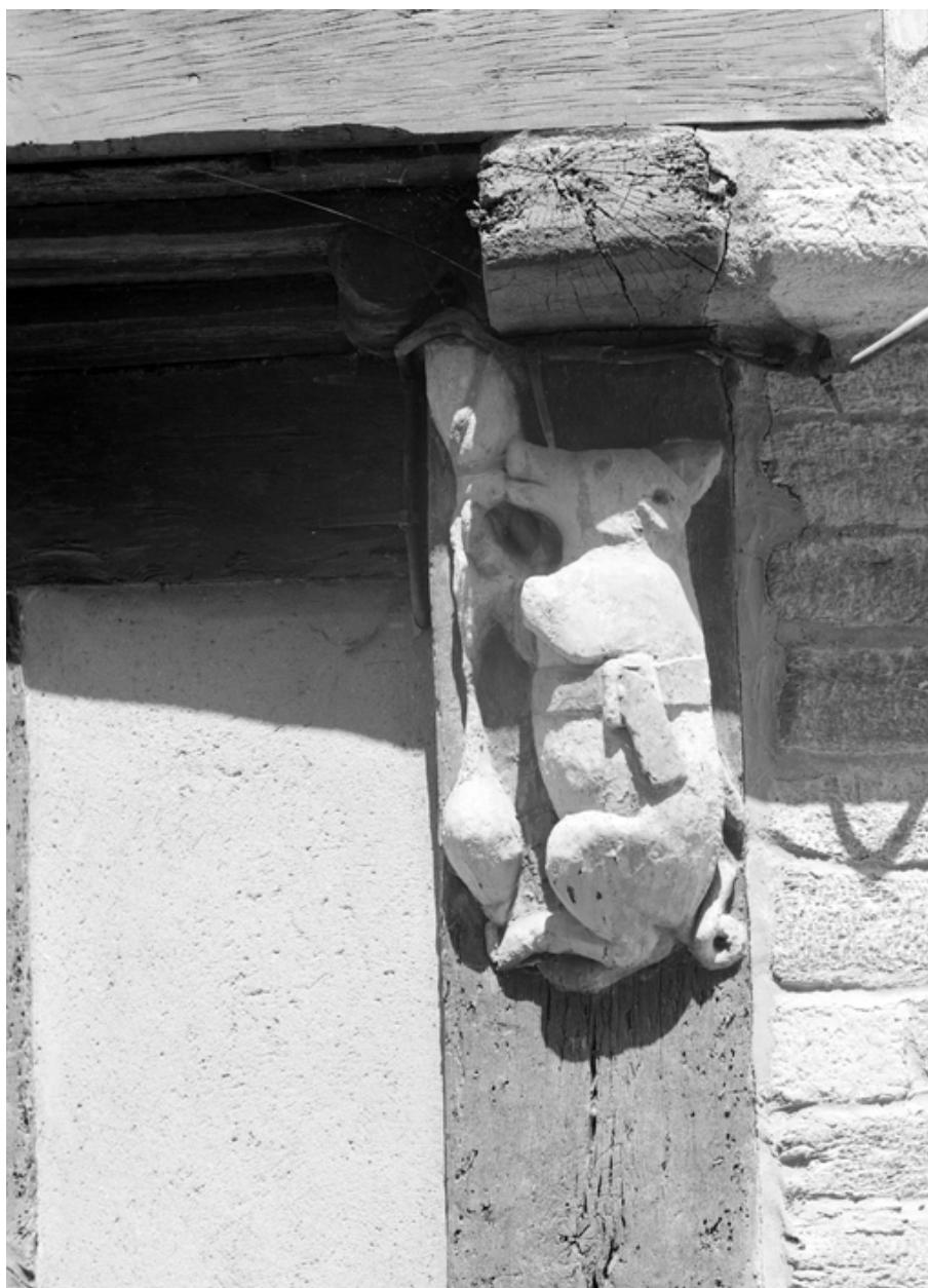
Elévation sud, rez-de-chaussée, décor du poteau d'huisserie : la truie qui file (état en 1984)
