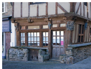
Elévation ouest, rez-de- chaussée (état en 2012) Phot. Bernard Bègne IVR53_20125601223NUCA
