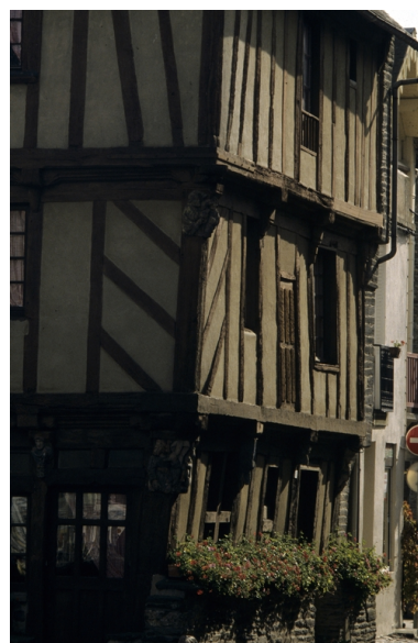
Elévation sud-ouest (état en 1985) Phot. Guy Artur, Phot. Norbert Lambart IVR53_19855600533ZA
