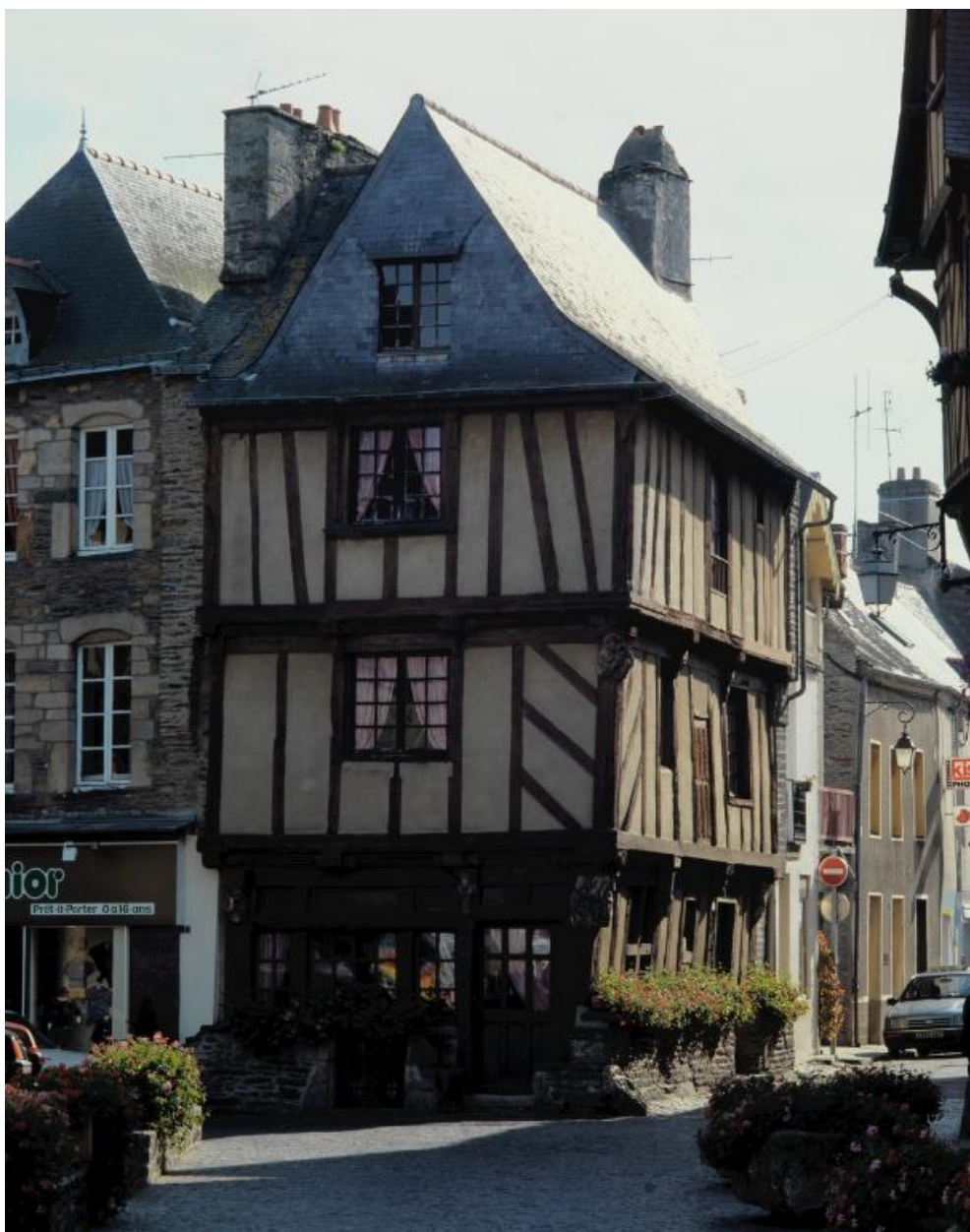
Vue générale prise du sud-ouest (état en 1988)
