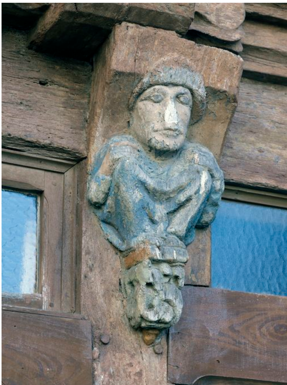
Elévation ouest, rez-de-chaussée, décor du poteau d'huisserie : homme accroupi (état en 2012)
