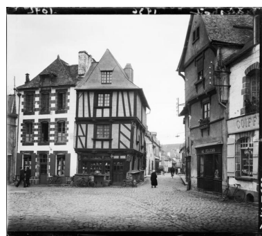
Elévation ouest (état en 1936) Phot. Henri Deneux IVR53_20155606018NUCB
