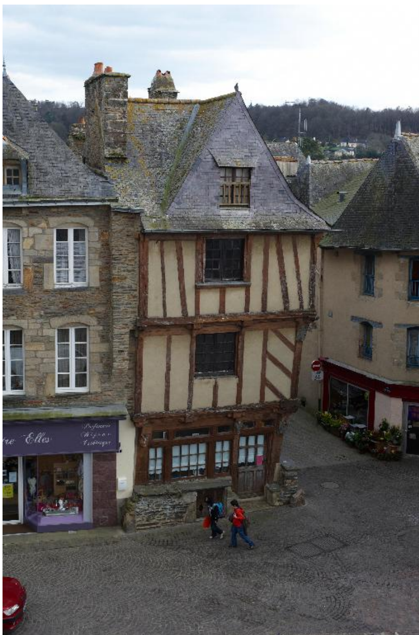
Elévation ouest (état en 2012)
