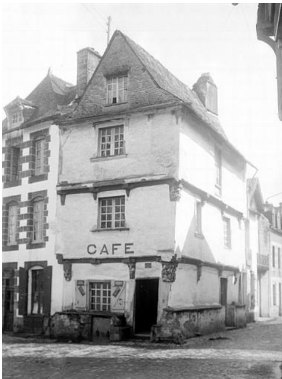
Vue d'ensemble (état en 1921)
