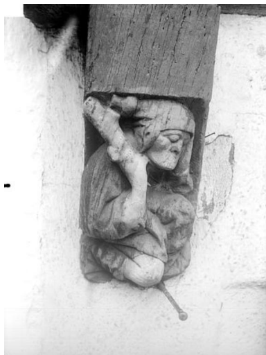
Elévation ouest, rez-de-chaussée, console sculptée : homme endormi au bâton (état avant 1919) Phot. Guernanne IVR53_20155606057NUCB
