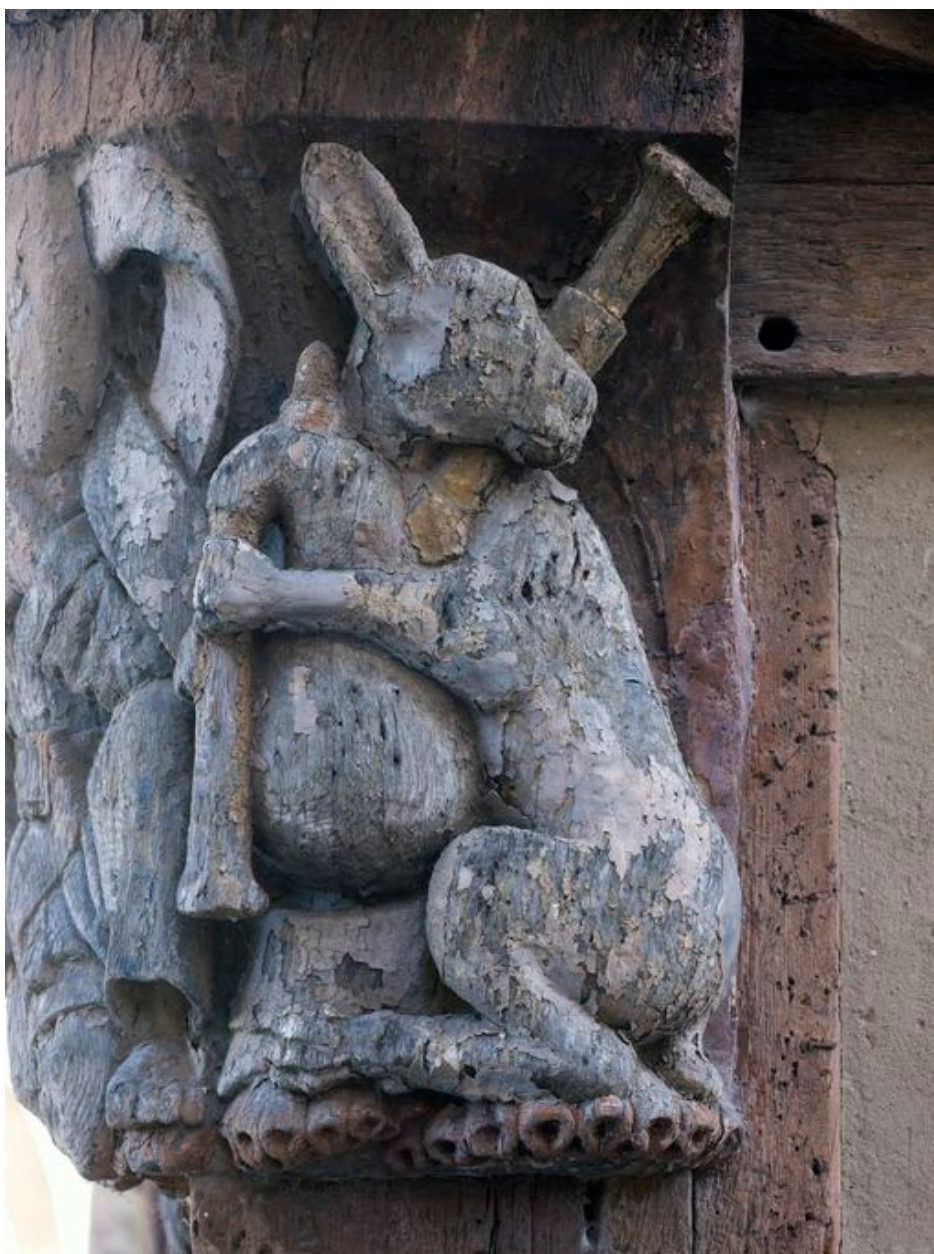
Angle sud-ouest, rez-de-chaussée, décor de l'aisselier du poteau cornier : lièvre jouant de la cornemuse (état en 2012)
