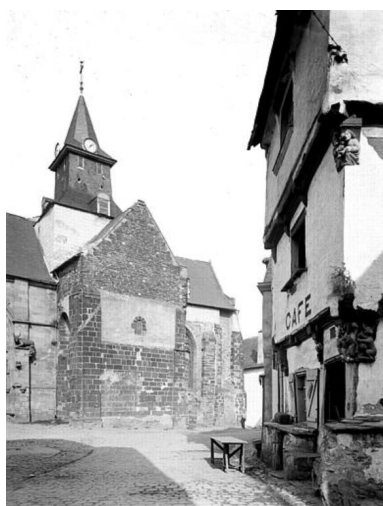
Vue d'un angle de la maison, photo prise avant 1923 par l'historien Eugène Lefèvre-Pontalis Phot. Eugène Lefèvre-Pontalis IVR53_20155606025NUCB
