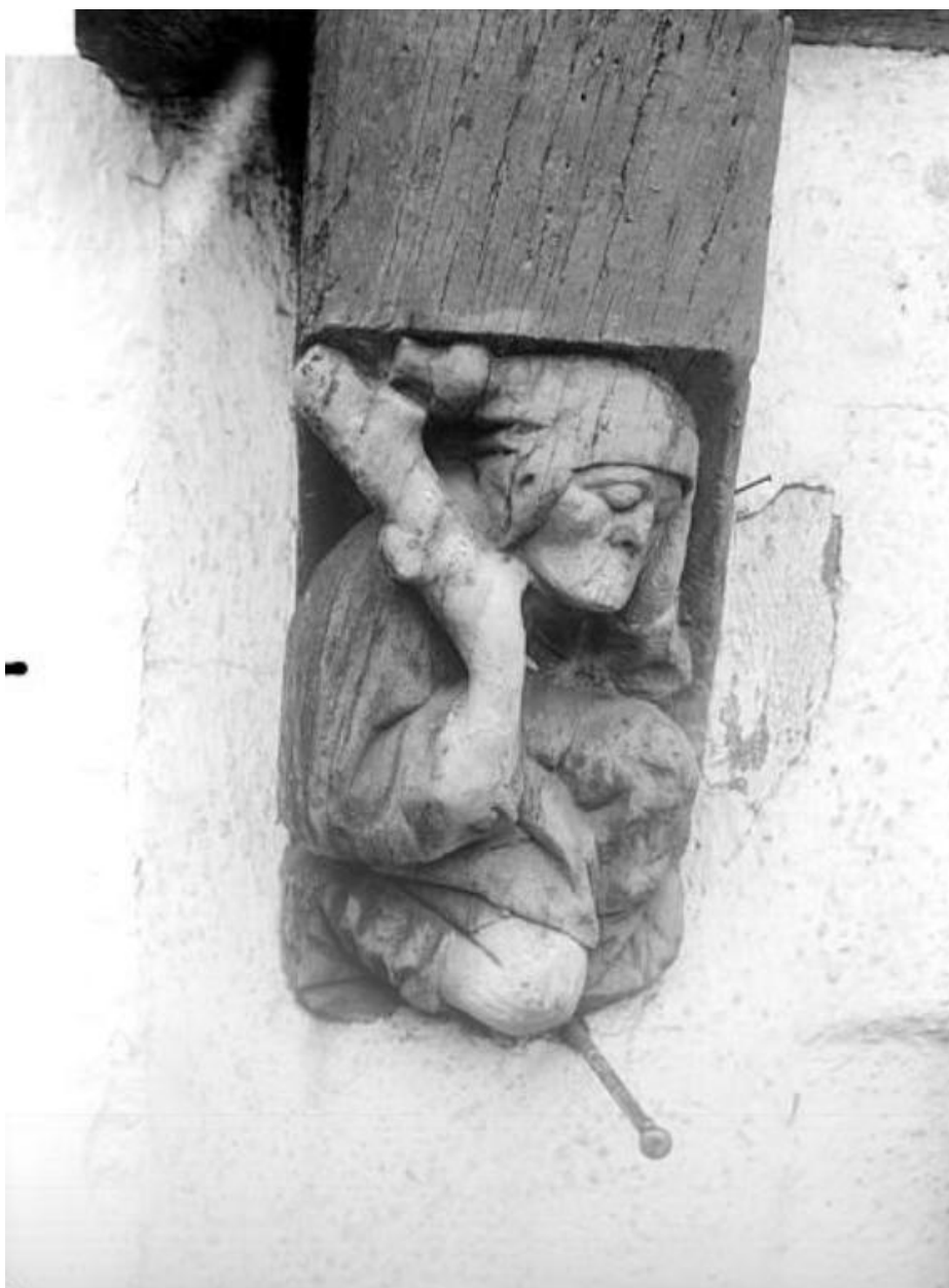
Elévation ouest, rez-de-chaussée, console sculptée : homme endormi au bâton (état avant 1919)
