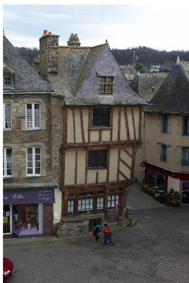
Elévation ouest (état en 2012) Phot. Bernard Bègne IVR53_20125601422NUCA
