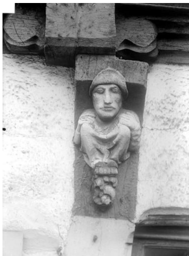
Elévation ouest, rez-de-chaussée, console sculptée : homme accroupi (état avant 1919) Phot. Guernanne IVR53_20155606055NUCB
