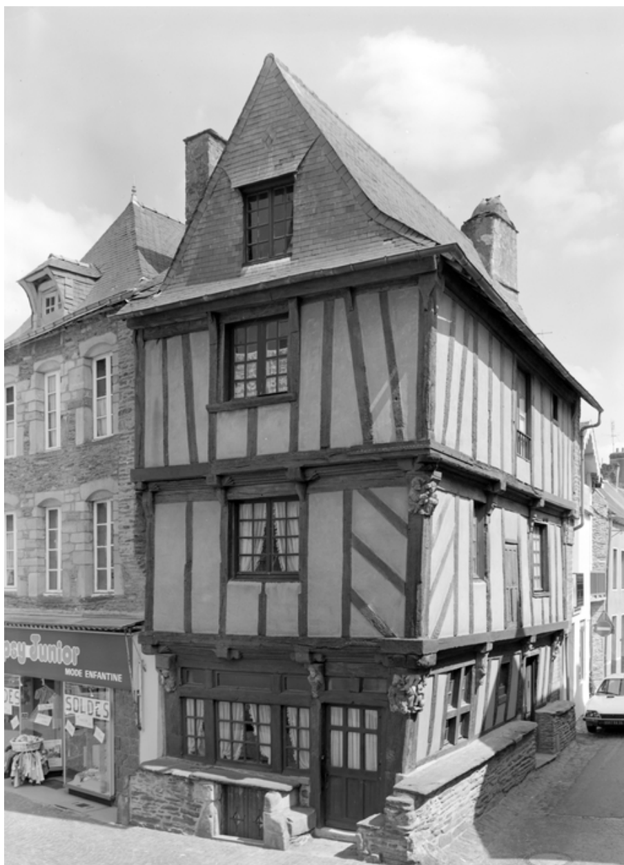
Vue prise du sud-ouest (état en 1984)
