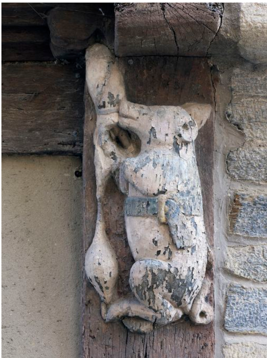
Elévation sud, rez-de-chaussée, décor du poteau d'huissier : la truie qui file (état en 2012)
