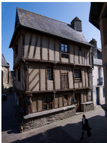
Elévation sud (état en 2011) Phot. Bernard Bègne IVR53_20115600434NUCA
