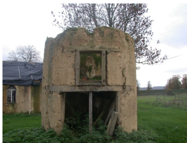
Le colombier, vestiges Phot. Guillaume Lécueillier IVR53_20033515354NUCA
