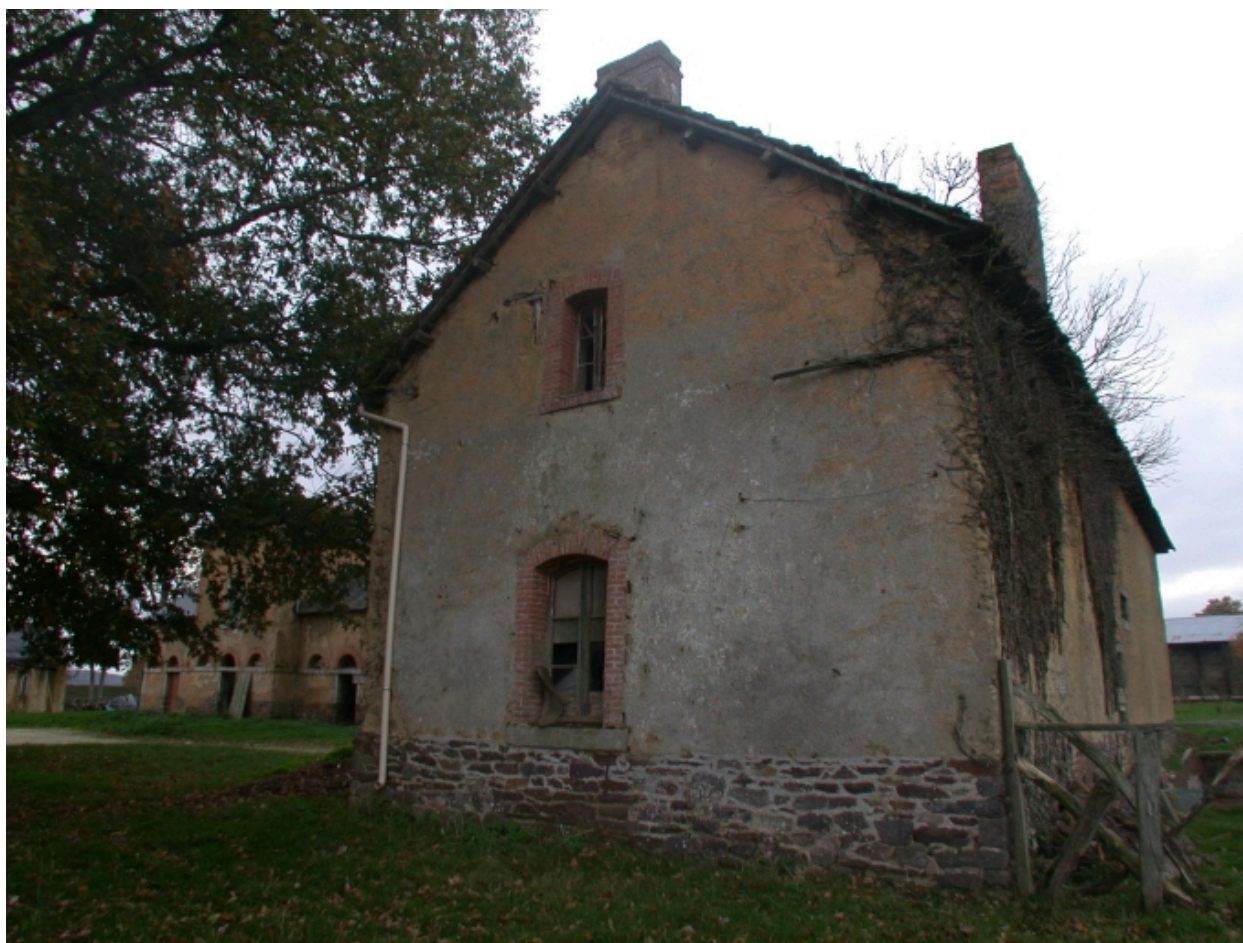
Logement accolé à la remise, vue du pignon
