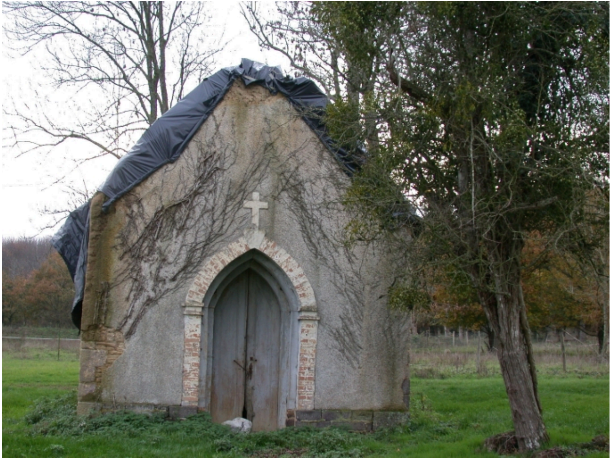
Vue d'ensemble de la chapelle
