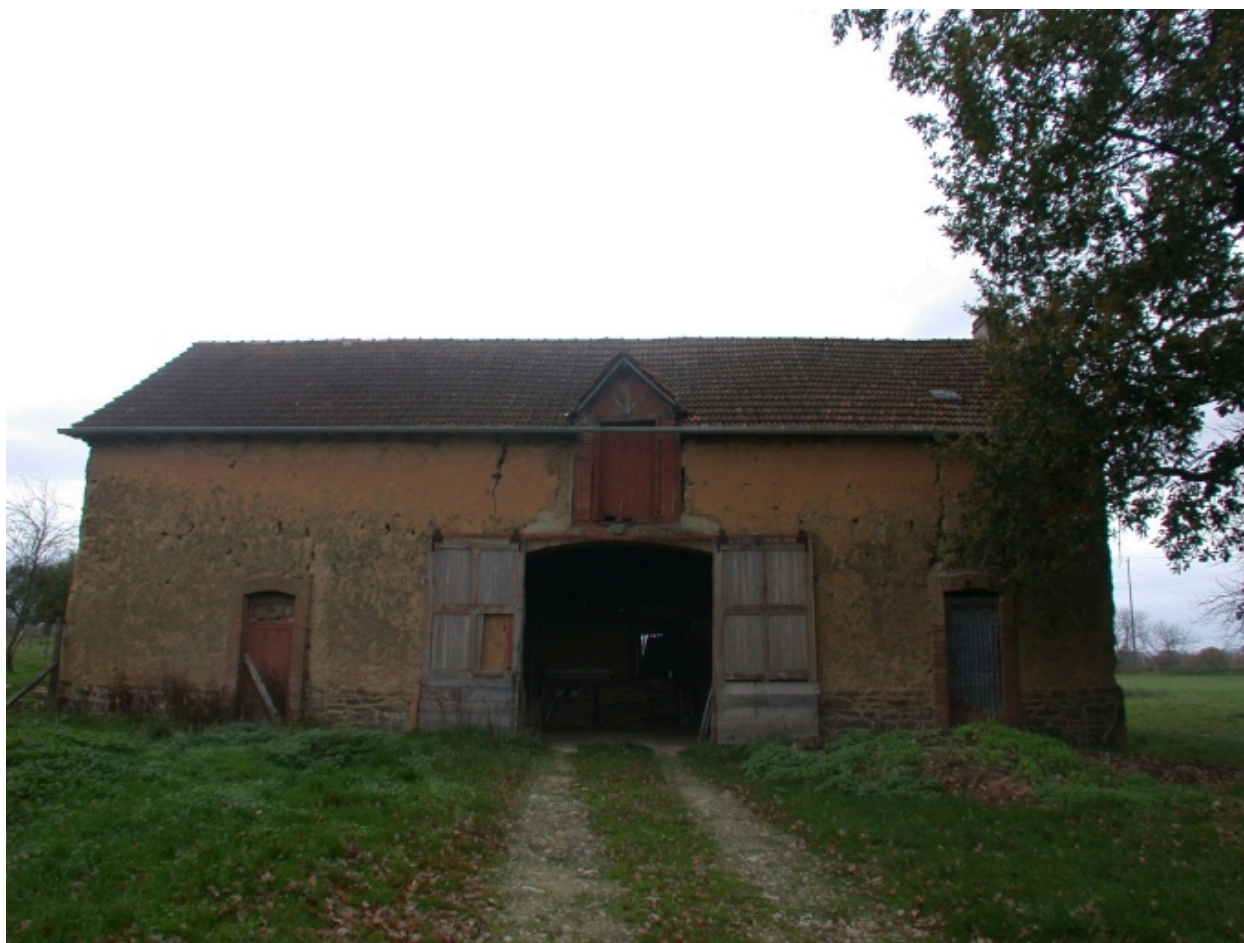
Remise et logement
