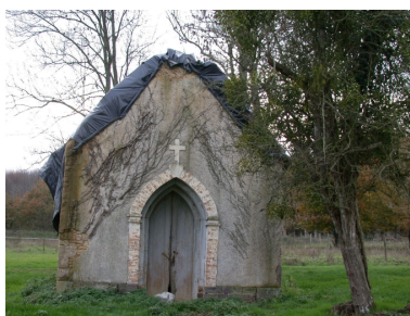
Vue d'ensemble de la chapelle Phot. Guillaume Lécueillier IVR53_20033515350NUCA
