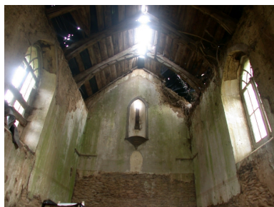
La chapelle, vue intérieure Phot. Guillaume Lécueillier IVR53_20033515353NUCA
