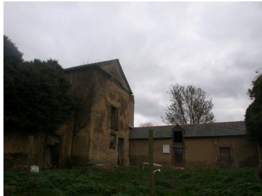
Les communs, vue générale arrière Phot. Guillaume Lécueillier IVR53_20033515358NUCA
