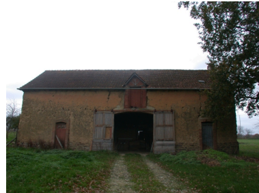
Remise et logement Phot. Guillaume Lécueillier IVR53_20033515356NUCA
