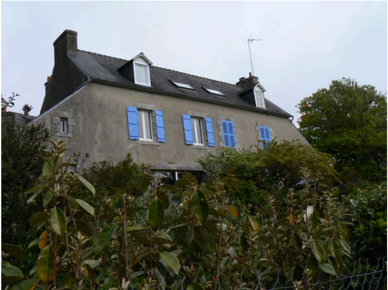
Partie supérieure de la maison Joseph Tonnerre
