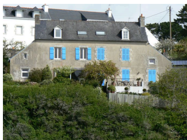
Façade de la maison 'Joseph Tonnerre', côté ria Phot. Julien Amghar IVR53_20082908703NUCA
