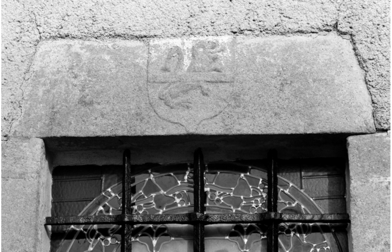
Elévation Sud, baies : détail du linteau aux armes des Henry
