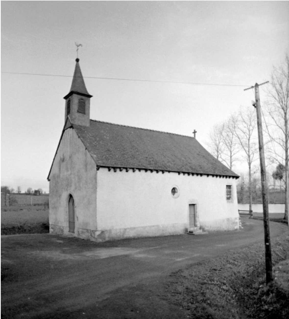
Elévation Sud-Ouest : vue générale
