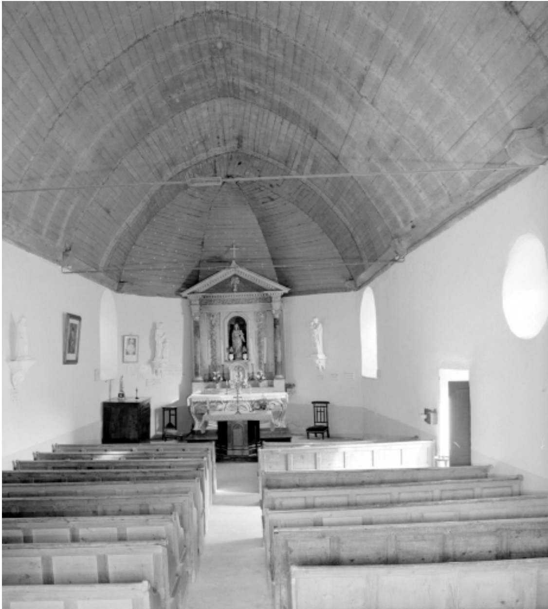
Intérieur : vue générale vers le chœur
