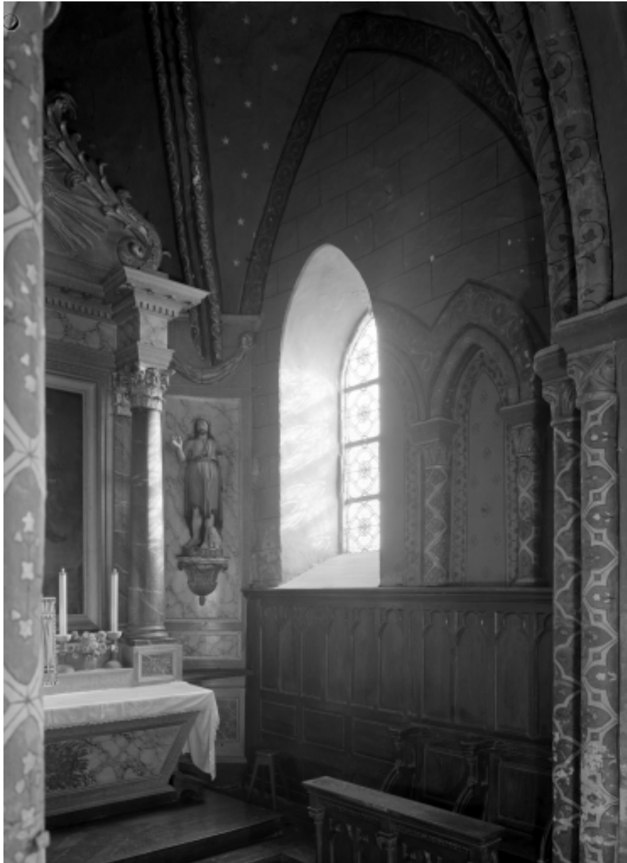
Choeur, mur sud, vue générale.
