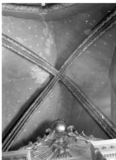
Voûte du choeur, vue générale. Phot. Guy Artur, Phot. Norbert Lambart IVR53_19843500239V
