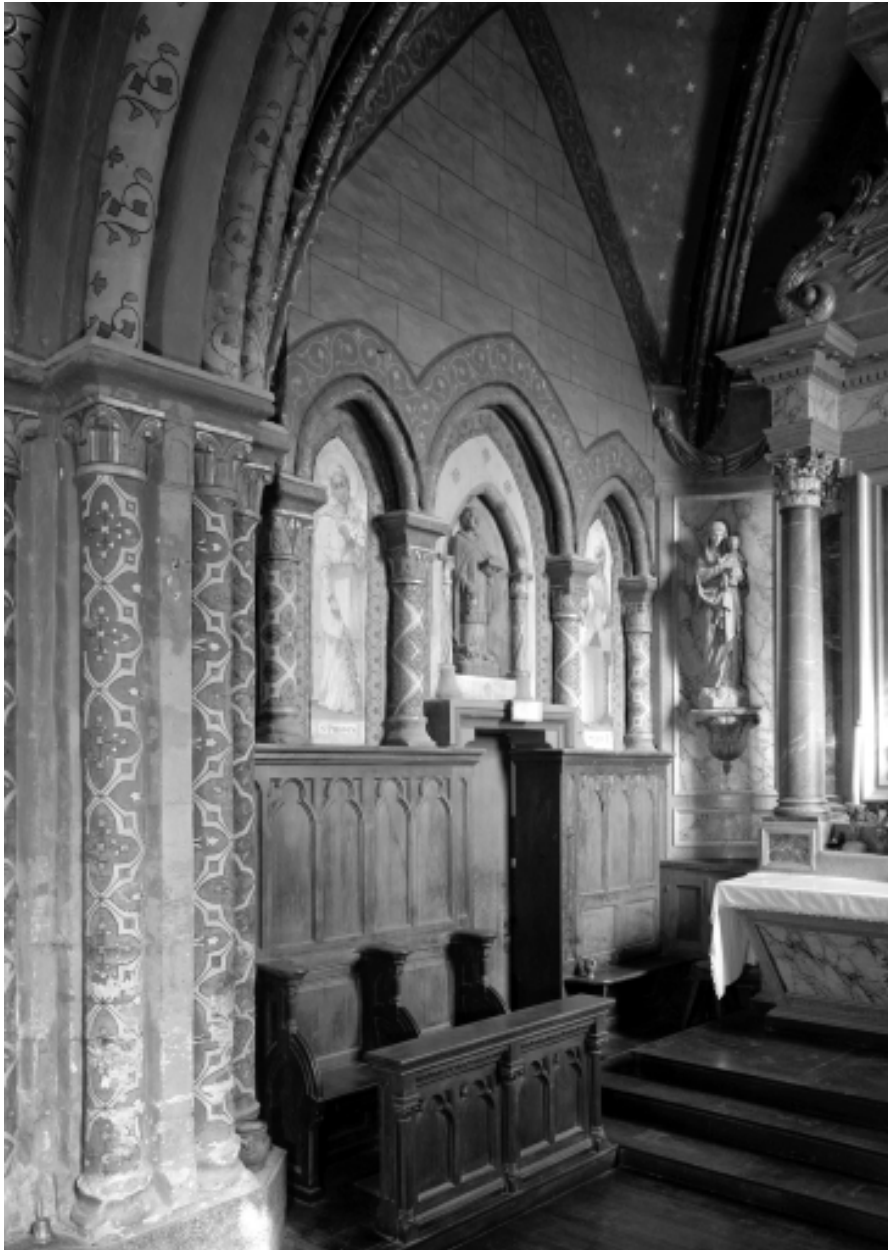
Choeur, mur nord, vue générale.
