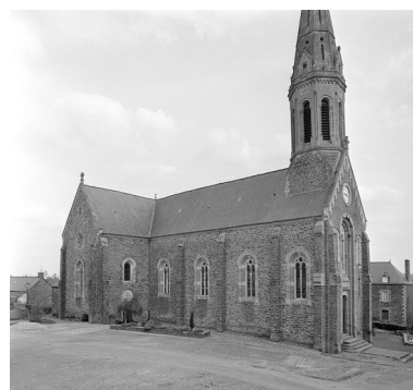
Vue générale nord-ouest Phot. Guy Artur, Phot. Norbert Lambart IVR53_19943500851X
