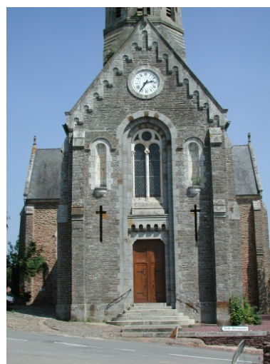
Vue partielle ouest Phot. Claude Quillivic IVR53_20023509009NUCA
