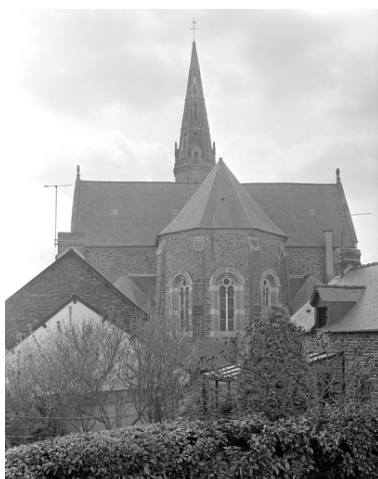
Vue générale est Phot. Guy Artur, Phot. Norbert Lambart IVR53_19943500850X
