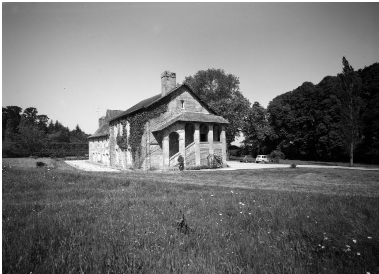
Vue de situation sud-est
