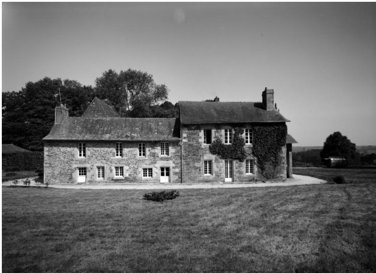
Vue générale de la façade sud
