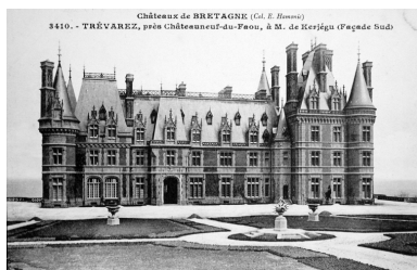
Vue de la façade principale (Archives départementales d'Ille- et-Vilaine, 6 Fi Saint-Goazec) Phot. Elise Lauranceau, Autr. Emile Hamonic IVR53_20042905600NUCB
