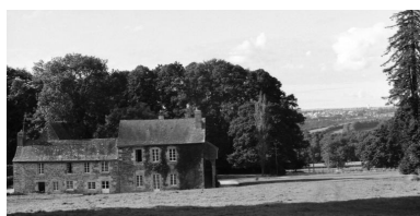
Manoir, façade sud, vue générale Phot. Yves-Pascal Castel IVR53_19722901624Z
