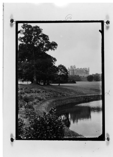
Reproduction - Vue de situation prise du nord-est (Archives départementales du Finistère) Repro. Guy Artur IVR53_19702900121V
