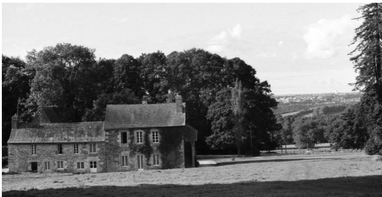
Manoir, façade sud, vue générale
