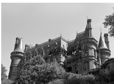
Vue générale nord Phot. François Dagorn IVR53_19732900080X
